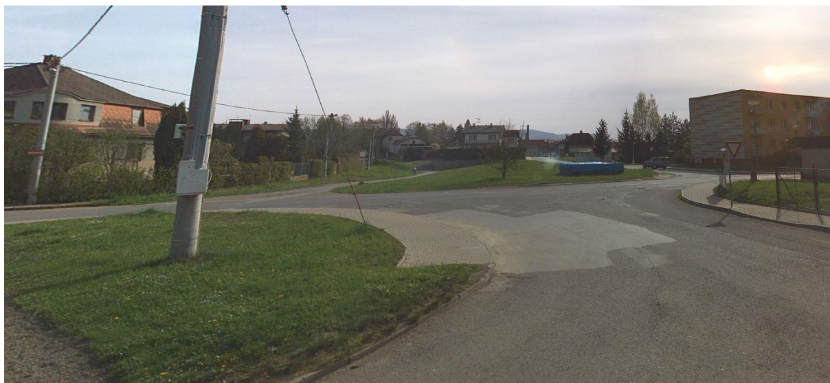
12. Pohled na křižovatku ulice U Vodojemu a ulice Větrná
