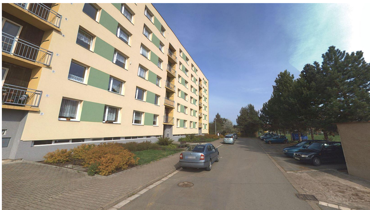
1. Pohled na konec ulice U Větrolamu
