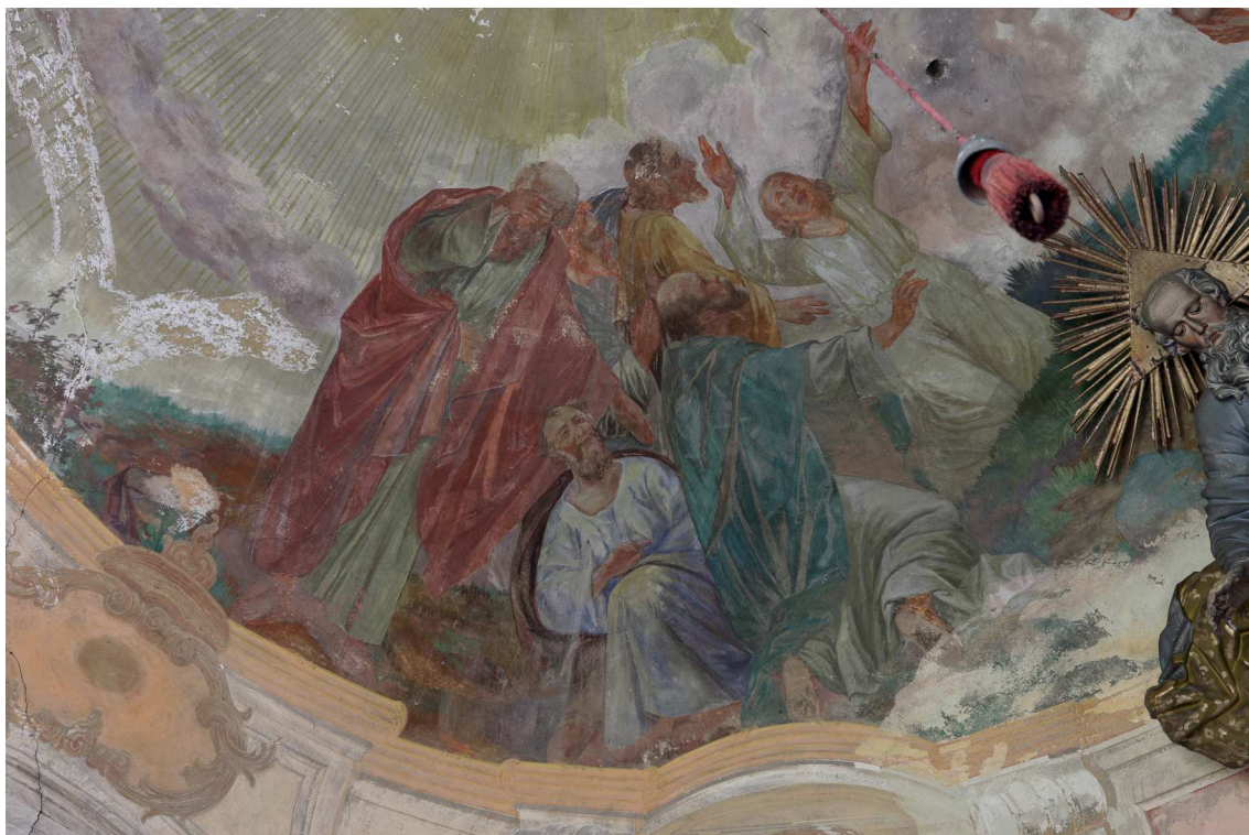
Obr. 72 Stav pred reštaurátorským zásahom. Ide o figurálnu skupinu šiestich postáv na ľavej polovici nástropnej maľby. Viditeľné poškodenia premaľby ako aj neodborný zásah čistenia povrchu premaľby na ľavej skupine figúr, jedná sa o lokálne miesto v spodnej polovici svetlomodrej kľáčiacej postavy
