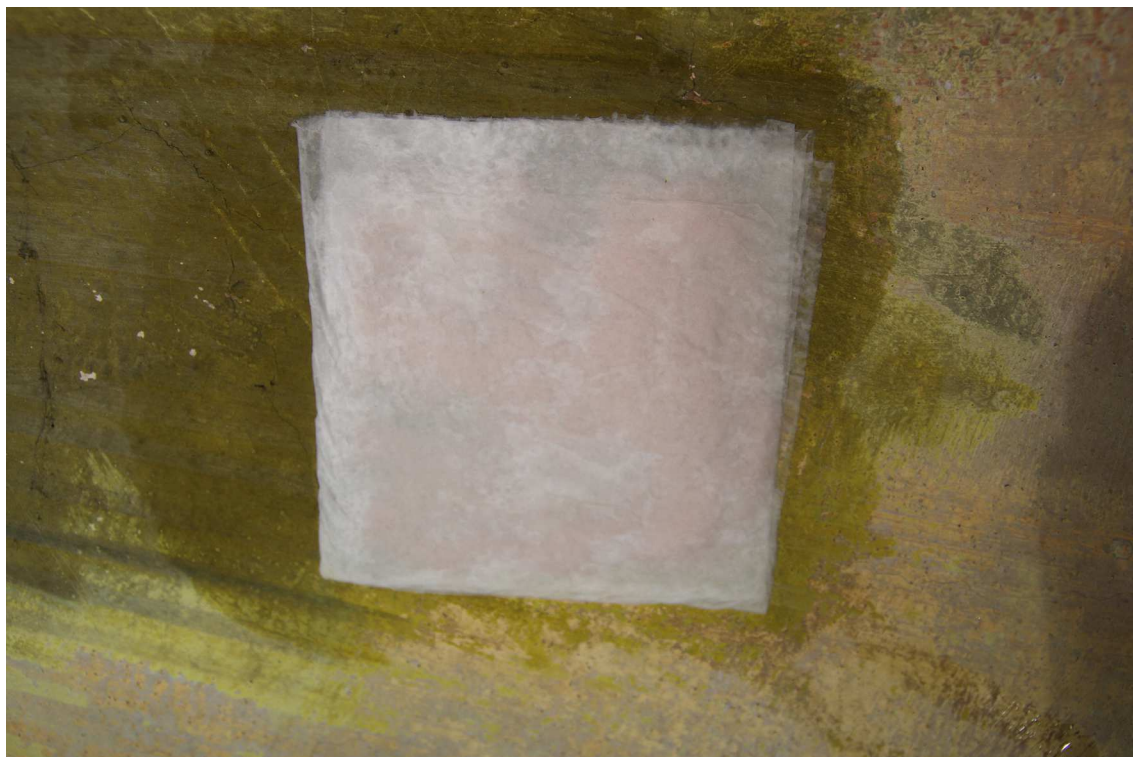
Obr.30 Prekrytie iontomeniča Amberjet 4400 OH buničinou (papierové utierky), ktorá bola prevlhčovaná vodou v 15 minútovom pôsobení. Stav v priebehu odstraňovania premaľby z 19. storočia.
