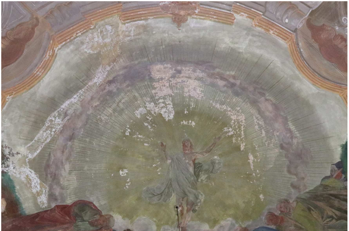
Obr. 78 Stav pred reštaurátorským zásahom. Horná polovica nástropnej maľby. Na tomto obrázku je viditeľné najväčšie poškodenie puchierovatením, ktoré sa nachádzalo práve v oblasti neba. Ježiš Kristus ako centrálna figúra na nástropnej maľbe vďaka alterácii pigmentov pôsobí tmavo a nevýrazne a s pozadím skoro splýva.
