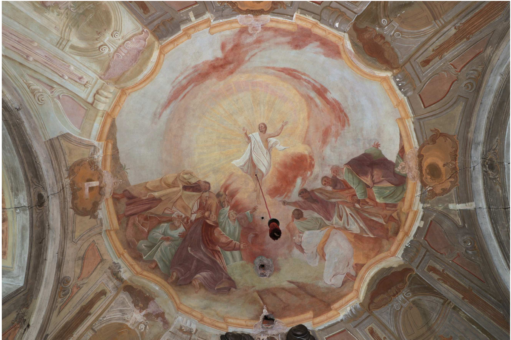
Obr. 84 Stav po retušování. Celkový pohľad na nástrojnú maľbu
