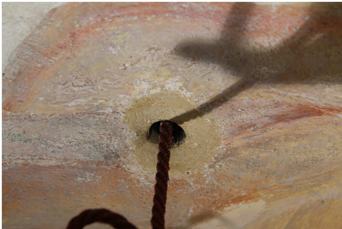
Obr.50 Odstránený tmel sádrového typu a nahradený vápenno pieskovým tmelom, povrchovo upraveným pomocou filcovania. Stav po odstránení premaľby z 19. storočia.
