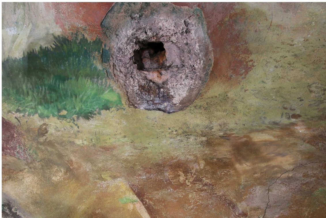
Obr. 16 Chýbajúca omietková vrstva na klenbe. V jej strede sa nachádza otvor do podkrovia kaplnky, cez ktorý bola istená drevená plastika polpostavi Boha Otca. Na chýbajúcej omietke je viditeľný nános farebnej vrstvy z premaľby. To preukazuje, že toto poškodenie bolo spôsobené ešte pred nanosením premaľby z 19. storočia. Stav v priebehu odstraňovania premaľby z 19. storočia.
