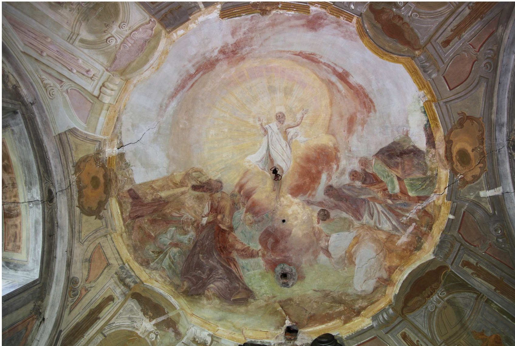
Obr.47 Celkový pohľad na nástropnu maľbu po odstránení premaľby z 19. storočia a druhotných vrstiev.
