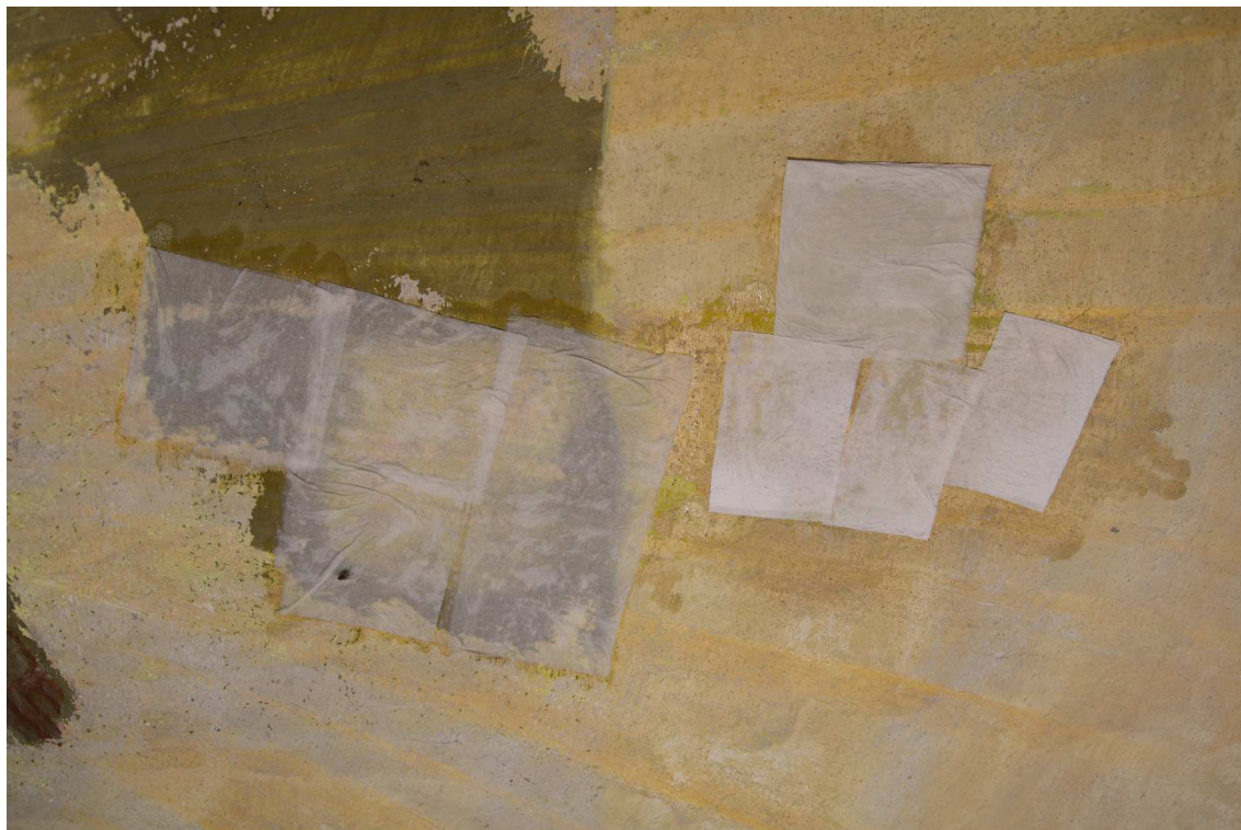
Obr. 27 Použitie zábalu buničiny s vodou pri odstraňovaní premaľby z 19. storočia.
