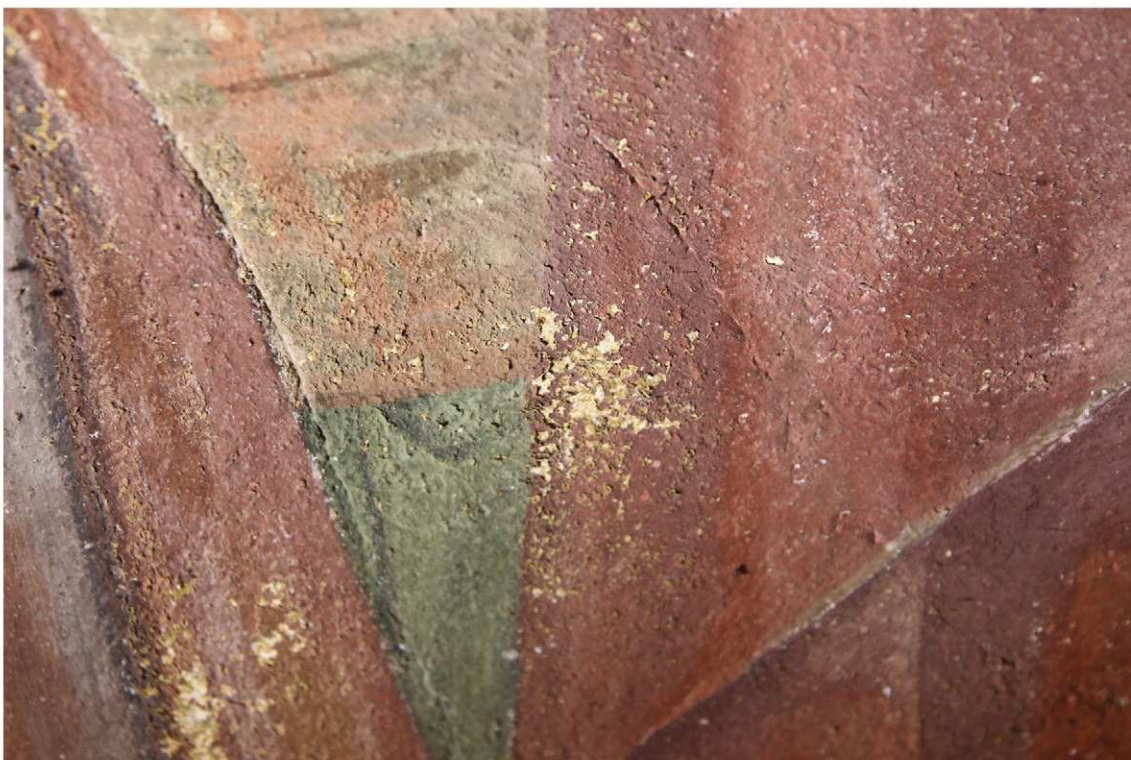
Stav přemalby na vybraných místech - detaily puchýřovitění a zpráškovatění.
