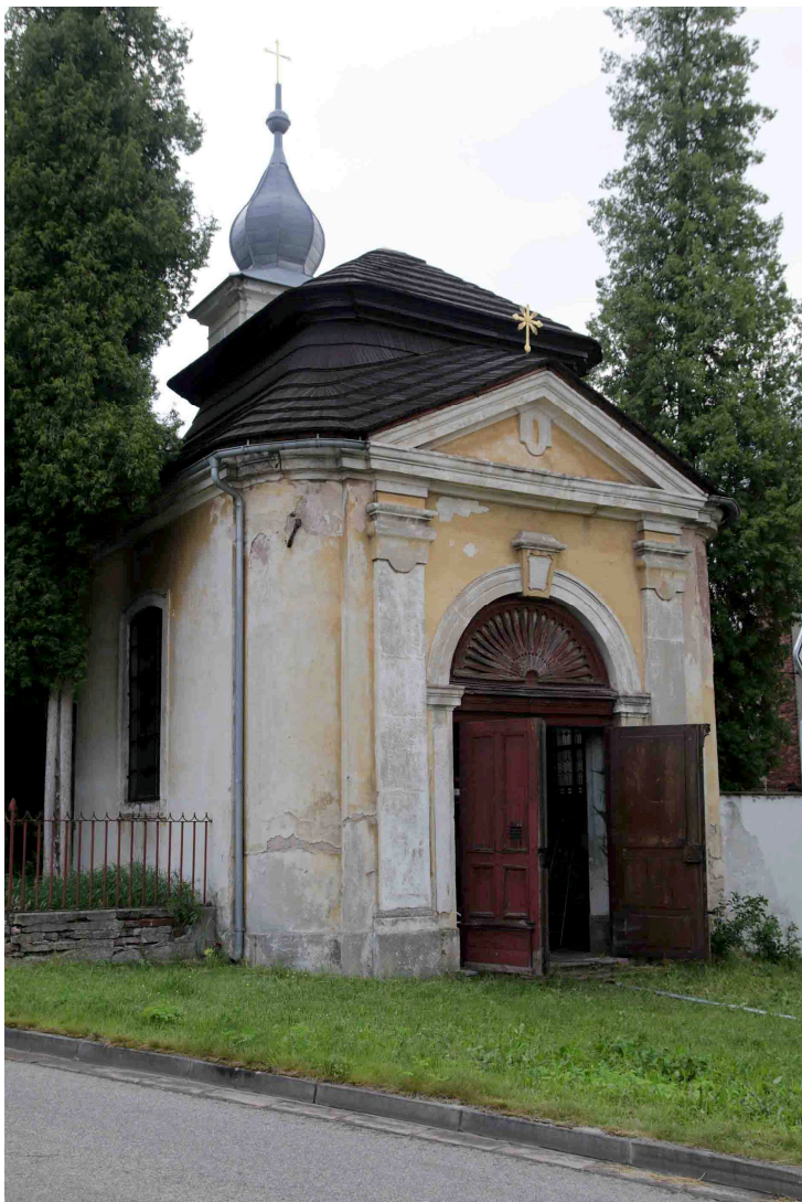
Obr. 11: Kaple Bolestné Panny Marie – exteriér. Stav před restaurováním.
