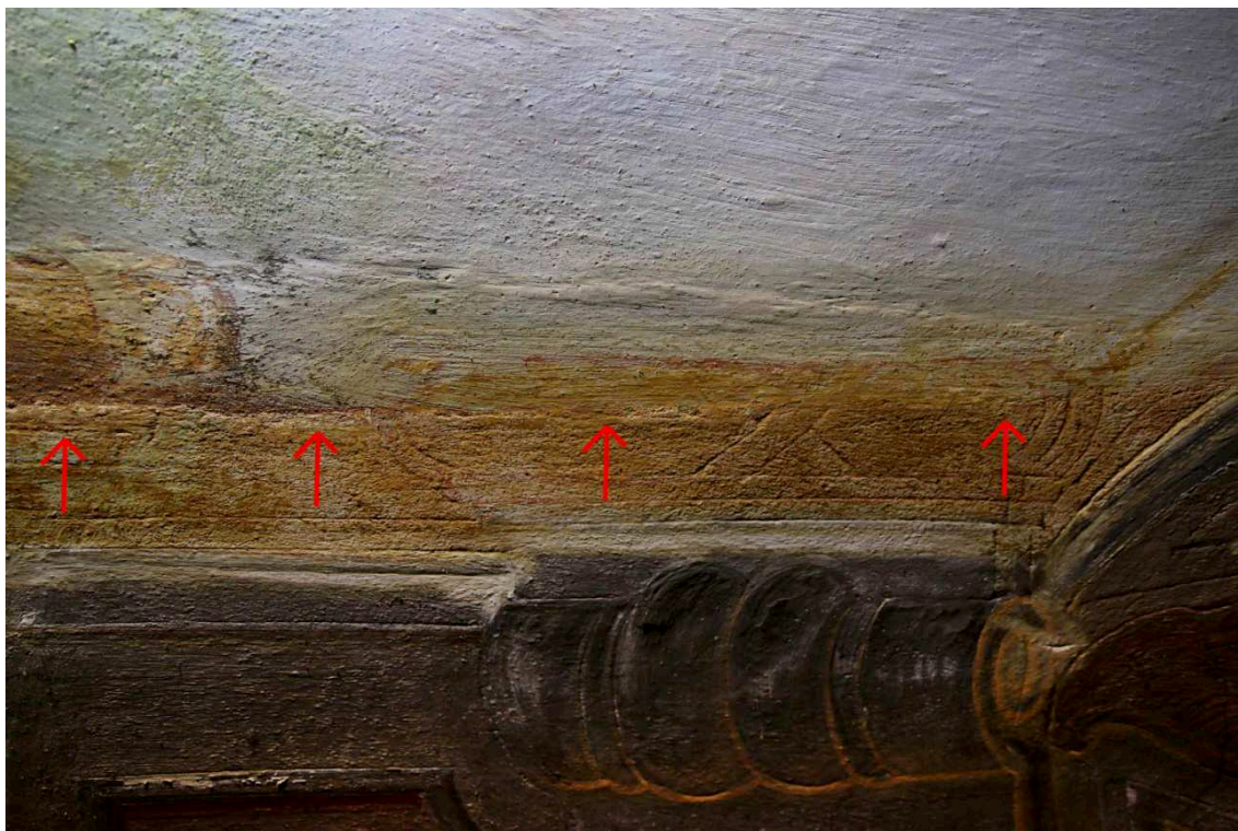
Obr. 63: Vizuální průzkum v ostrém bočním nasvícení v oblasti iluzivní okrové římsy, kde byla taktéž pozorován rytá kresba, podle které byla provedena rekonstrukce římsy. V této oblasti bylo taktéž patrné rozhraní denních dřív mezi figurálním výjevem v klenbě a iluzivní architekturou na stěnách kaple (rozhraní je označeno červenými šipkami).
