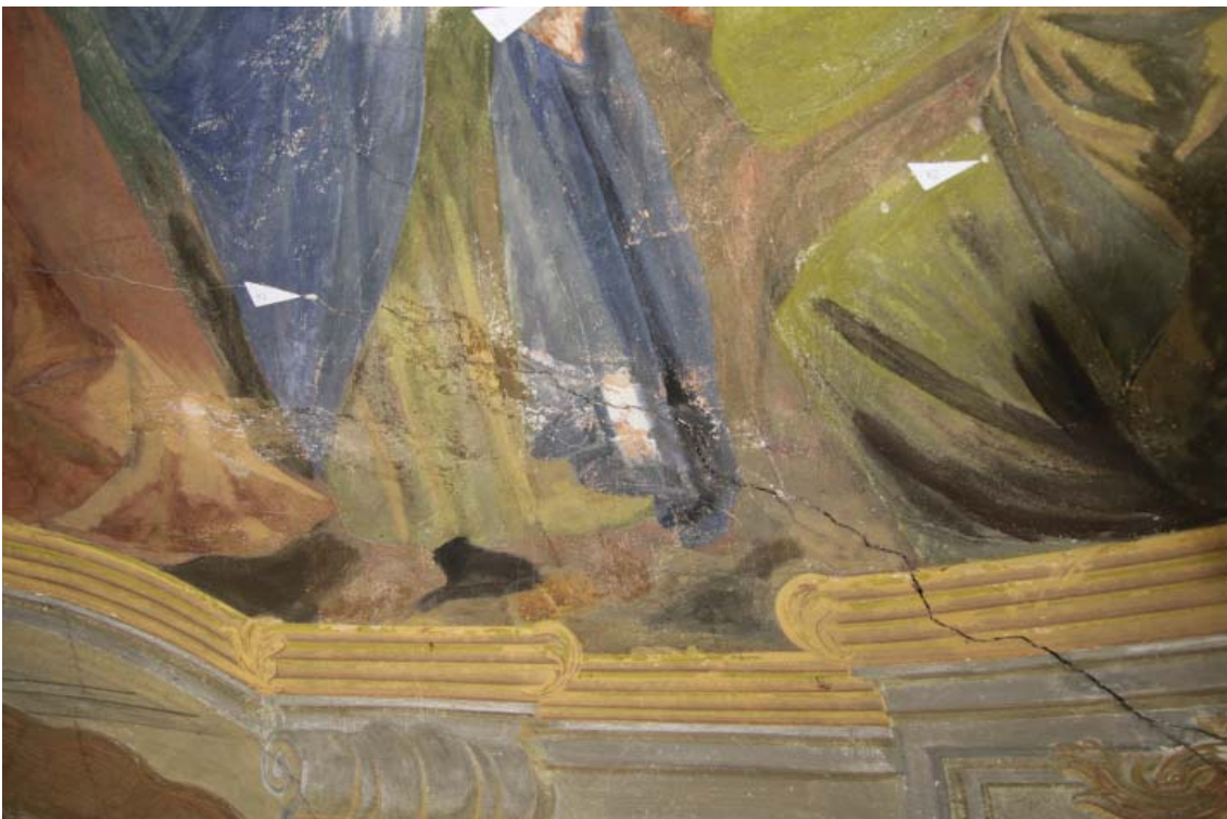
Sondy - odstranění přemalob z figurální kompozice - v sondách patrné barokní malby,. Lokalizace odebraných vzorků. Dole - okolo praskliny je pod přemalbou bílý tmel statické trhliny, barokní malba až pod ním.
