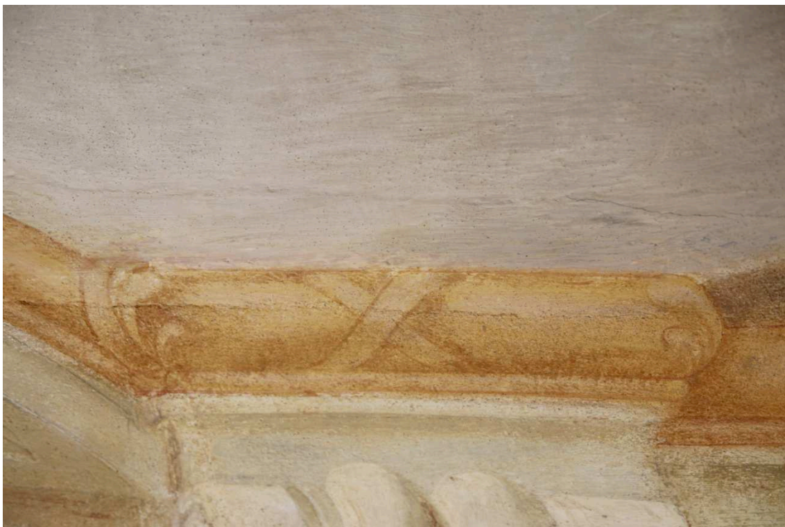
Obr. 94: Detail římsy. Stav po restaurování.
