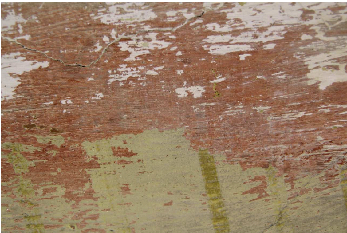
Obr. 43: V průběhu odkryvu originální barokní malby byla pozorována přítomnost bílých tmelů v trhlinách a jejich okolí. Tyto těžko odstranitelné tmely byly redukovány pomocí zábalů z buničiny s iontoměničem Amberlitem OH působícího cca 15 minut a posléze zcela odstraněny mechanicky skalpelem.
