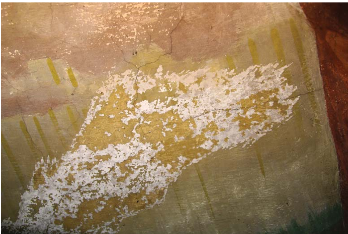
Stav přemalby na vybraných místech - detaily puchýřovatení a zpráškovatění. Nahoře - pod přemalbou prosvítá barokní malba. Dole - vysprávka trhliny se propisuje na povrch.
