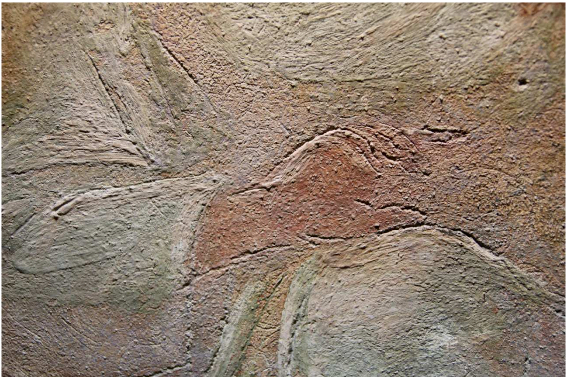
Obr. 65: Vizuální průzkum v ostrém bočním nasvícení po odstranění přemalby z 19. století. Na fotografii je pozorována jak rytá kresba odpovídající malovaným liniím originální barokní malby, tak rozdílná struktura povrchu v oblastech světel a stínů. V oblasti světel je patrný pastózní nános barvy, naopak ve stínech, kde se barevná vrstva nezachovala, je pozorována hrubá struktura omítky.
