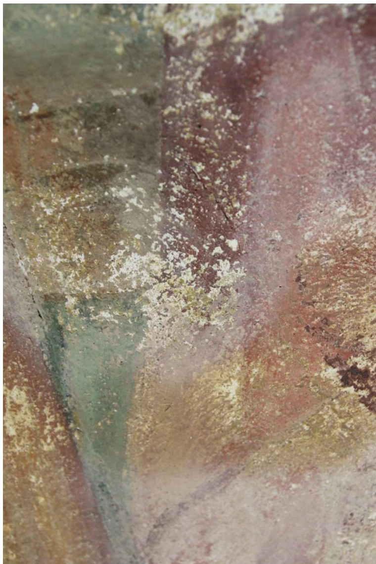
Obr. 56: Detail zpráškovatěné barevné vrstvy 19. století, pod kterou se nachází též zpráškovatěná okrová barokní malba.
