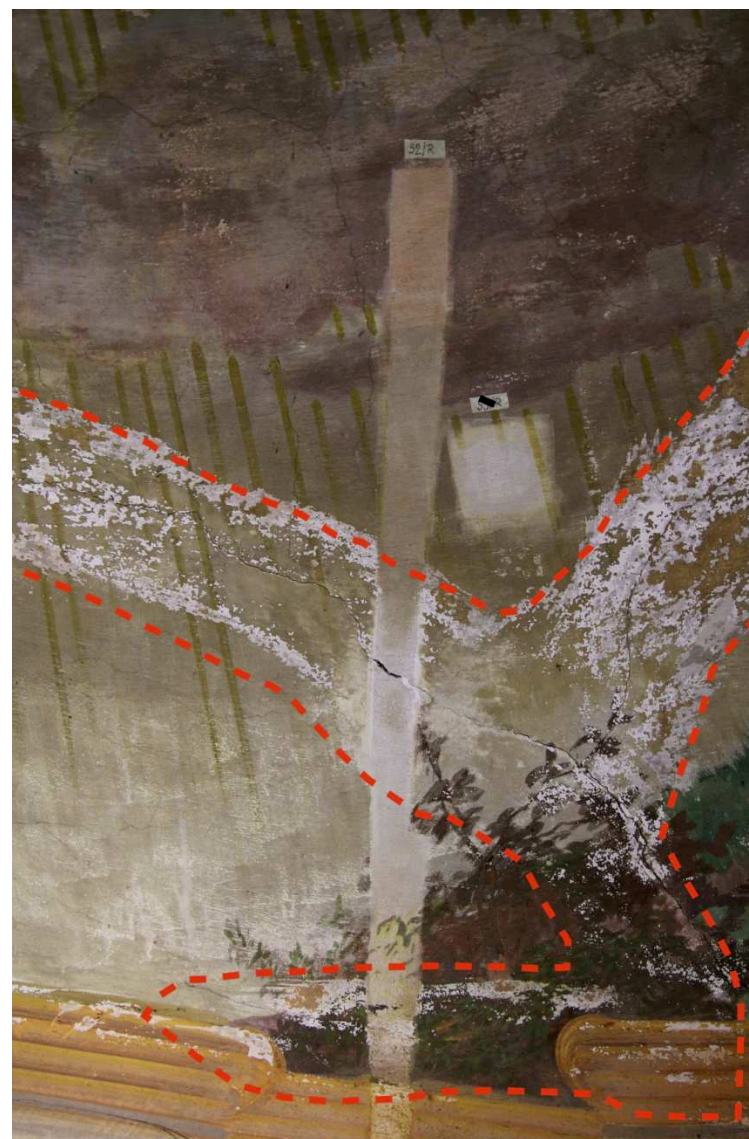
Obr. 29: Pásové orientační sondy na barokní vrstvu v oblasti nebe, kde je červeně vyznačena oblast sádrových tmelů.
