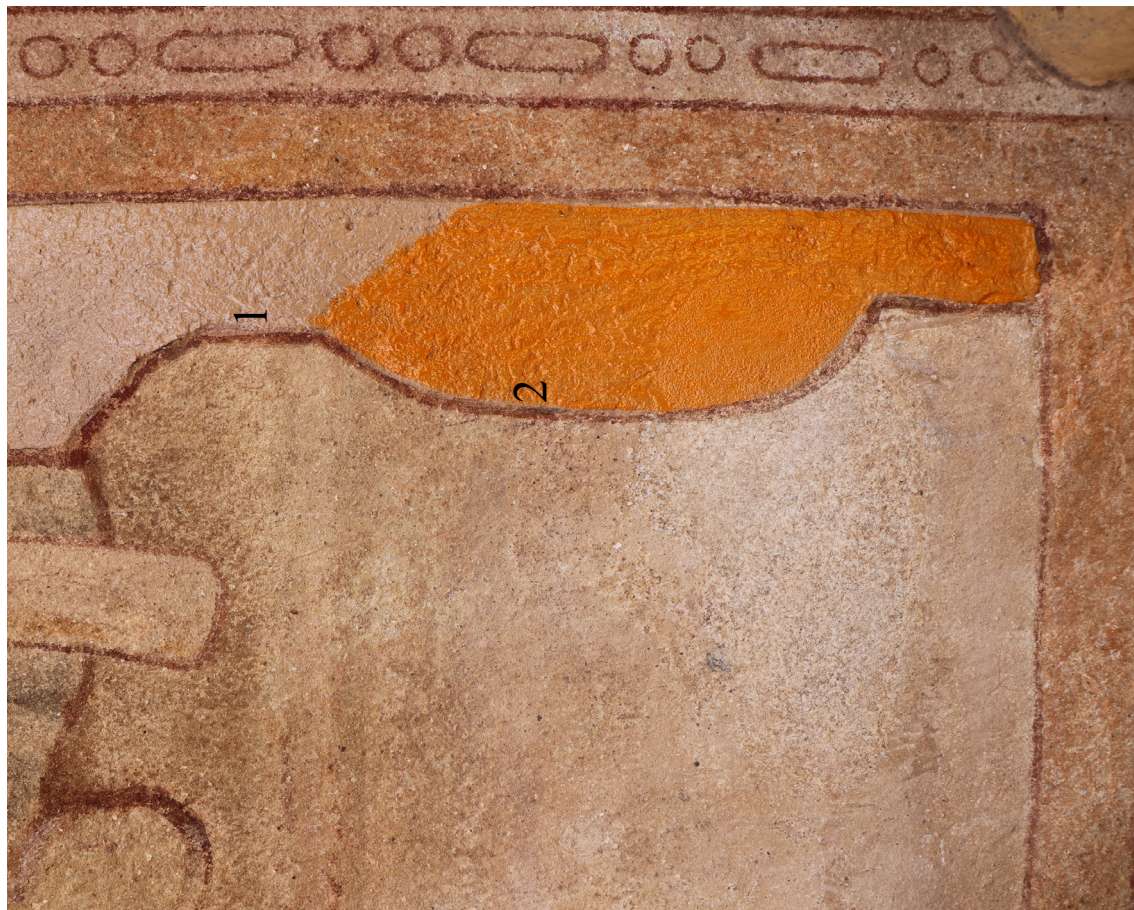
Obr. 39: Podklady pod zlátenie: 1 - monochrómny náter v pieskovej farbe - Eternal; 2- trojhodinový mixtiónový podklad pod zlato.
