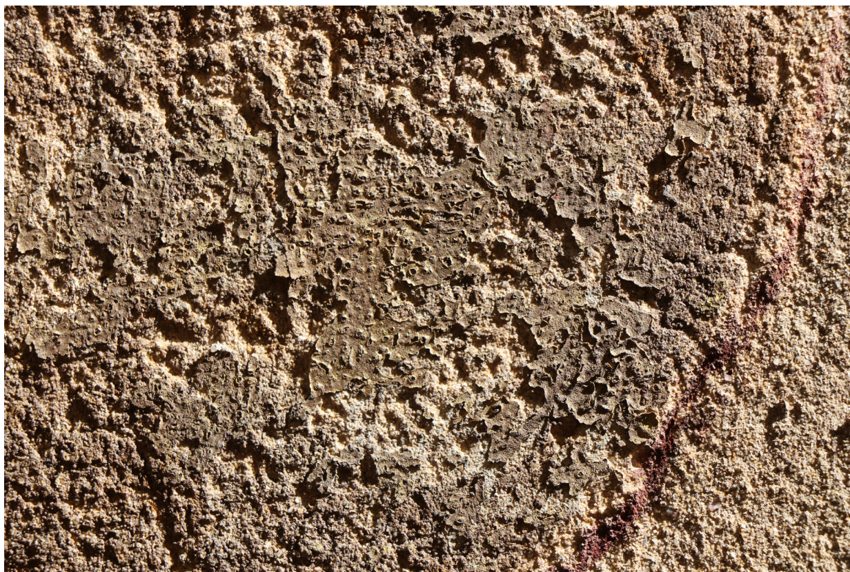
Obr. 25: Detail časti zláteného pozadia sv. Vojtecha - nad ramenom, v ostrom bočnom svetle pred reštaurovaním. V bočnom svetle vynikla hrubá štruktúra omietky a degradácia kovovej úpravy, ktorá sa zachovala len na vrškoch omietky. Kov sa od povrchu zdvíha v šupinách.
