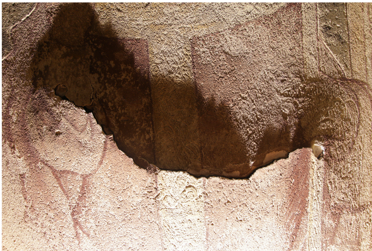
Obr. 21: Maľba rúk a trupu sv. Vojtecha, v ostrom bočnom svetle pred reštaurovaním. Svetlo zvýraznilo výškový rozdiel hranice praskliny zapôsobenou medziometkovou dutinou. Zvýraznilo sa tiež štruktúrne poškodenie omietky tzv. alveolizáciou.
