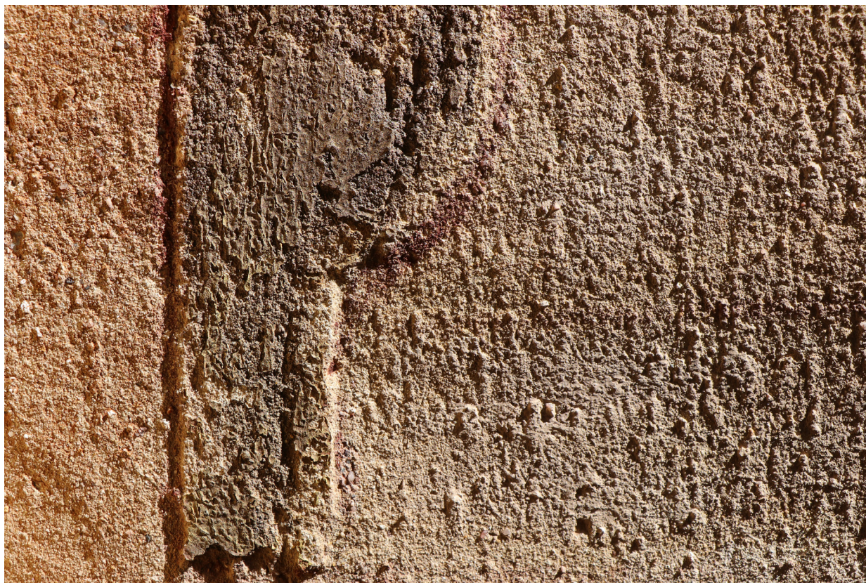
Obr. 22: Detail spodnej časti maľby sv. Vojtecha - sokel, v ostrom bočnom svetle pred reštaurovaním. Svetlo dalo vyniknúť hrubej štruktúre omietky, poškodenou vymytím (vertikálnejší stopa degradácie). Tiež vystúpila časť zláteného pozadia, ktorá vystupuje nad rovinu okolitej omietky (najväčší odskoku cca 0,4 mm).
