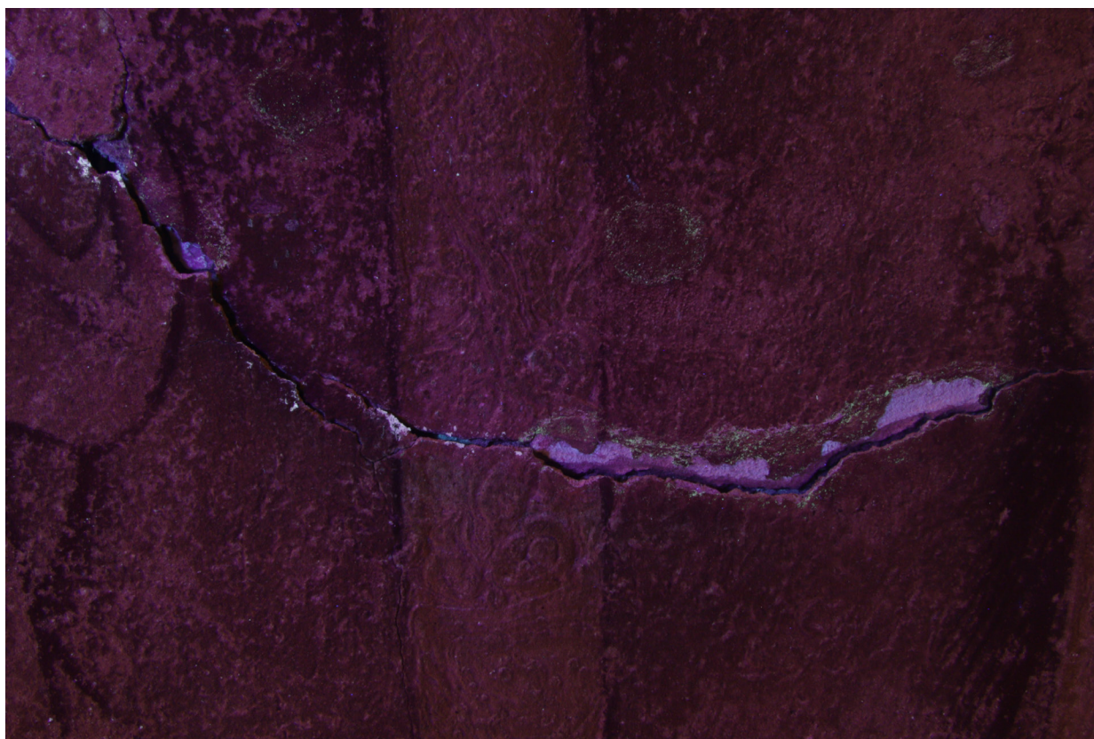
Obr. 28: Časť maľby v mieste otvorenej praskliny sv. Vojtecha, pod nasvietením UV lampou, pred reštaurovaním. Modro luminije injektážna výplň a zelene retuše z roku 2001.
