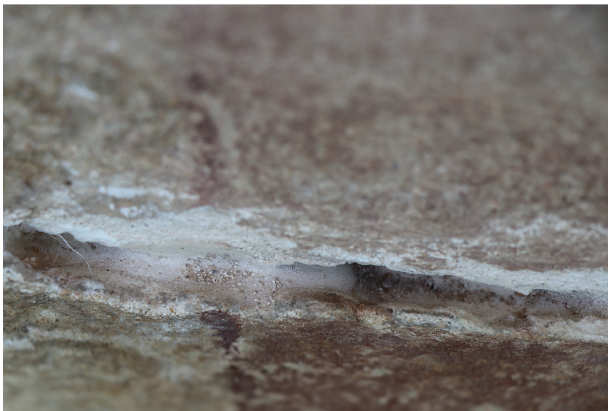
Obr. 34: Dutina po vyplnění injektážnou maltou.
