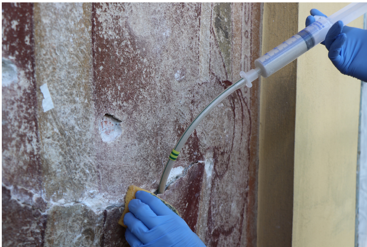
Obr. 31: Aplikácia ľahčenej injektažnej malty do veľkej dutiny.
