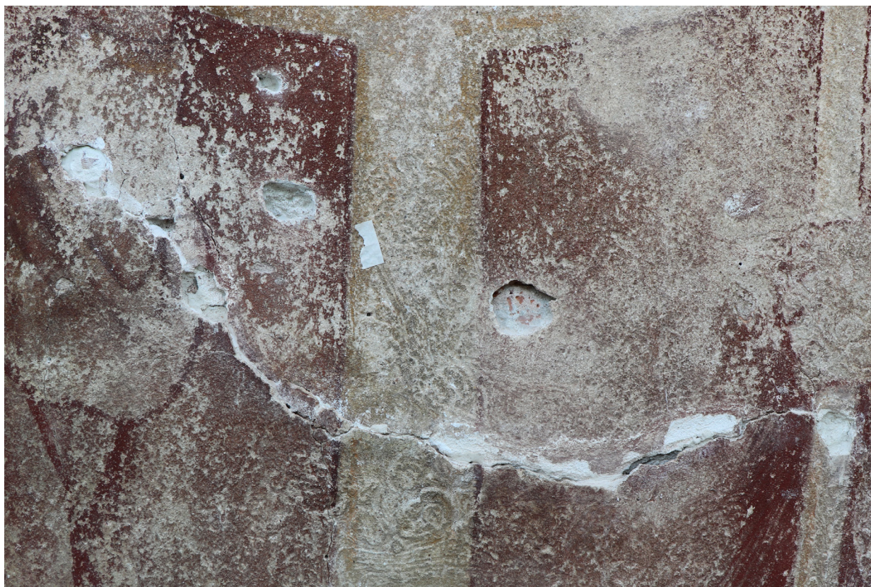
Obr. 33: Dutina po vyplnění injektážnou maltou.
