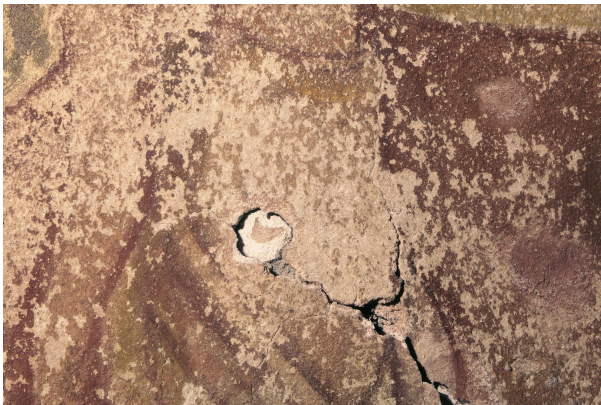
Obr. 29: Detail maľby trupu sv. Vojtecha. Miesto poškodenia prasklinou. Fotografia v umelom halogénovom svetle. Stav pred reštaurovaním.
