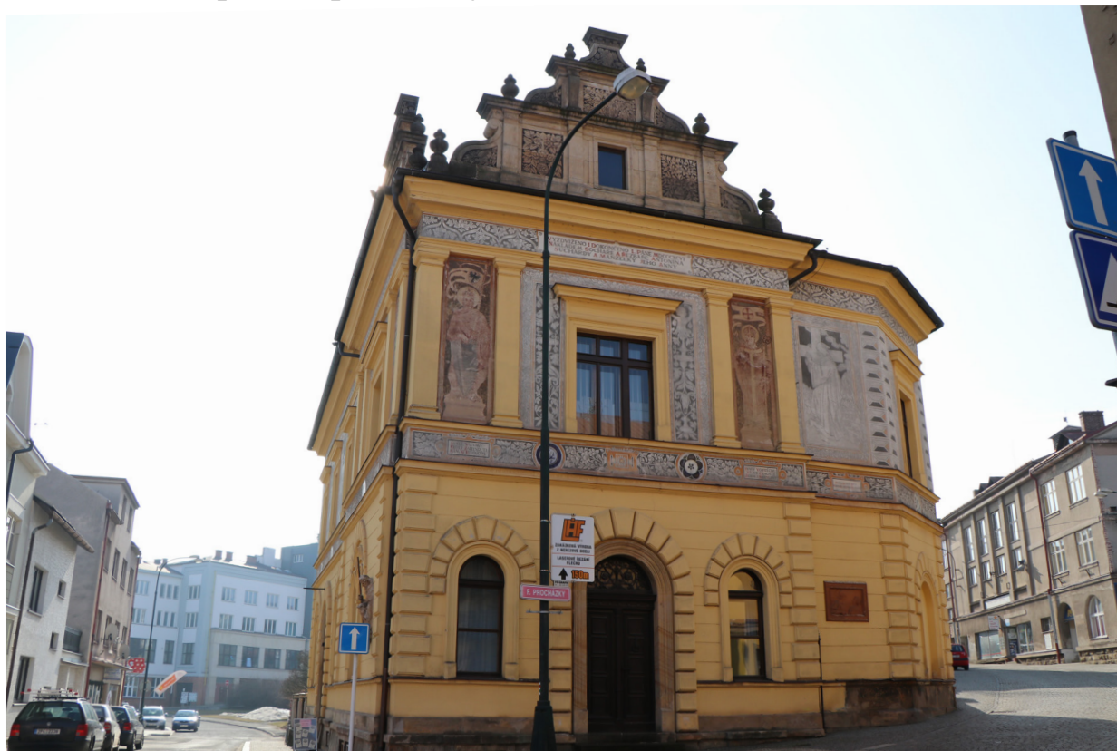
Obr. 4: Severozápadná fasáda Suchardovho domu, dnešného múzea mesta Nová Paka v roku 2017. Stav pred reštaurovaním malieb.
