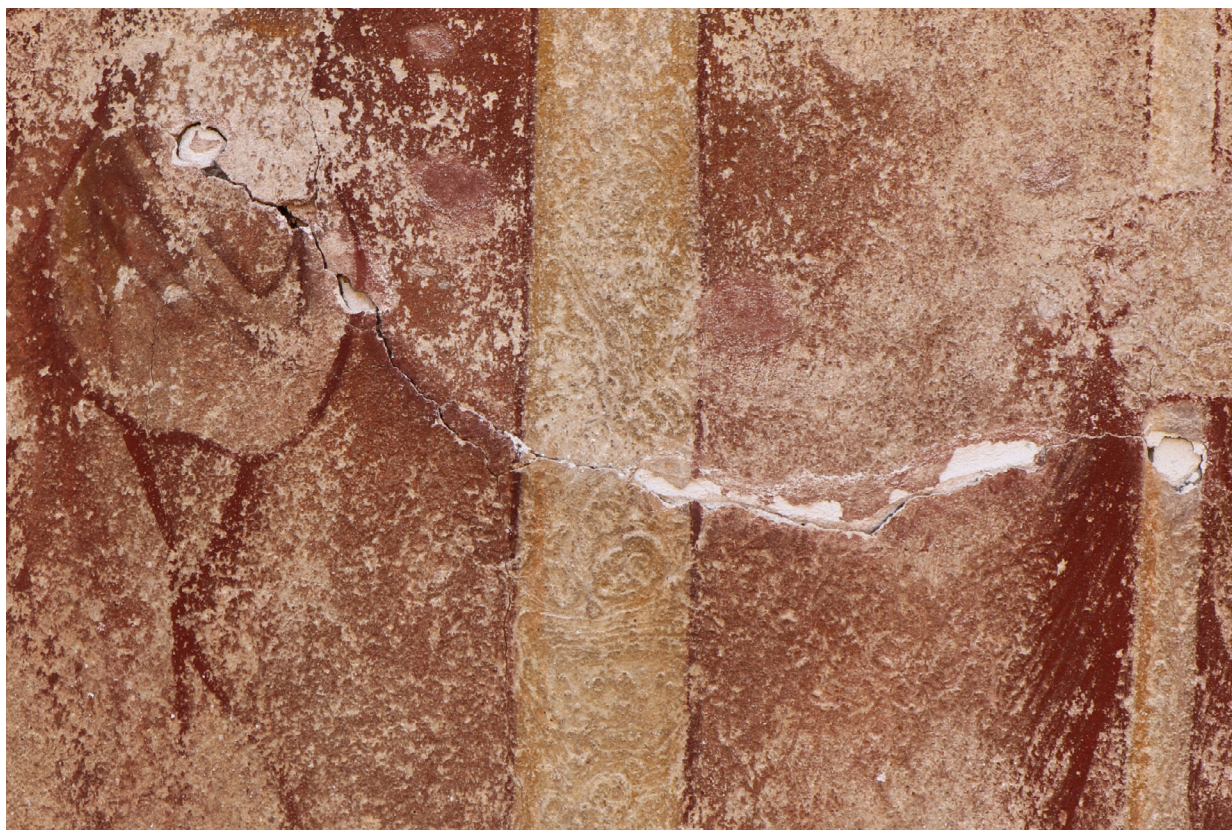
Obr. 51: Časť maľby - veľká prasklina, pred reštaurovaním. Fotografia v dennom svetle.
