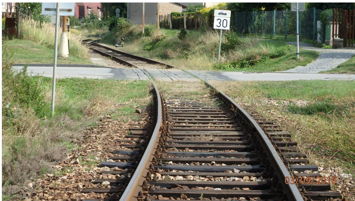
Přejezd km 3,118 004 č. P 10587
