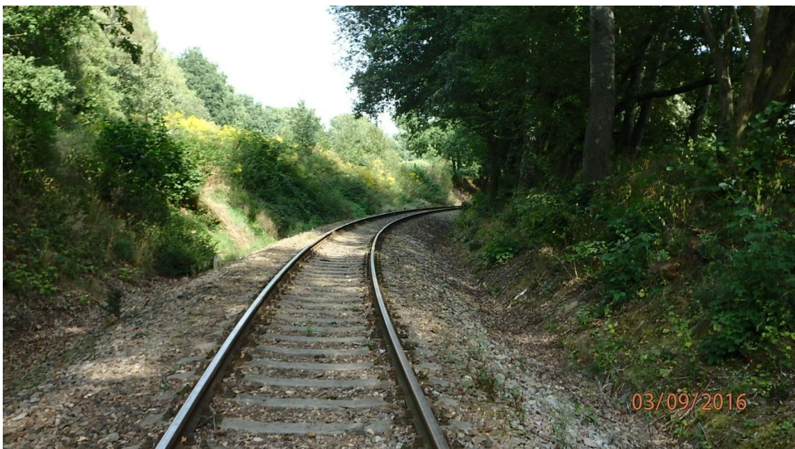
složený oblouk R=249,338\text{m} , R=200,000\text{m} , R=220,503\text{m} , R=210,000\text{m} , R=257,713\text{m}
