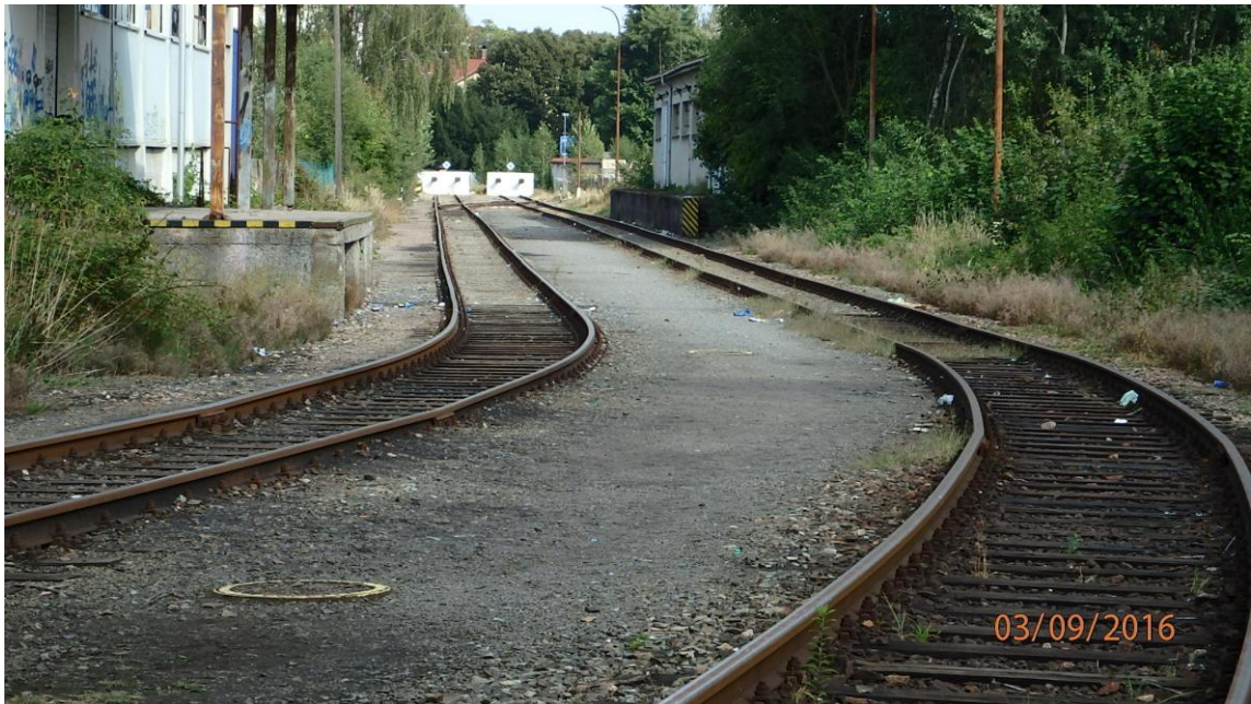
Směrové oblouky R=147,549\text{m} , R=150,948\text{m}
