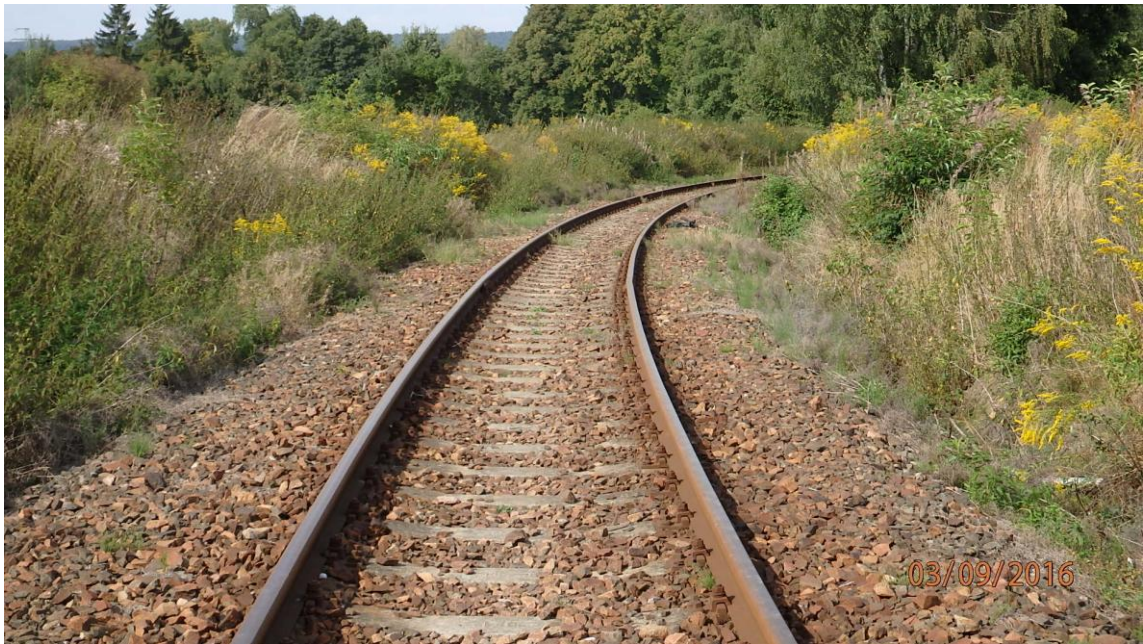
složený oblouk R=249,338\text{m} , R=200,000\text{m} , R=220,503\text{m} , R=210,000\text{m} , R=257,713\text{m}
