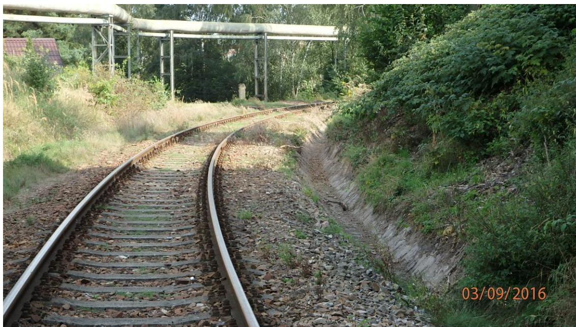
složené oblouky R=249,338\text{m} , R=200,000\text{m} , R=220,503\text{m} , R=210,000\text{m} , R=257,713\text{m}
