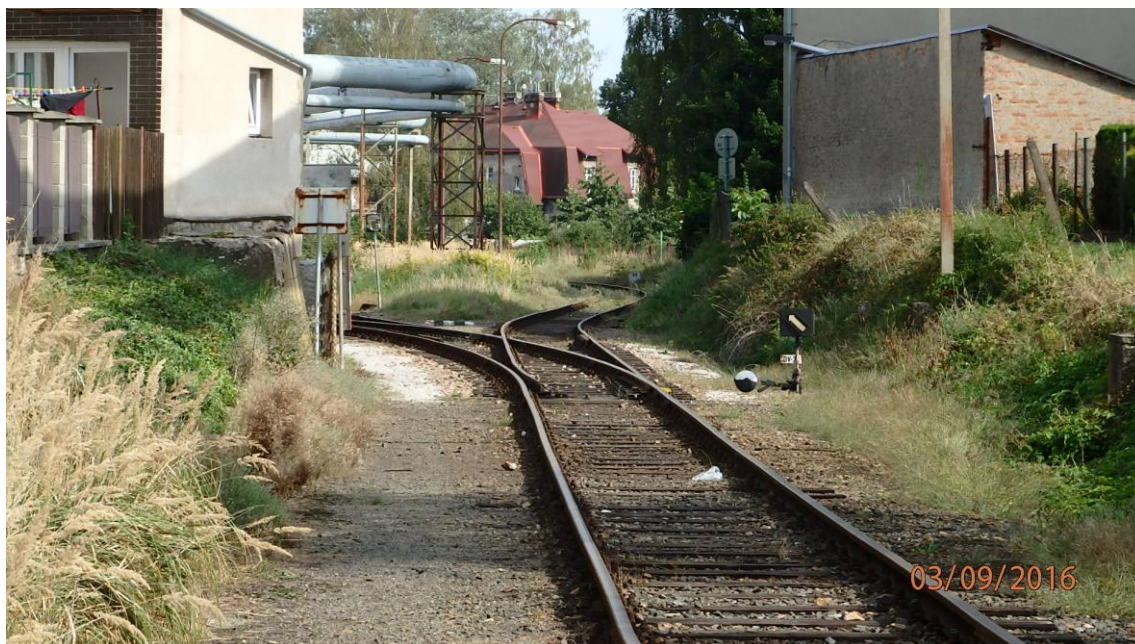
Výhybka č. DV2
