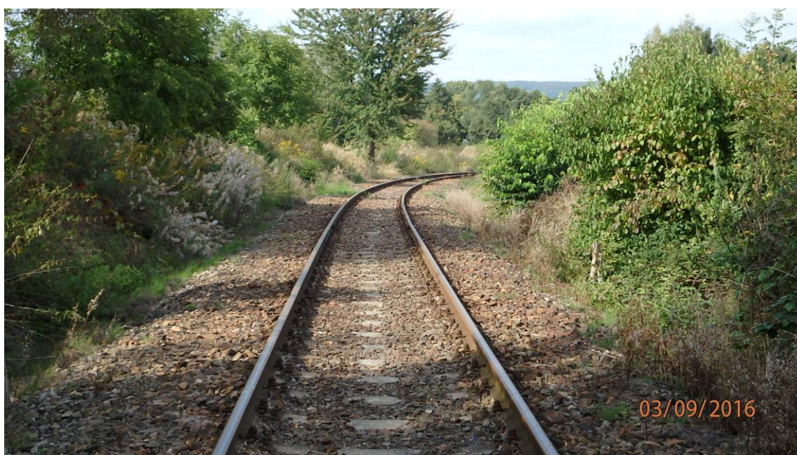
složený oblouk R=249,338\text{m} , R=200,000\text{m} , R=220,503\text{m} , R=210,000\text{m} , R=257,713\text{m}
