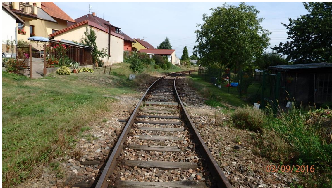
Složený oblouk R=199,732\text{m} , R=198,300\text{m} , R=202,265\text{m} , okraj obce Lipnice
