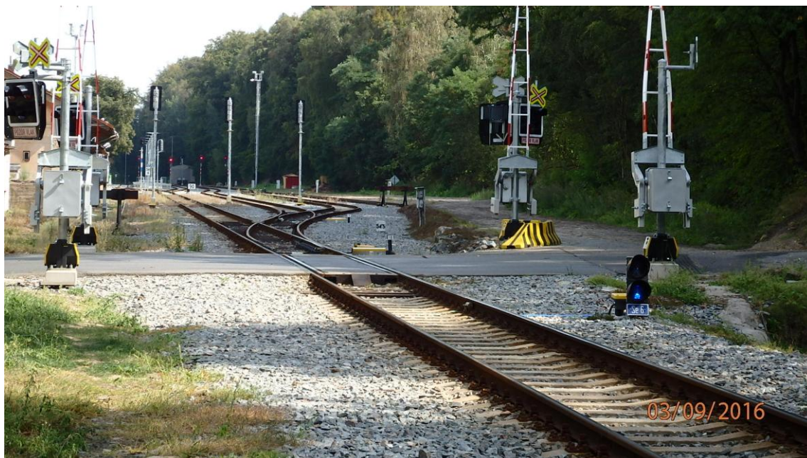
Přejezd č. P 5233 a zhlaví železniční stanice Dvůr Králové nad Labem
