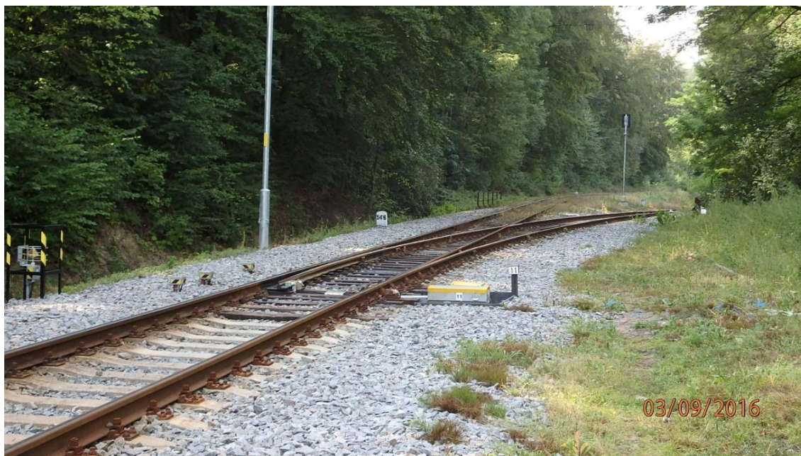
Začátek vlečky výhybky č.11
