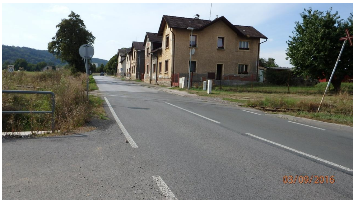
Přejezd km 1,778 728 č. P 10586 směr Lipnice
