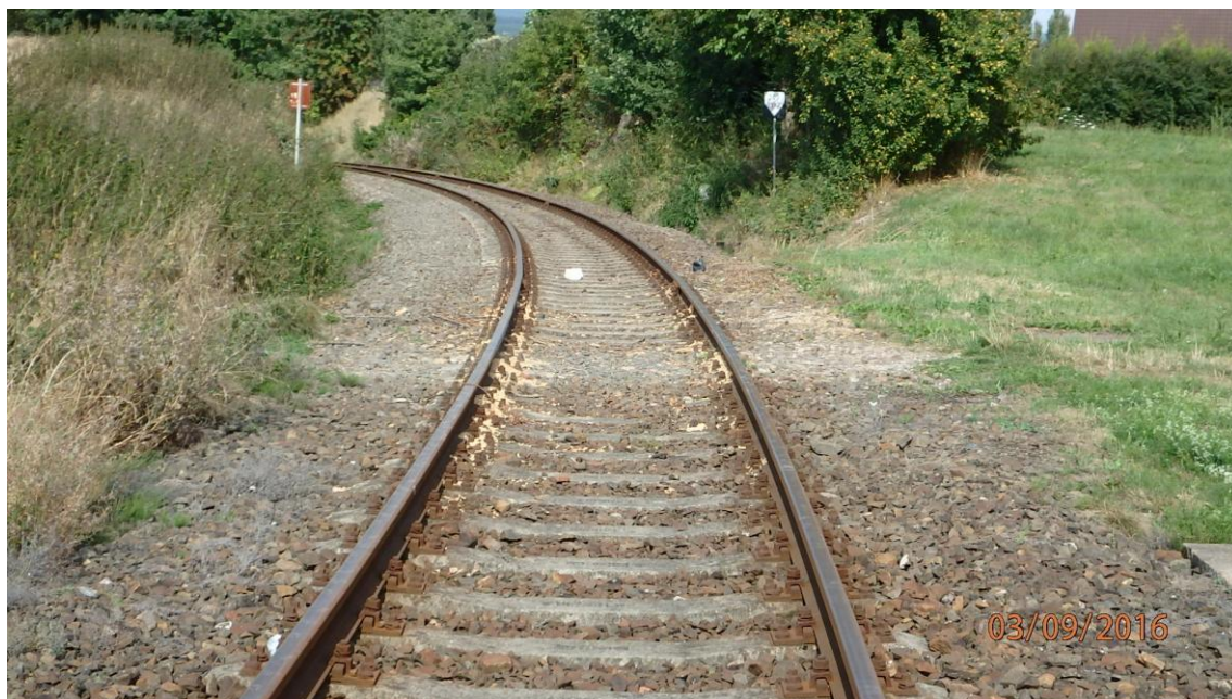
Složený oblouk R=279,265\text{m} , R=300,000\text{m} , R=413,865\text{m} ,
