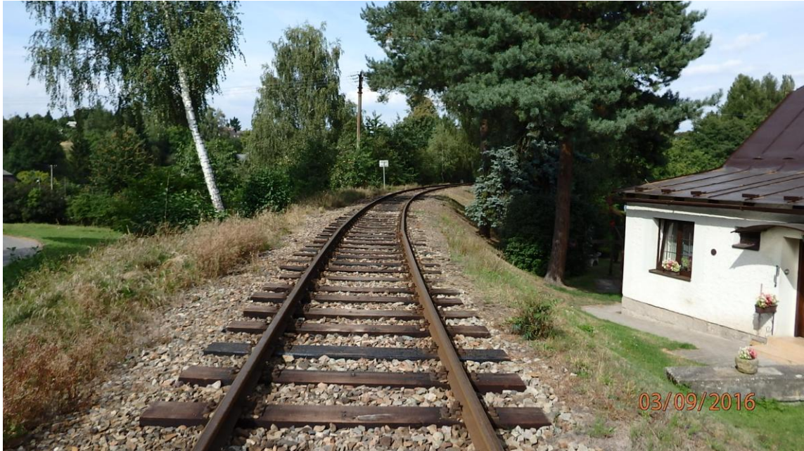
Složený oblouk R=199,732\text{m} , R=198,300\text{m} , R=202,265\text{m} , okraj obce Lipnice
