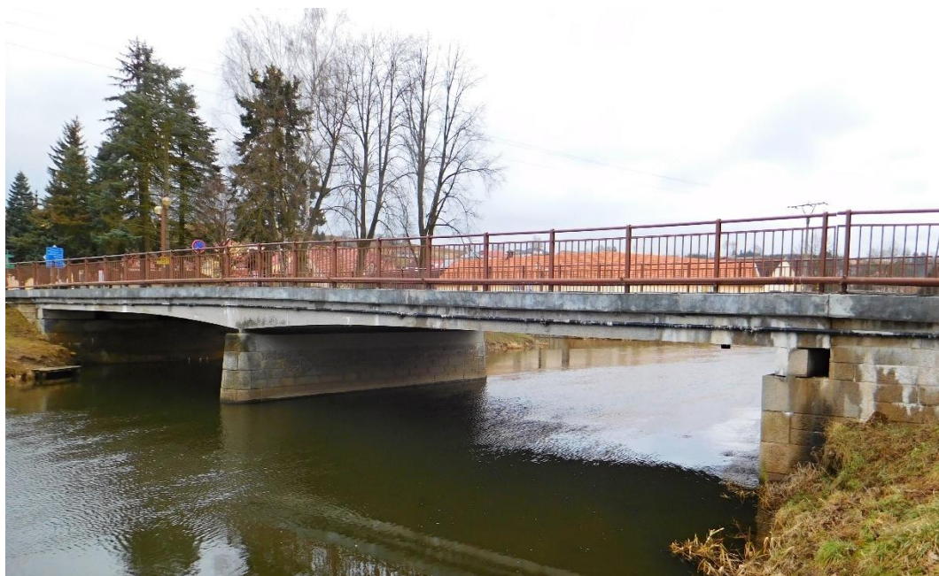
Obrázek 9 Most č. 404–005 přes řeku Jihlavu
