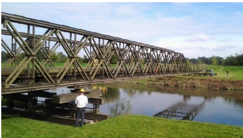
Obrázek 1 Těžká mostová souprava TMS
