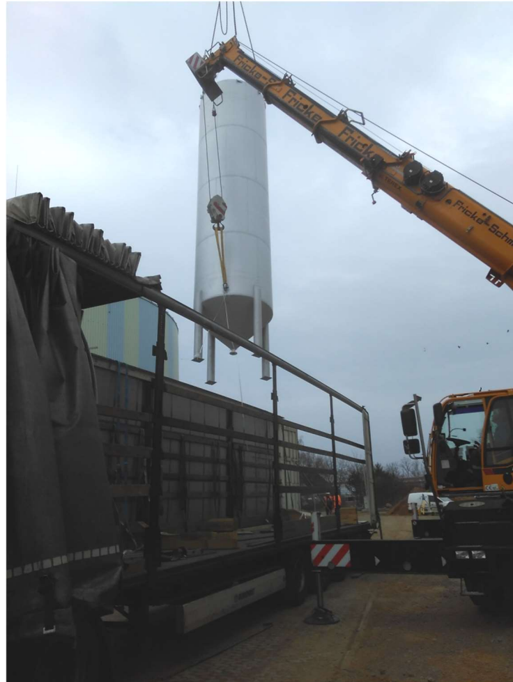
Obrázek 19 Nakládka nerezové nádrže
