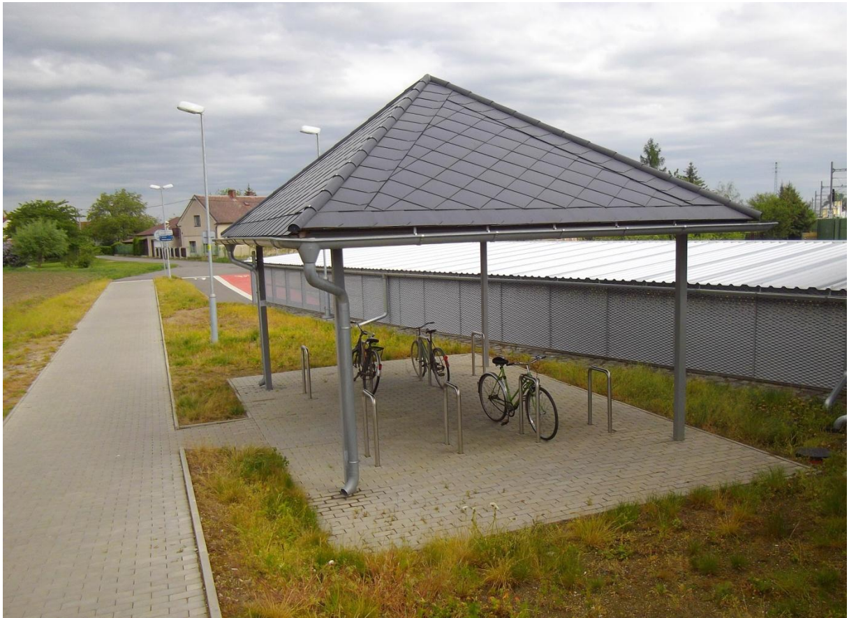
Obrázek 1 Zastřešená odstavná zařízení v Opatovicích na Labem
