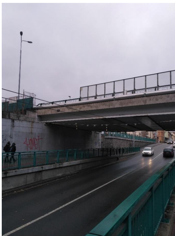
Obrázek 8 Snížená výška trolejového vedení v podjezdu
