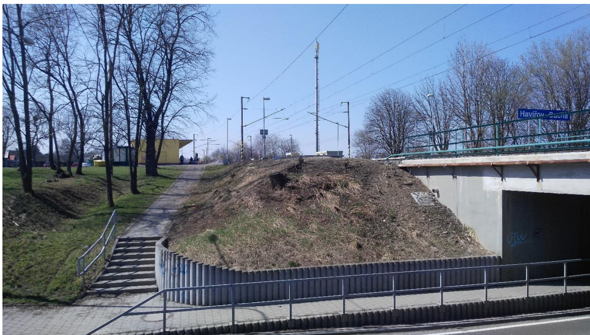
Obrázek 12 Přístup k nástupišti ve směru do Českého Těšína
