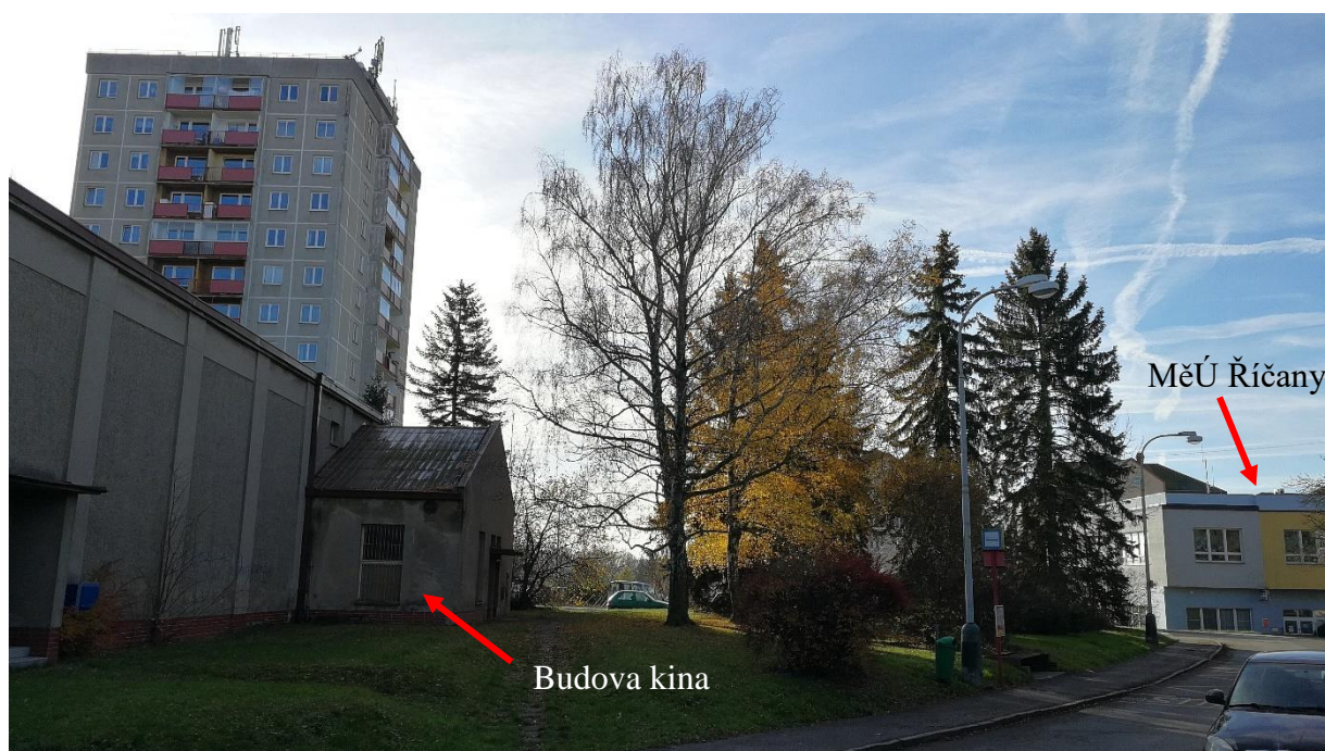
Obrázek 10 Pohled na budovu kina
