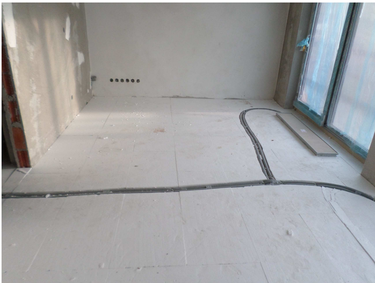
Obrázek 20: Podlaha před zalitím anhydritovým potěrem
