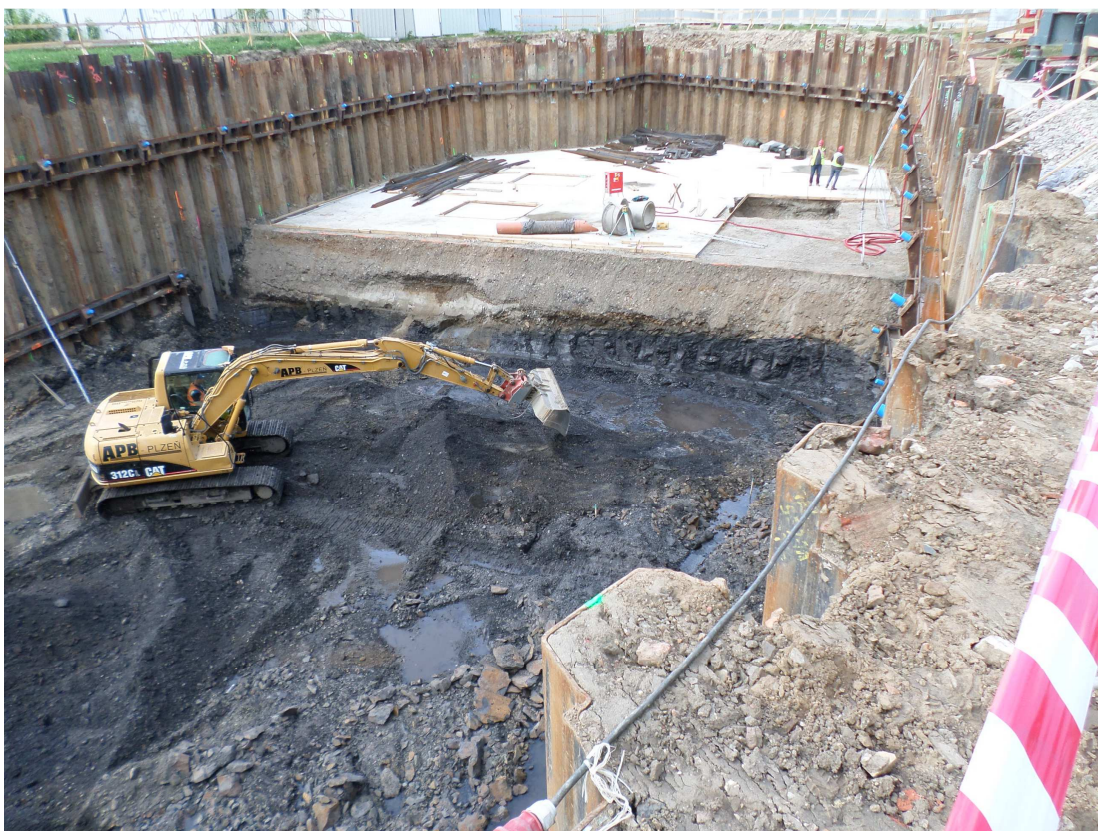
Obrázek 16: Zajištění stavební jámy a výkopové práce
