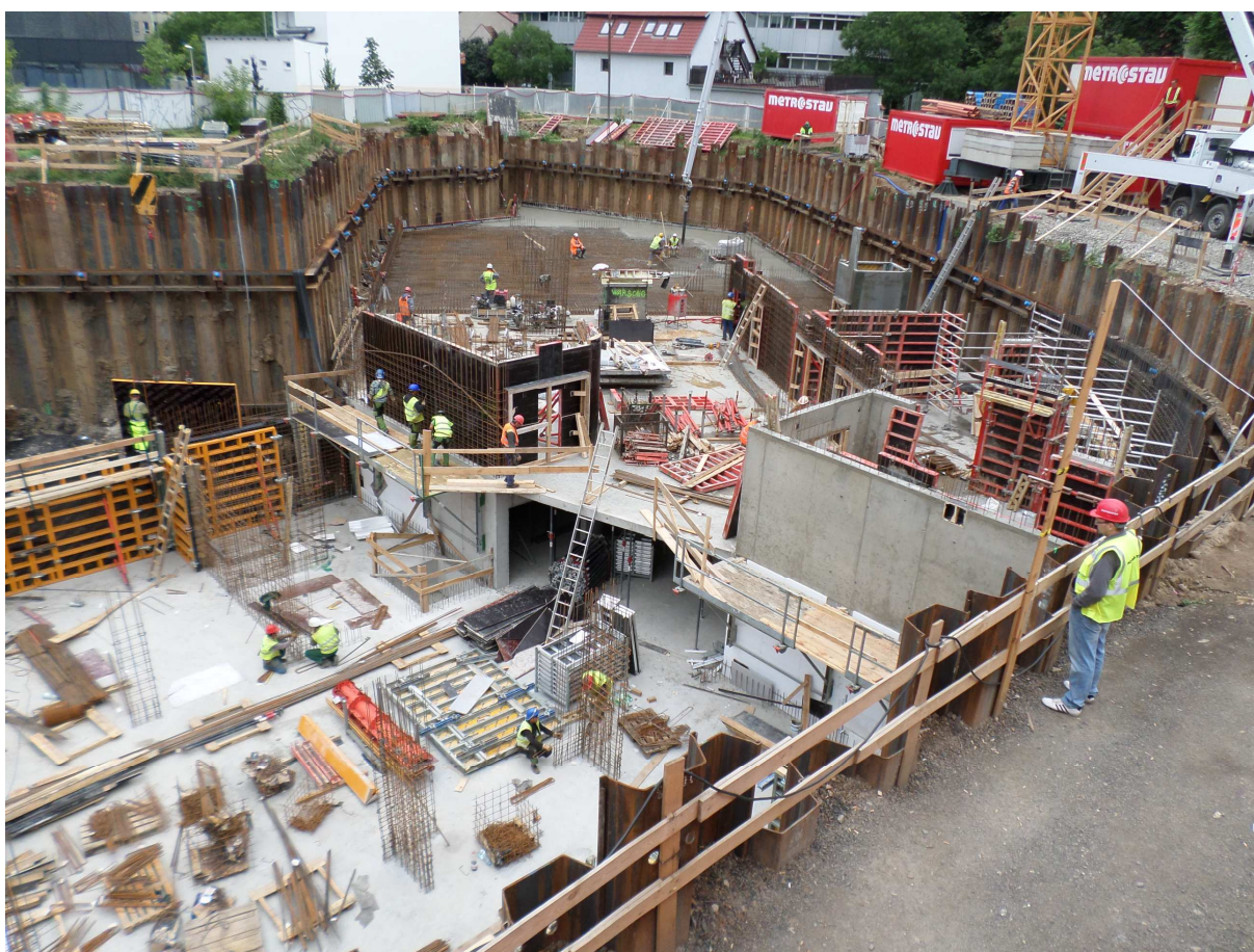
Obrázek 17: Zhotovení železobetonových konstrukcí – bednění, armování a betonáž
