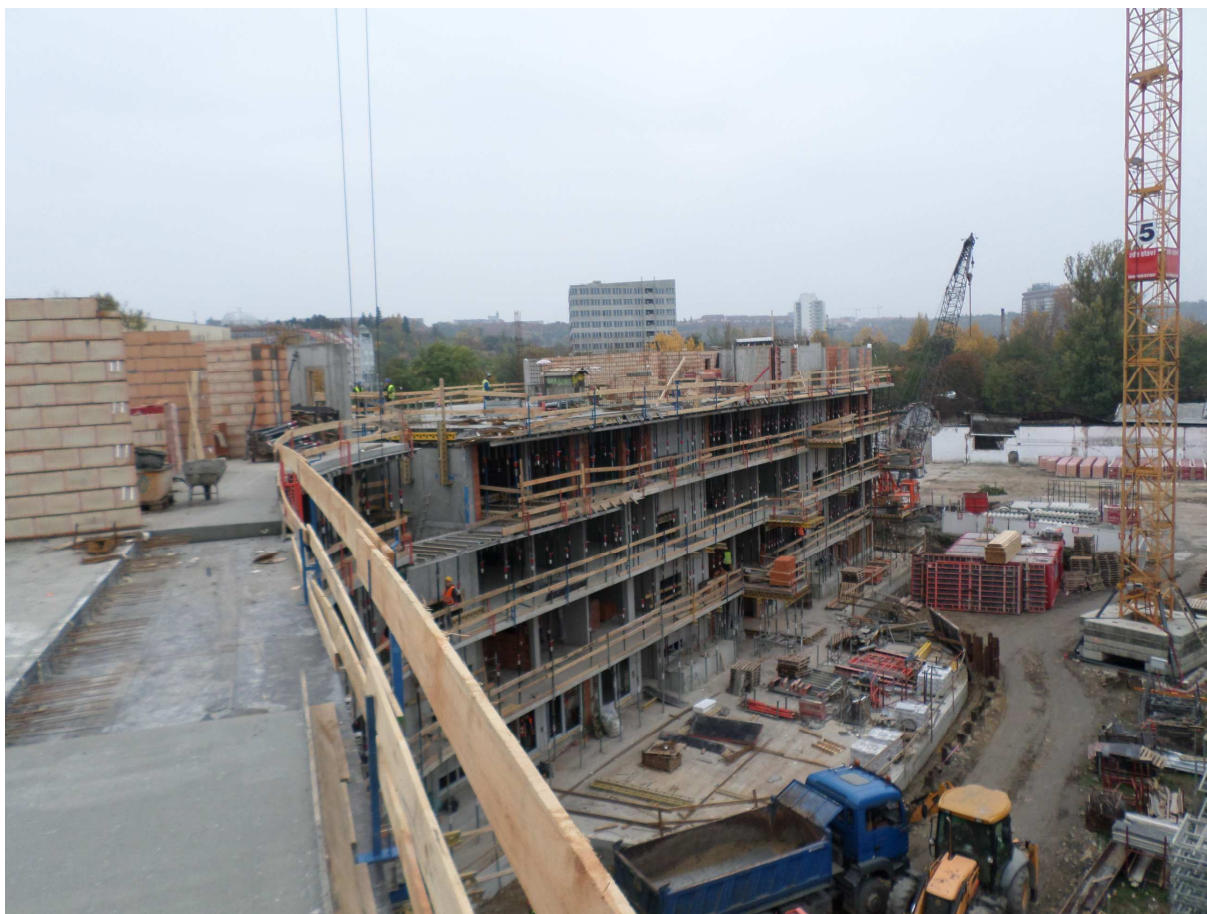
Obrázek 18: Vyzdívky a betonáže ve vyšších podlažích
