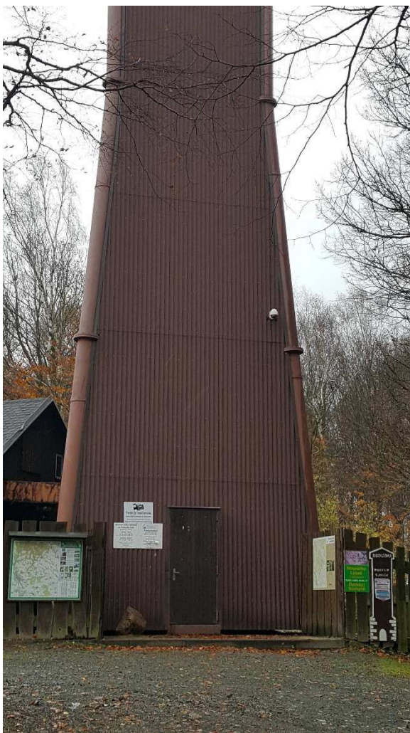
Obrázek 5 – Pohled na opláštěnou konstrukci
