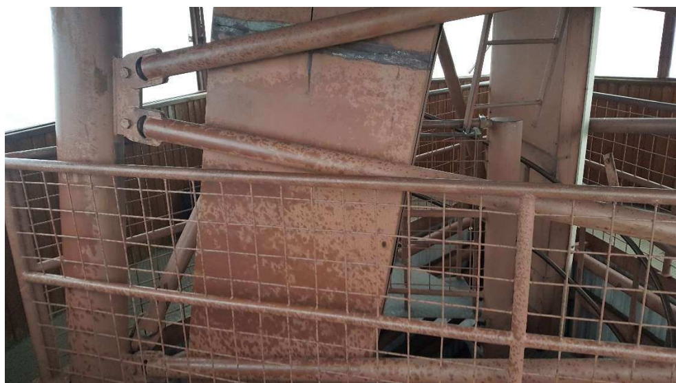
Obrázek 6 – Připoj diagonál a příček k nárožníkům ve spodní části konstrukce
