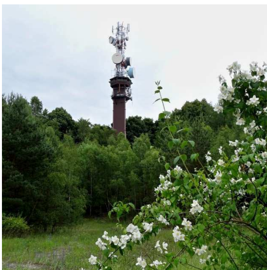
Obrázek 2 – Celkový pohled na rozhlednu
