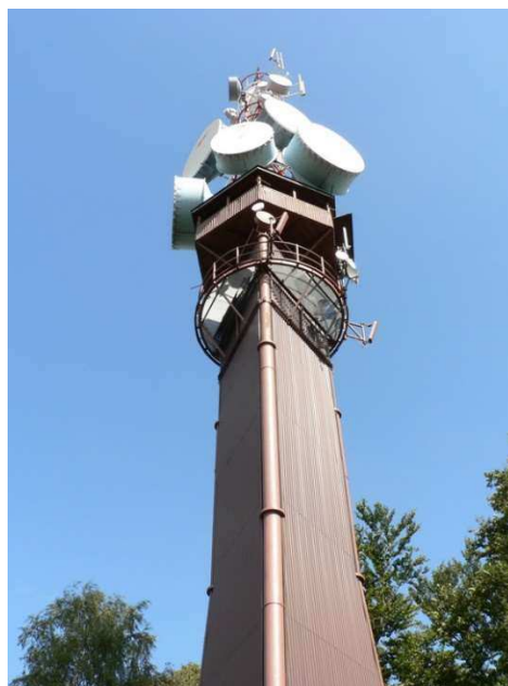
Obrázek 3 – Celkový pohled na rozhlednu
