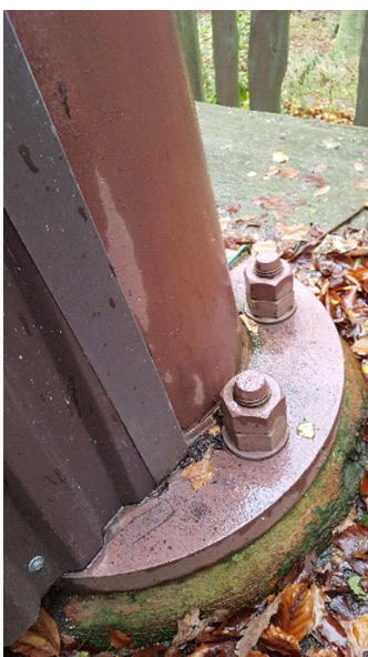
Obrázek 9 – Vetknutí konstrukce do základu
