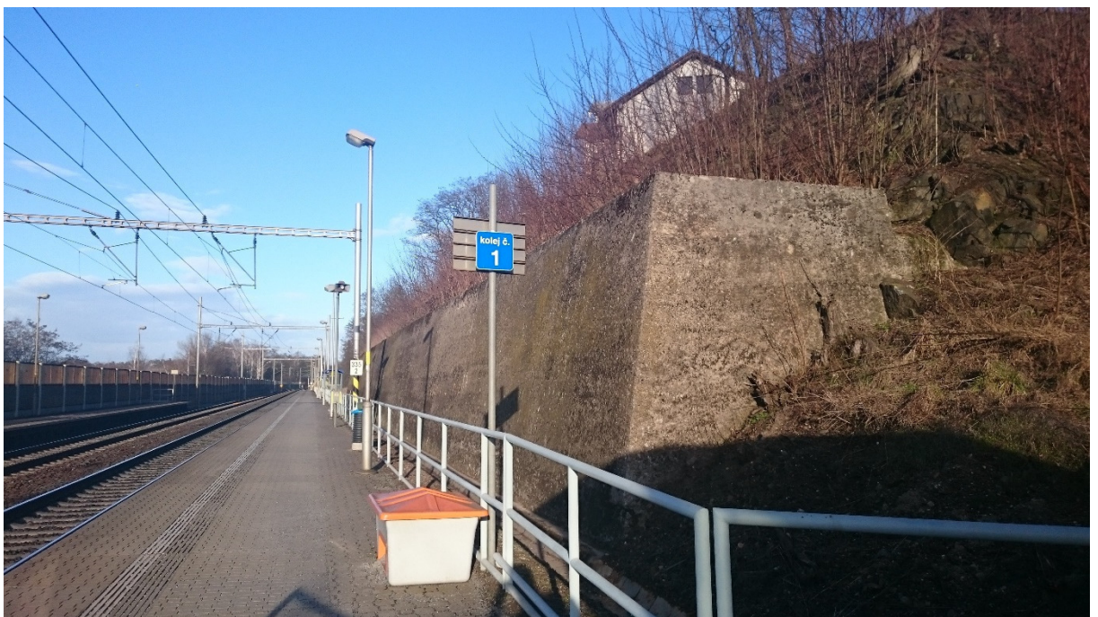
Obr. 18 - Pohled na řešenou zárubní zeď [1]
