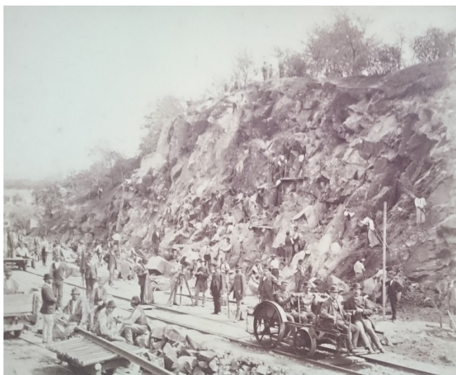
Obr. 8 – Staveniště v úpatí strmých skal [1]
