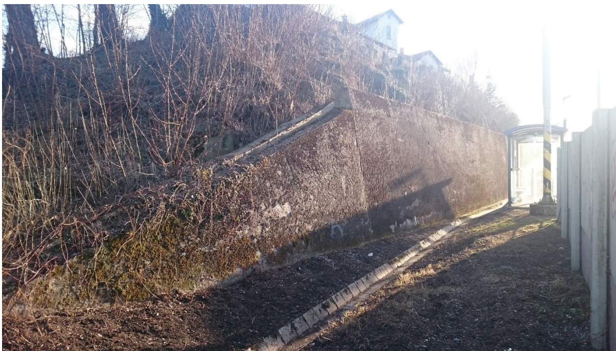
Obr. 19 - Pohled na ukončení zárubní zdi [1]
