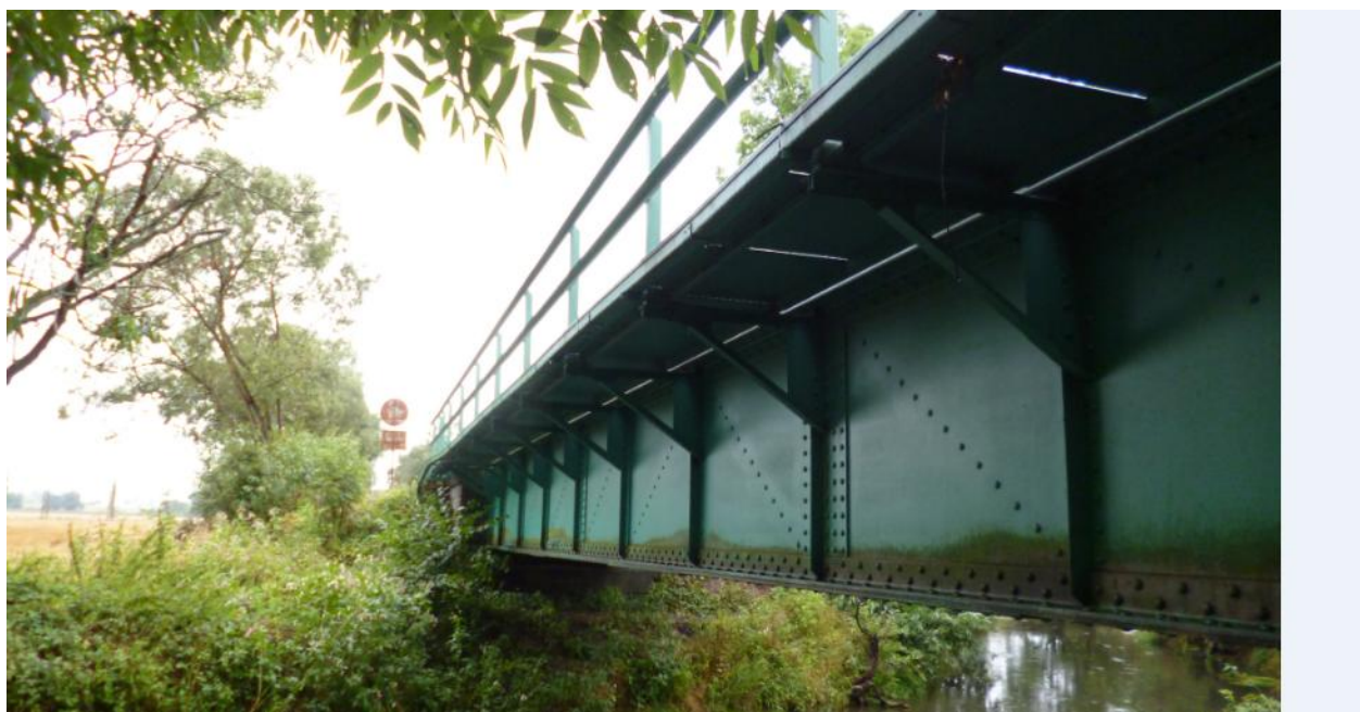
Obrázek 2 – Pohled na most zleva (od Vysokého Mýta)
