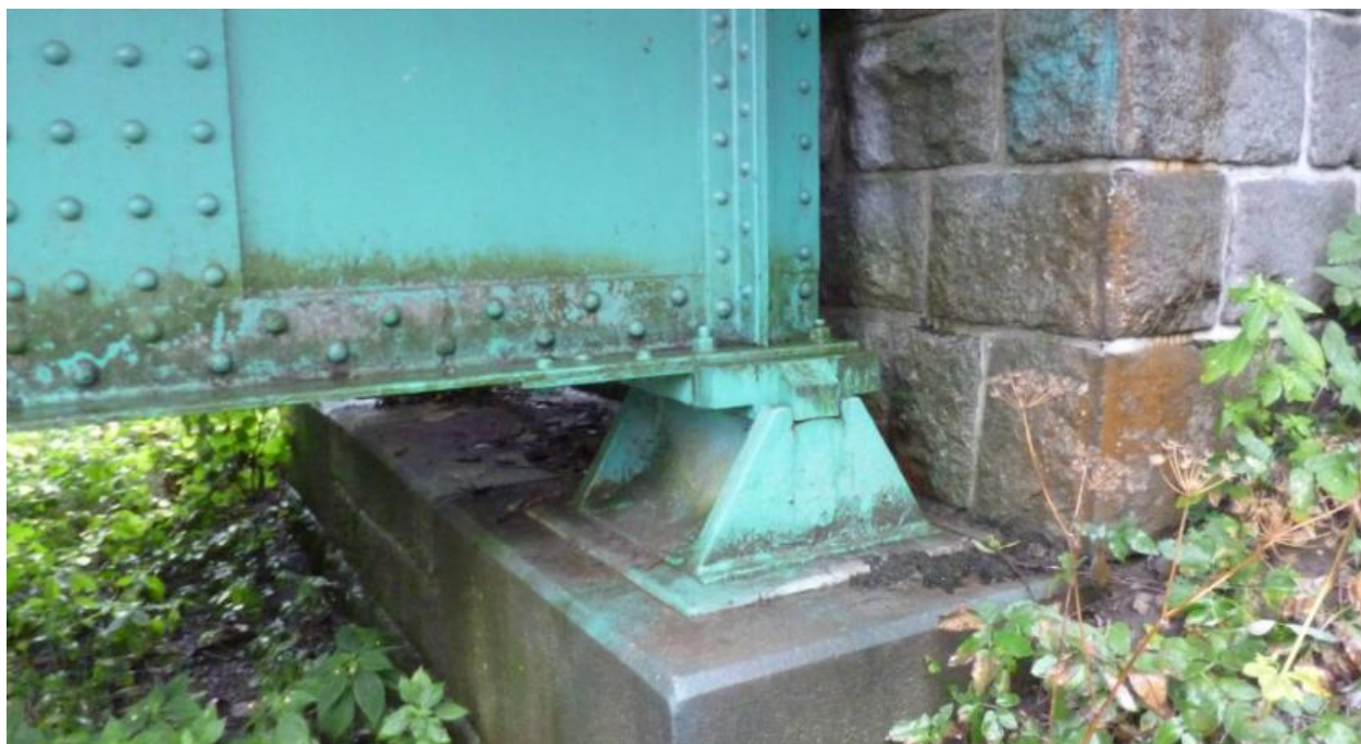
Obrázek 11 – pevné ocelové ložisko tangenciální (strana na Choceň)
