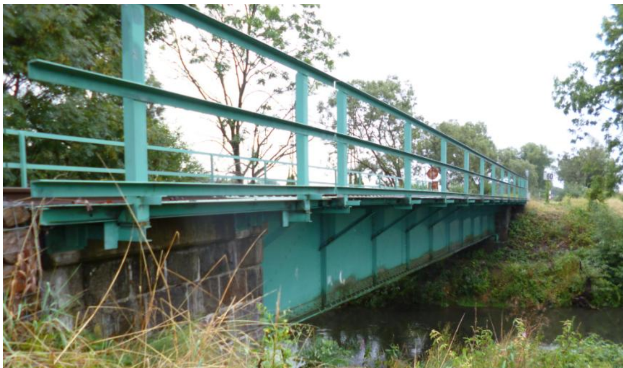
Obrázek 3 – Pohled na most zprava (od Vysokého Mýta)
