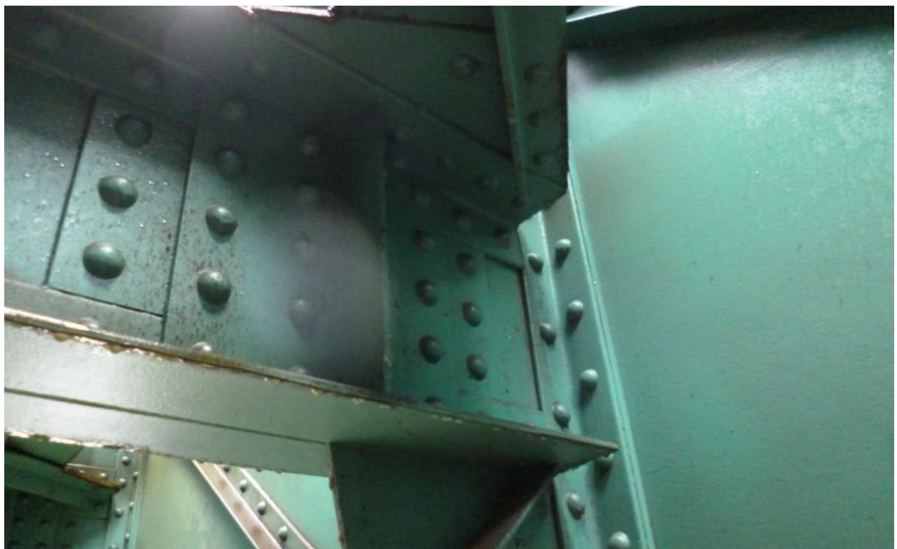
Obrázek 10 – Příčníky, vyztužení hlavního nosníku
