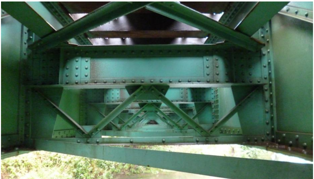
Obrázek 9 – Mostnice, příčnice, podélníky, vyztužení hlavního nosníku, zavětrování hl. nosníku (vrchní, spodní), ztužení podélníku
