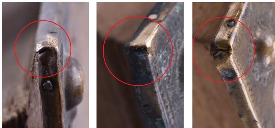
Obr. č. 37 Spracovanie materiálu na rohoch nárožného kovania
