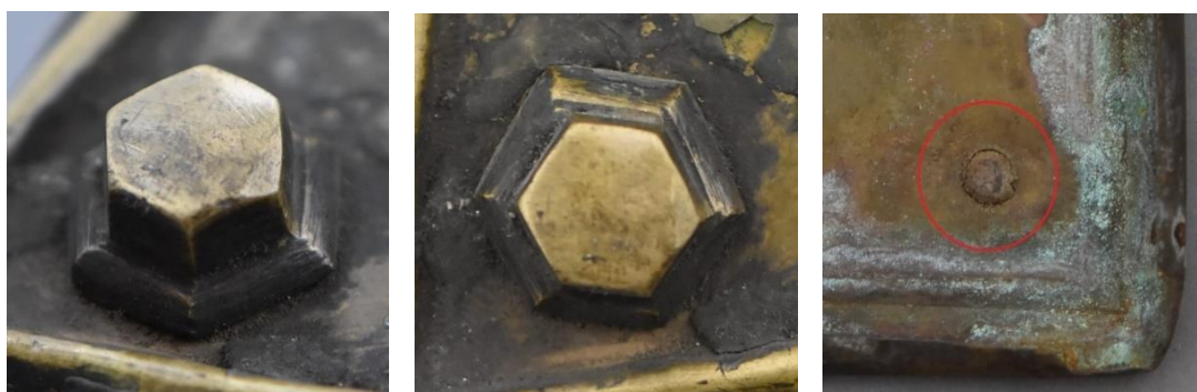
Obr. č. 55 Príklad pukiel kulikovitého tvaru s „podstavcom“ ako súčasť nárožného kovania
