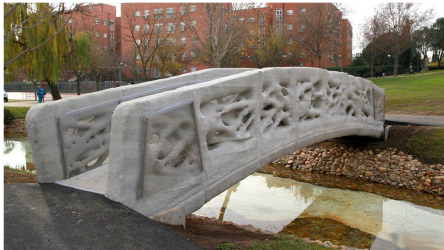
Obr. 44: Most postavený principem 3D tisku v Madridu [59]
