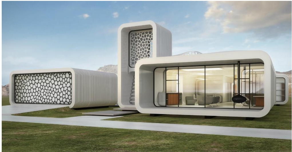
Obr. 43: Dům postavený za pomoci 3D tiskárny včetně interieru v Dubai [58]
