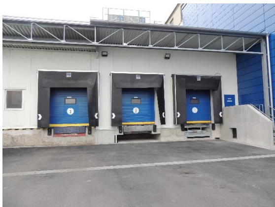
Obrázek 22 Vyrovnávací můstky v budově expedice (autorka)
