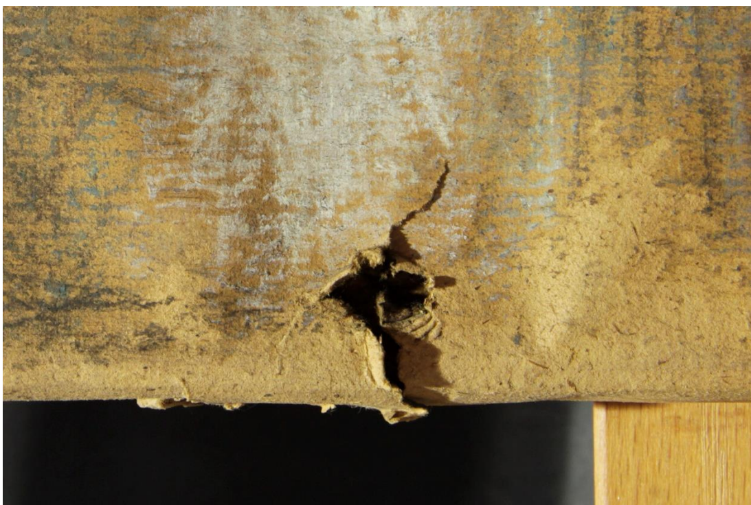
Obr. 8: Stav před restaurováním, detail trhliny (spodní okraj díla)
