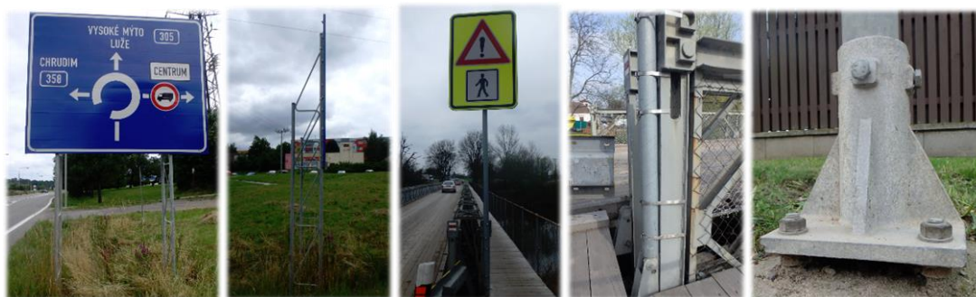
Obrázek 36, 37, 38, 39, 40: Příklady nosných konstrukcí značek, Zdroj: [Autor]
