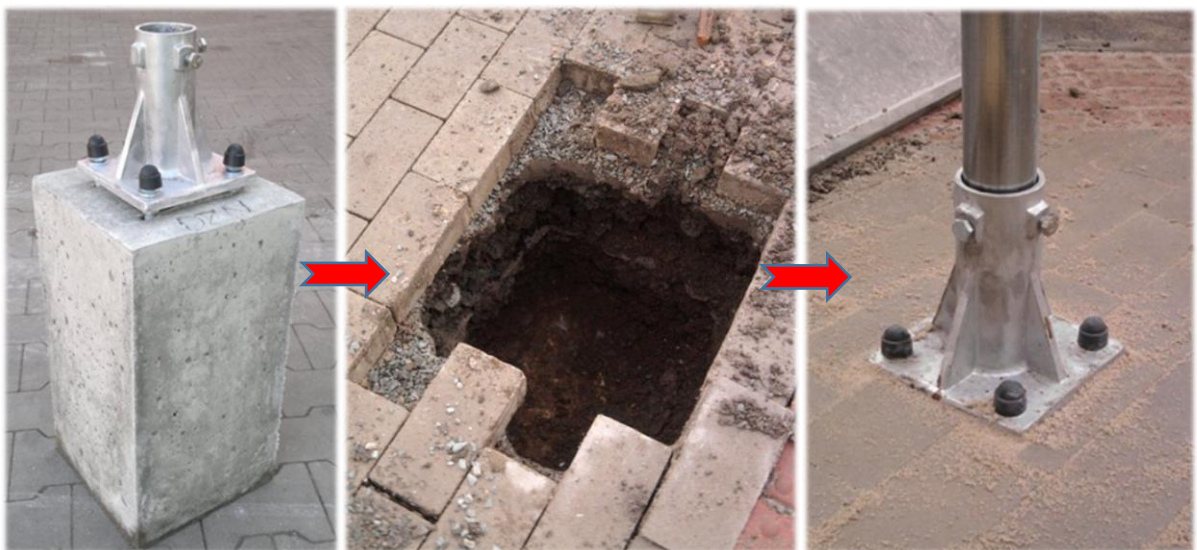
Obrázek 41, 42, 43: Instalace kotevní patky s prefabrikovaným základem, Zdroj: [12]
