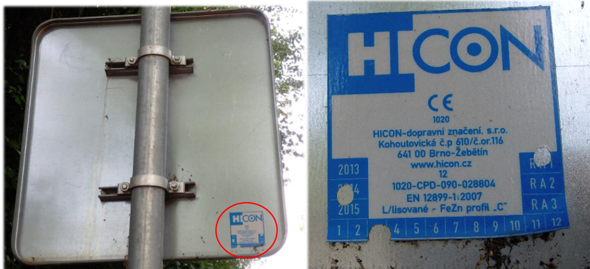
Obrázek 9, 10: Identifikační štítek na rubové ploše značky-zde třída RA1, datum osazení 03/2014, Zdroj: [Autor]
