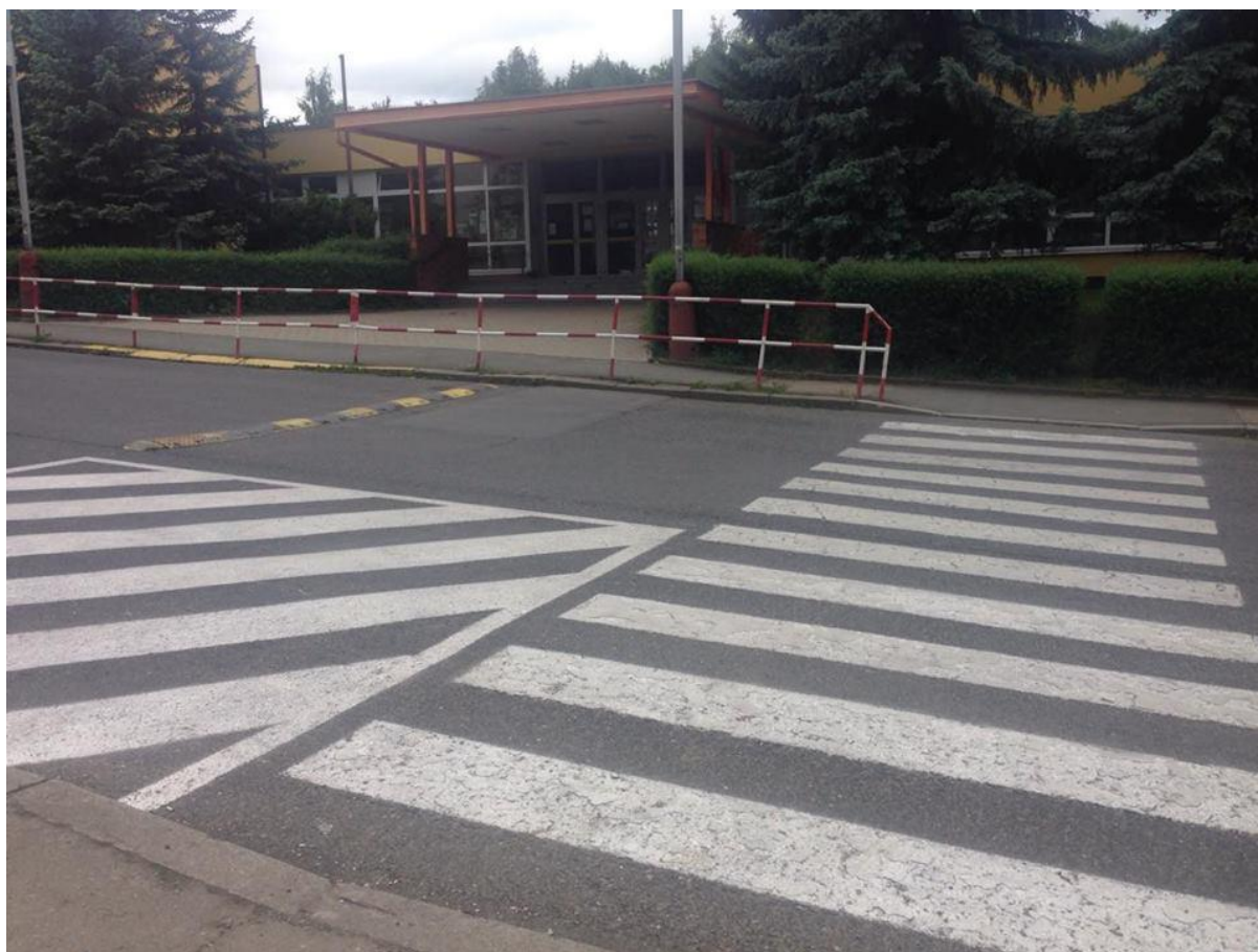
Obr. 2 Vchod do budovy školy
