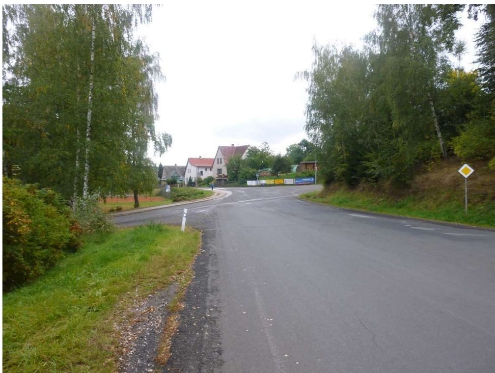
Obr. 21 – Křížení ulic Žižkova a K Břízkám, foceno protisměru staničení
