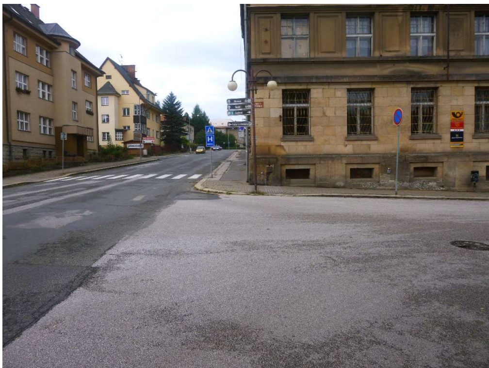
Obr. 01 – Křížení ulic Žižkova a Geo. Pošepného, pohled ve směru staničení
