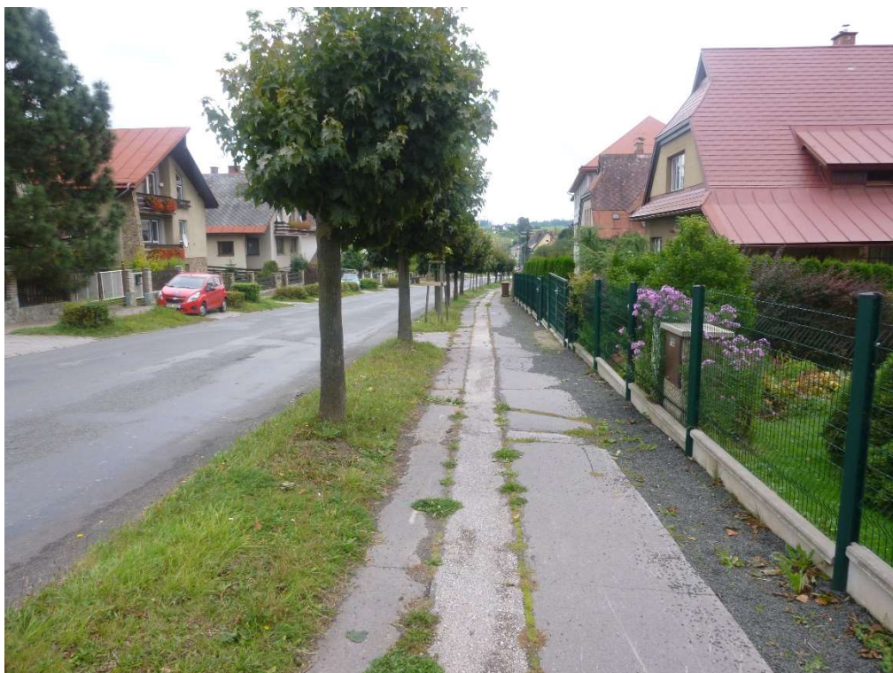
Obr. 23 – Ulice Žižkova km 0,360 00, foceno proti směru staničení
