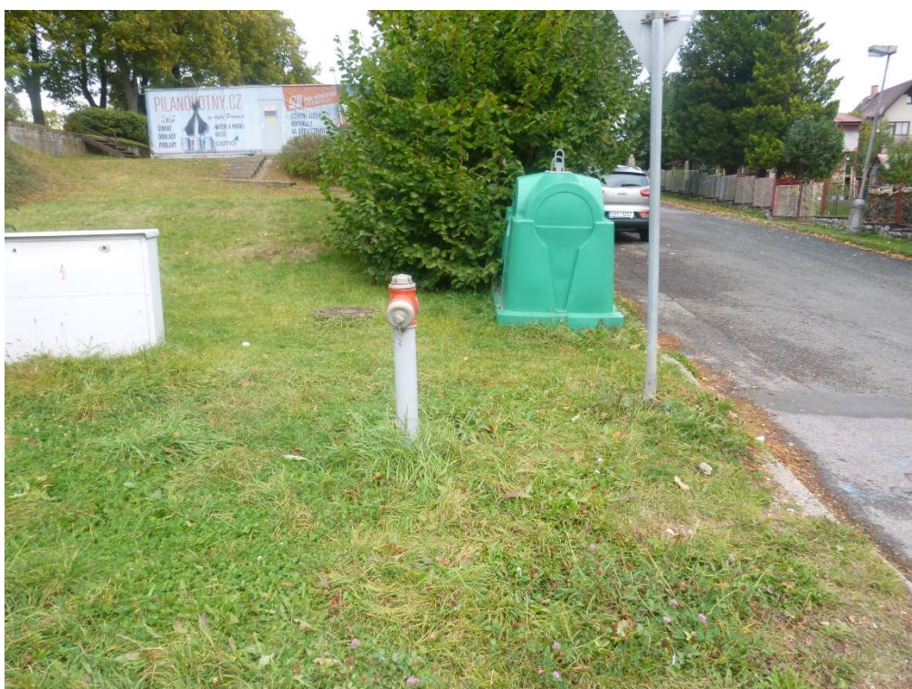
Obr. 10 – Pohled z ul. Žižkova km 0,387 00, stranová přeložka nadzemního hydrantu
