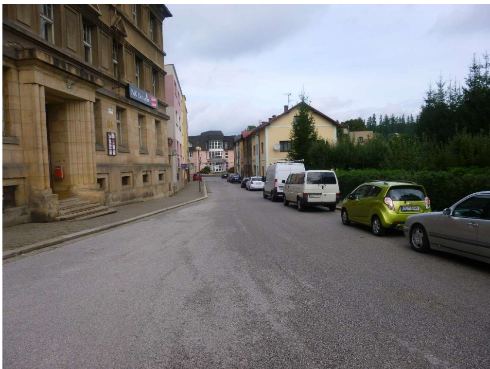
Obr. 02 – Ulice Geo. Pošepného, před vchodem do budovy České Pošty
