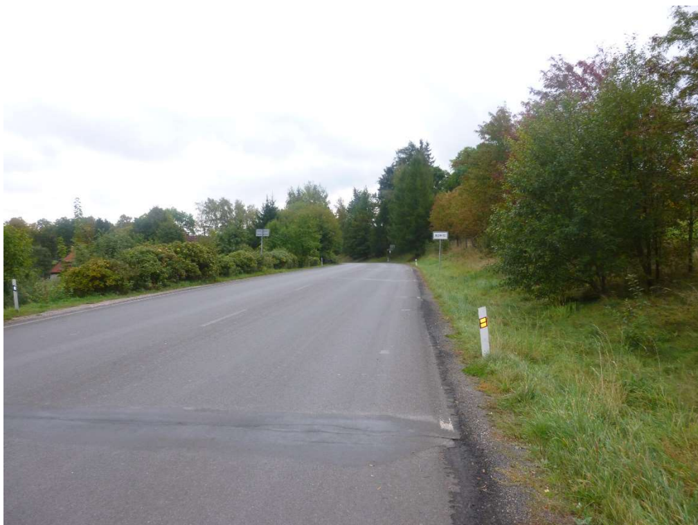
Obr. 20 – Silnice II/286, pohled směrem do obce
