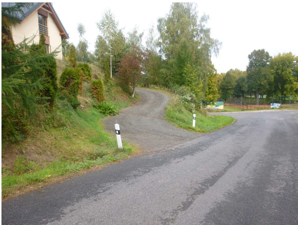
Obr. 15 – Ulice K Břízkám napojení sjezdu k nemovitosti
