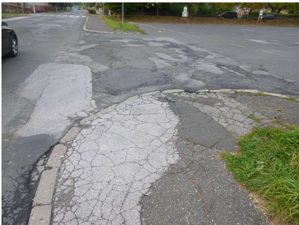
Obr. 06 – Místo stávajícího vjezdu/výjezdu z dopravního terminálu
