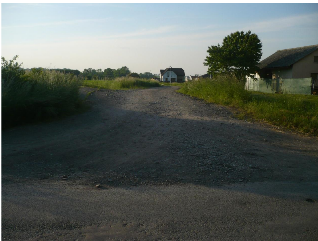
Pohled 2 – jižní příjezdová cesta z komunikace III/3584
