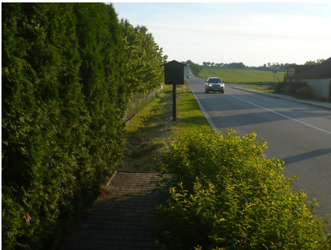
Pohled 19 – západní pohled na ukončení chodníku
