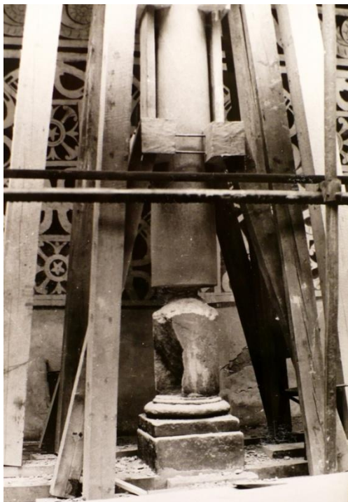
Zajištění sloupu výdřevou a postupné odtesávání poškozené části
