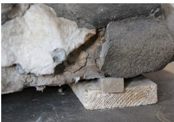
Obr. 7 - Uražený spodek obláčku na přední straně sochy, viditelný je kus odloženého kamene na čepu a část dožilého tmelu
