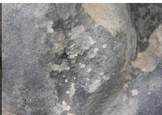
Obr. 4 - sádrovcové krusty - vyskytují se v dešťových stínech
