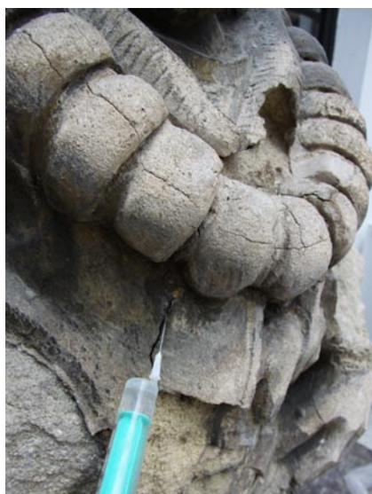
Obr. 9 - Injektáž prasklin a dutin
