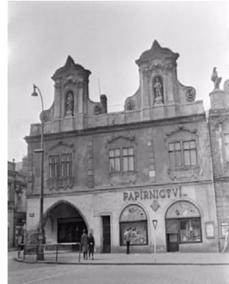
Obr. 1, 2: Plastika sv. Josefa s Ježíškem (vlevo) a sv. Zikmunda (vpravo) umístěné v nikách na atice domu U Černého orla, č. p. 91, Kolín. Foto: NPÚ, ÚOP Střední Čechy.
