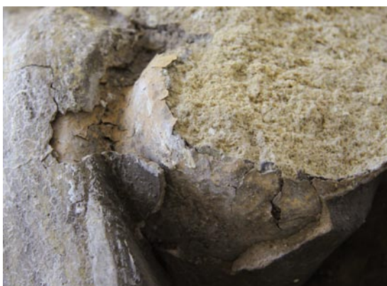
Obr. 4 - Oddělený tmel od barevné vrstvy na kameni - především ve spodní polovině postavy a v oblasti koruny
