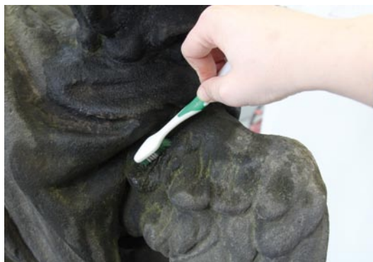
Obr. 14 - Čištění biologického napadení
