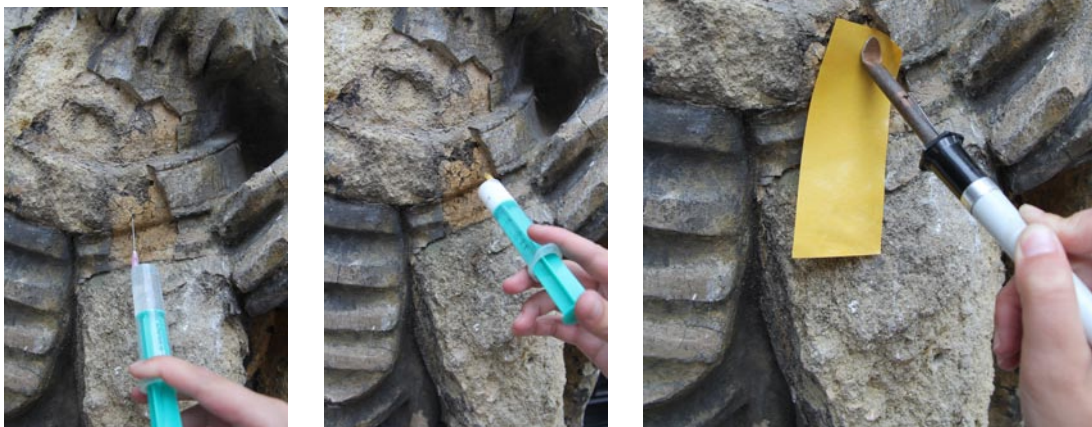
Obr. 10 - Postup při fixáži barevné vrstvy
