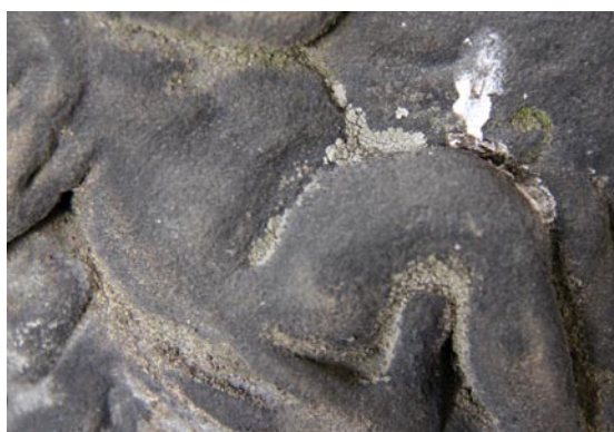
Obr. 3 - biologické napadení - především v záhybech modelace a ptačí trus na paladiu
