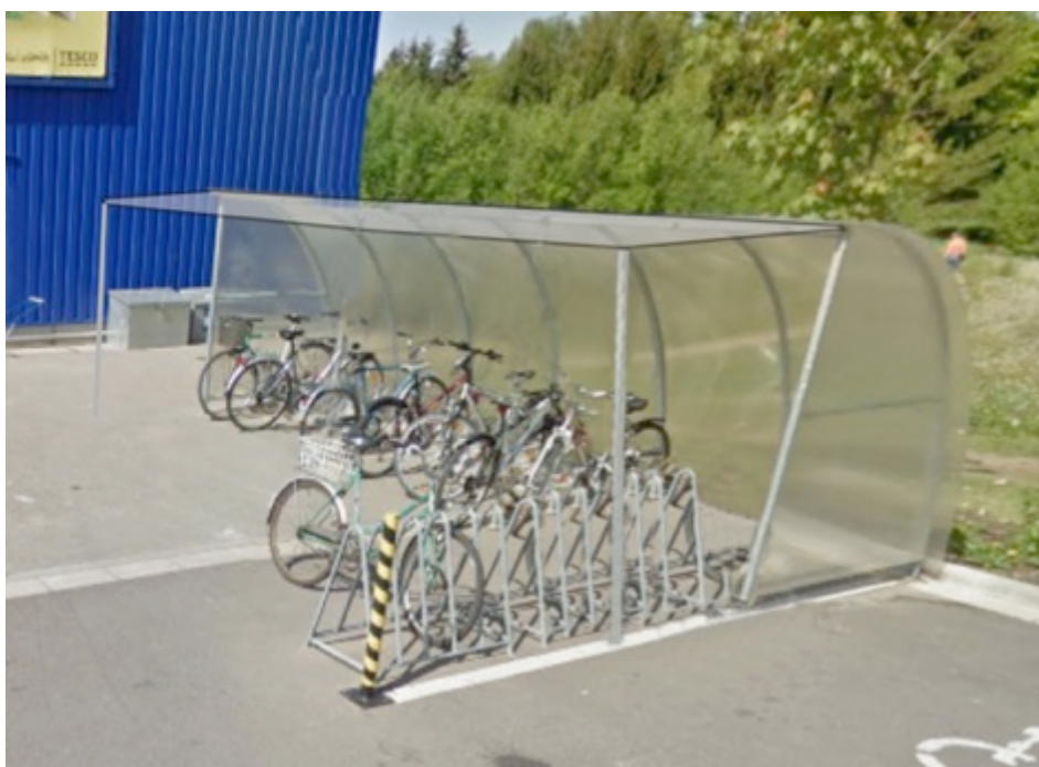
Obrázek 45 Prodloužení konstrukce zastřešení u obchodu Tesco Zdroj: autor
