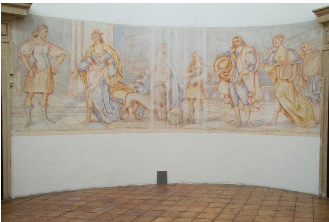
Obr. 34. Výjev Přijetí Humprechta Jana Černína ve stavu před restaurováním v denním osvětlení, na kterém jsou výrazné bílé stékanice ve středu výjevu. Byly způsobeny zatékáním srážkové vody okny do síně.
