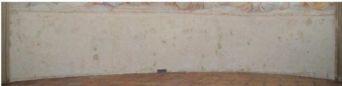
Obr. 87. Soklová část po novém vytmelení defektů.
