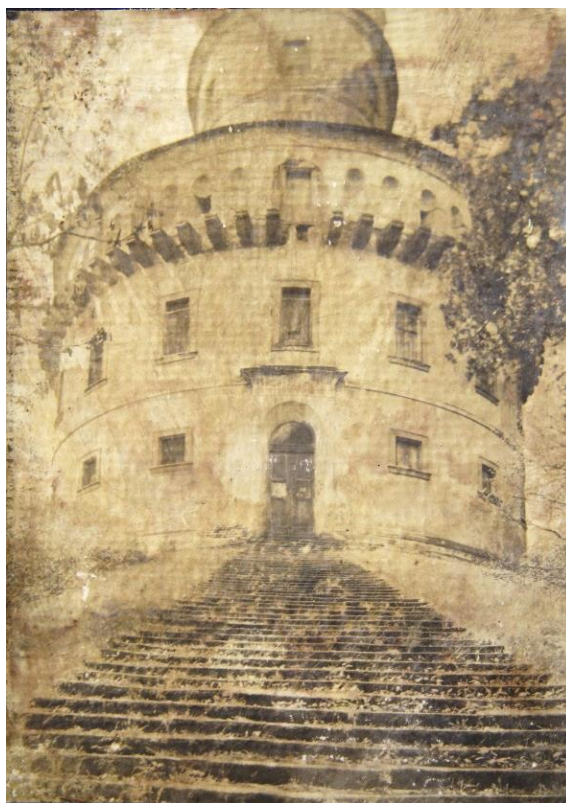
Obr. 17. Snímek z roku 1927 ukazuje zašlý stav budovy. Schody jsou zarostlé trávou, okna jsou zabetonována, krakorec uprostřed chybí.
