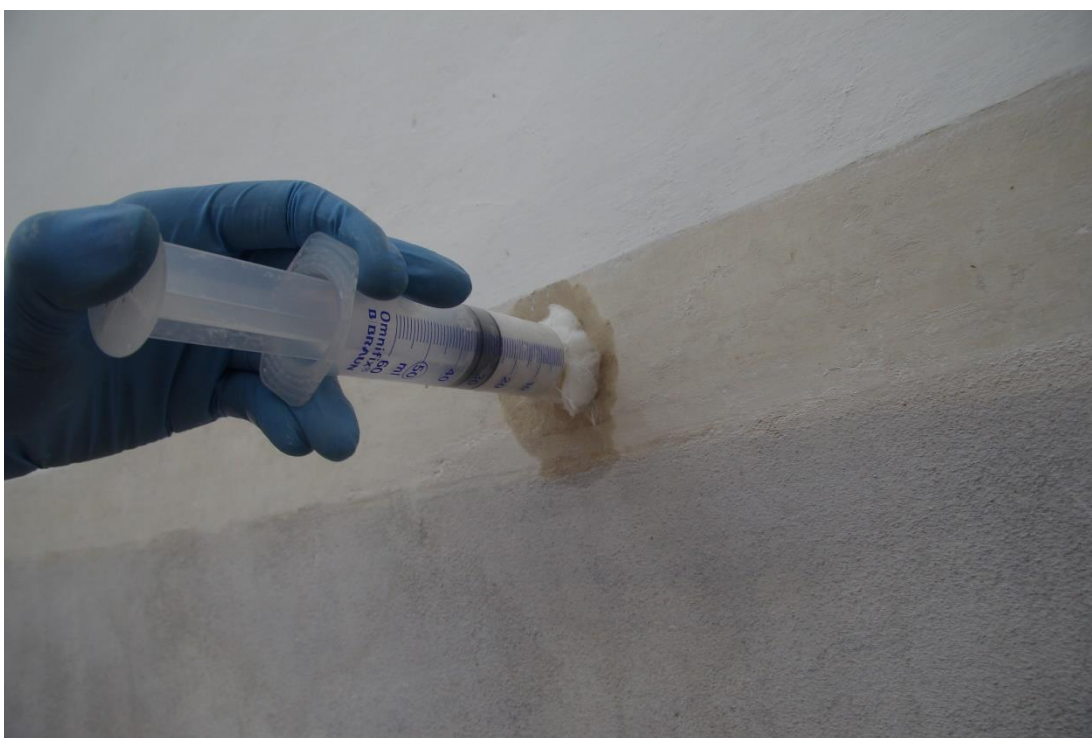
Obr. 76. Průběh injektování na horním pásu nad malbou, který byl odkryt do výšky 8 cm.
