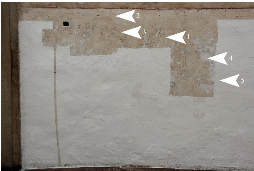
Obr. 4. Sonda 1SV 13 – výjev č. 4 (Zdroj: foto Anežka Beranová) 1) Historický štuk; 2) Okrový nátěr; 3) Linky iluzivního závěsu; 4) Druhotné sádrové vysprávky (překletování) v soklu; 5) Hlinkový nátěr
