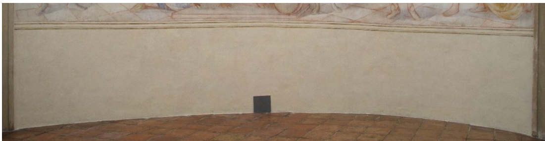
Obr. 88. Soklová část po nátěru vápennou barvou světle okrové barvy.
