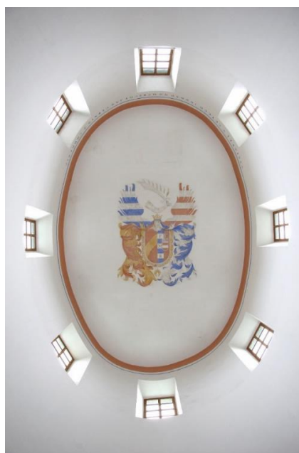
Obr. 29. Stav stěn hodovní síně po bílé výmalbě v roce 1995 stavební firmou Staving Valdice. Mezi stropem a okny se nachází malovaná linka s nápisem „Vystavěl v letech 1666 – 80 Humprecht Jan Černín z Chudenic“. (Zdroj: Foto Dagmar Faměrová)
