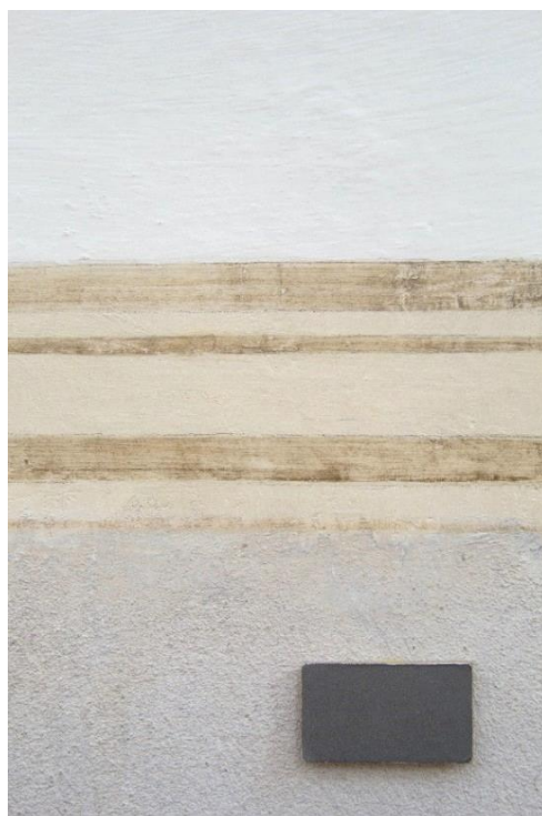
Obr. 82. Detail horního odkrytého pásu nad výjevem, který byl stejně jako sokl natřen vápenným okrovým nátěrem. Na nátěr byly pomocí malštoku namalovány linie v opačném pořadí než linie na soklové části.
