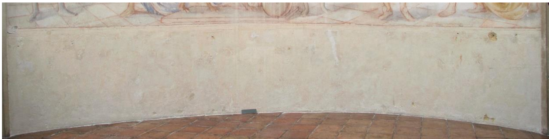
Obr. 86. Soklová část po odkryvu bílého hlinkového nátěru. Následovalo odstranění nevhodných vápenných, cementových a sádrových tmelů.
