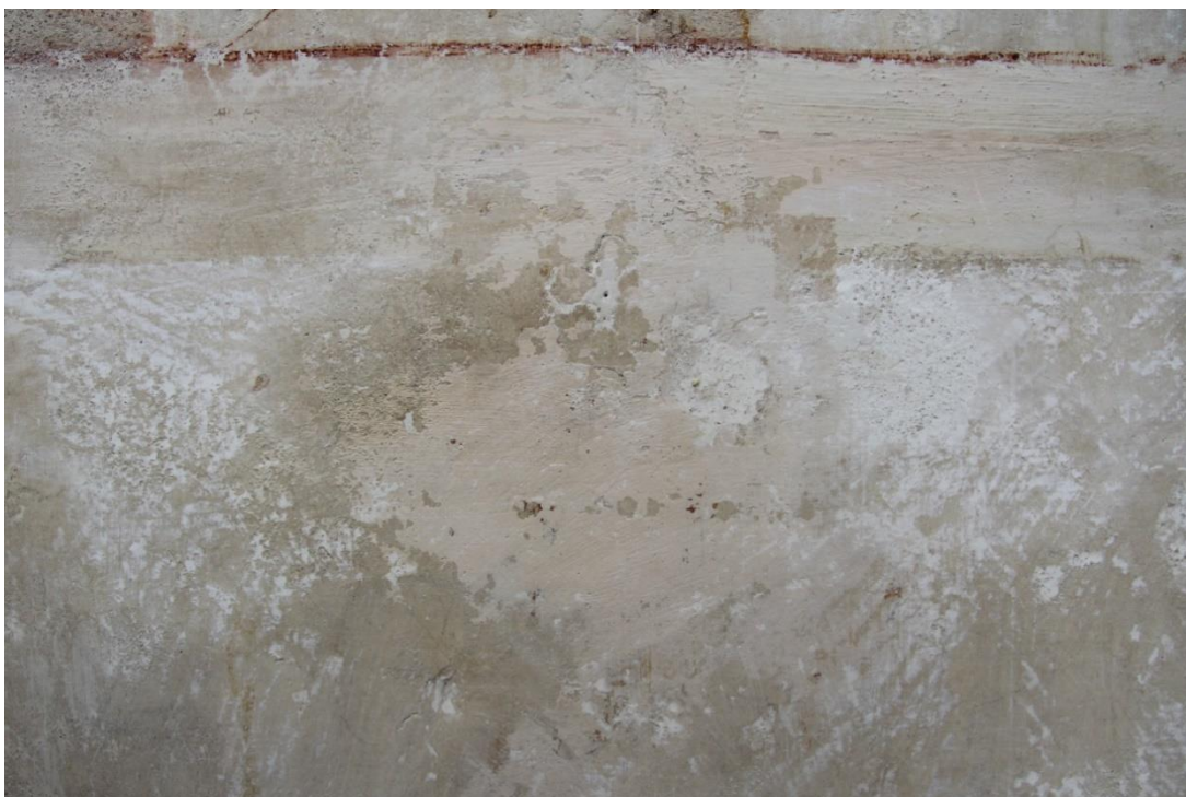
Obr. 73. Pracovní fotografie v procesu odkryvu bílého hlinkového nátěru. Z nálezů zbytků okrového nátěru bylo potvrzeno, že se nátěr nacházel na celé ploše soklové části. Na okrovém nátěru byly nanесeny linie zpodobňující iluzivní římsu.
