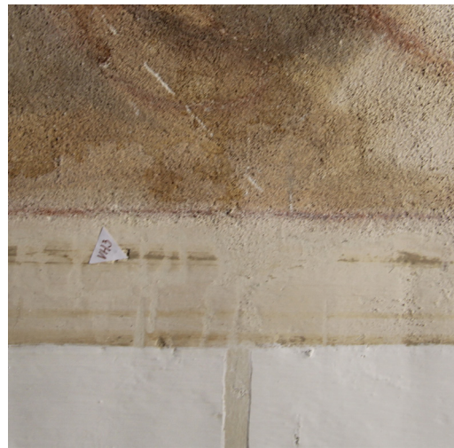
Obr. 8: Detail místa odběru vzorku VH3. SZ stěna. Foto a grafická úprava J. Lhoták.
