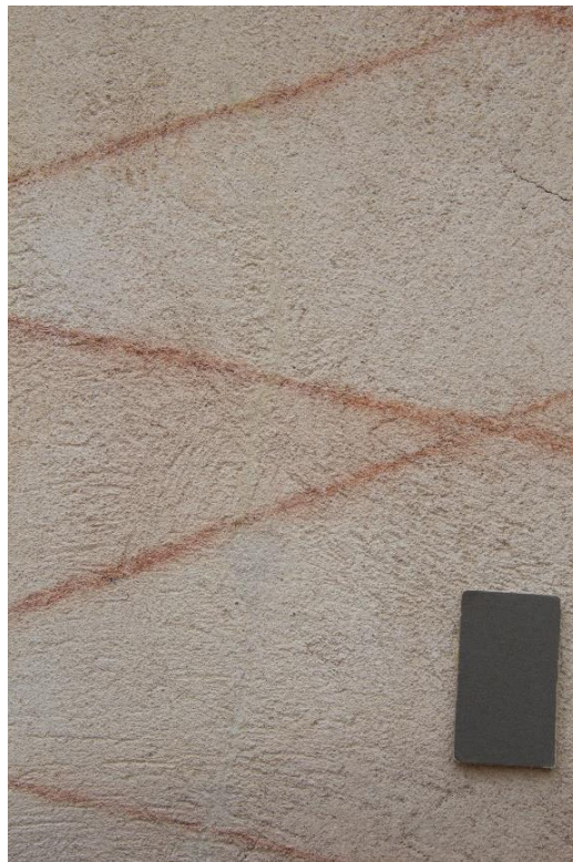
Obr. 56. Statická trhlina a malá sonda po vytmelení a retuši.
