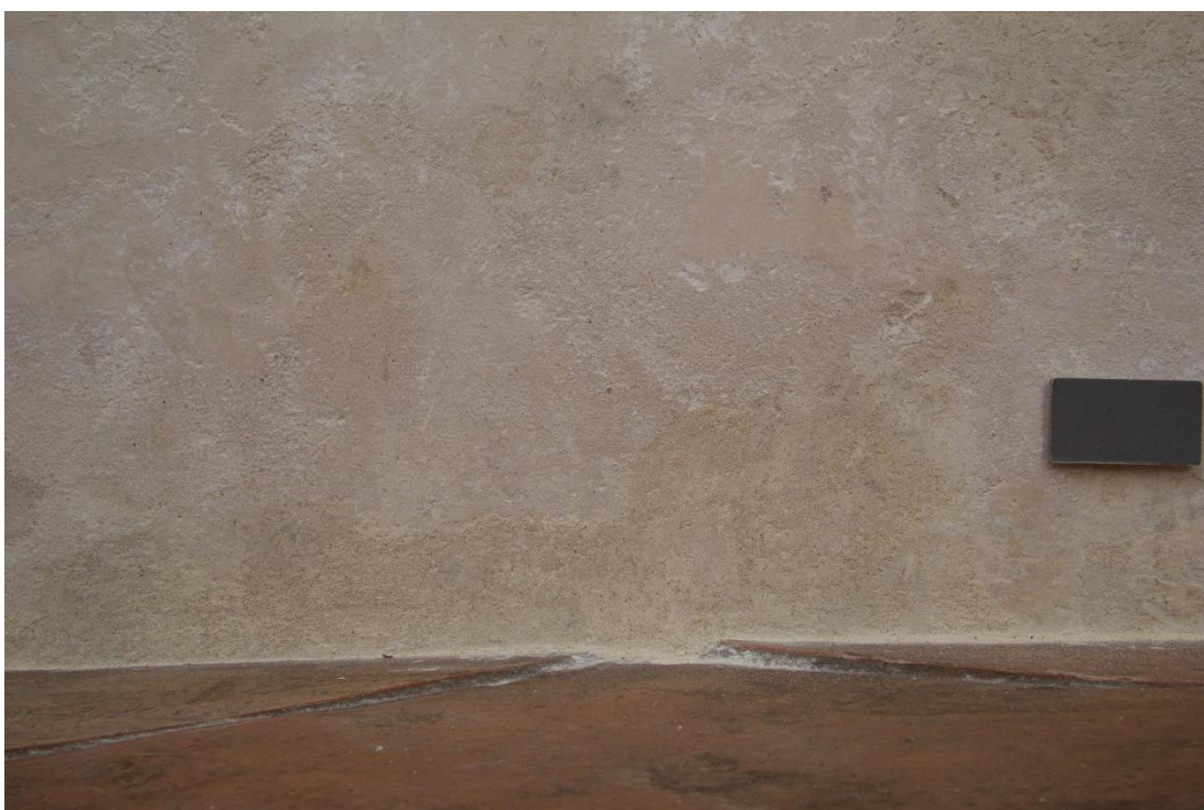
Obr. 80. Detail u podlahy po vytmelení. Tento světlejší tmel u podlahy vzniknul přidáním jemného žlutého písku a mramorové moučky k hořickému šedému písku pro lepší barevnost a zpracovatelnost vápenného tmelu.
