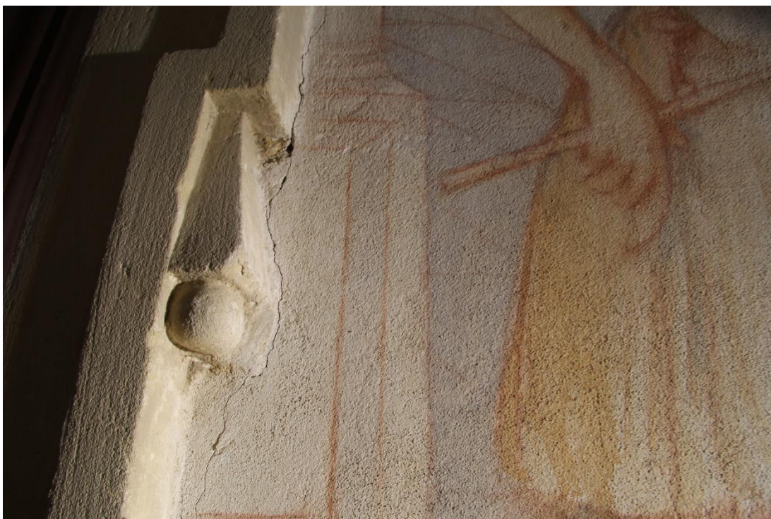
Obr. 53. Statická trhlinka u kamenného ostění dveří nasvícená bočním světlem.
