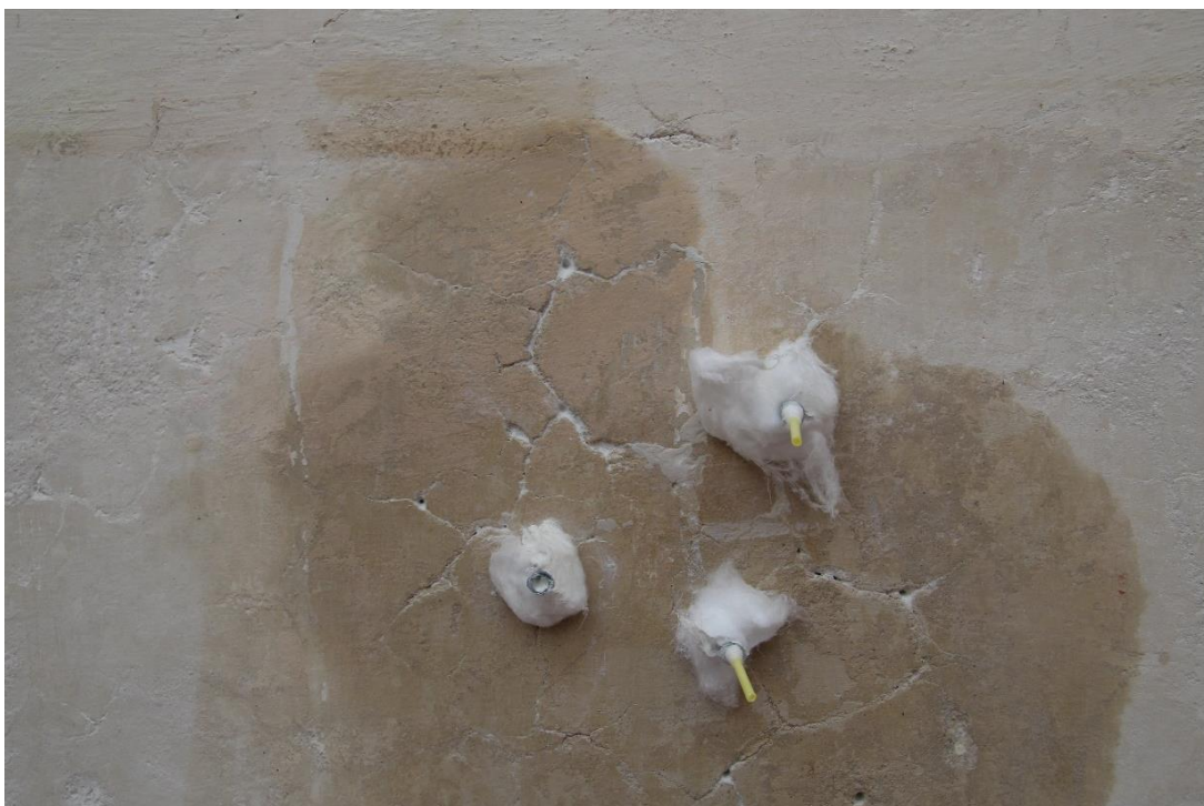
Obr. 75. Proces injektáže historického štuky, který v levé části na soklu vykazoval nedostatečnou adhezi k jádrové omítce.
