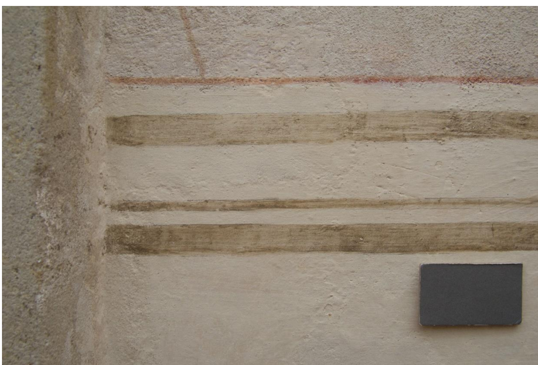
Obr. 84. Nový tmel sondy byl v rámci rekonstrukce natřen okrovým nátěrem a liniemi.
