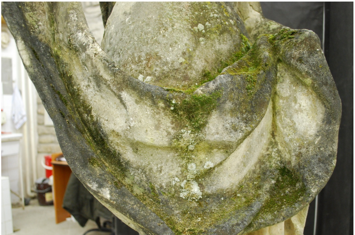
Obr. č. 9 – Vysoká míra biologického napadení
