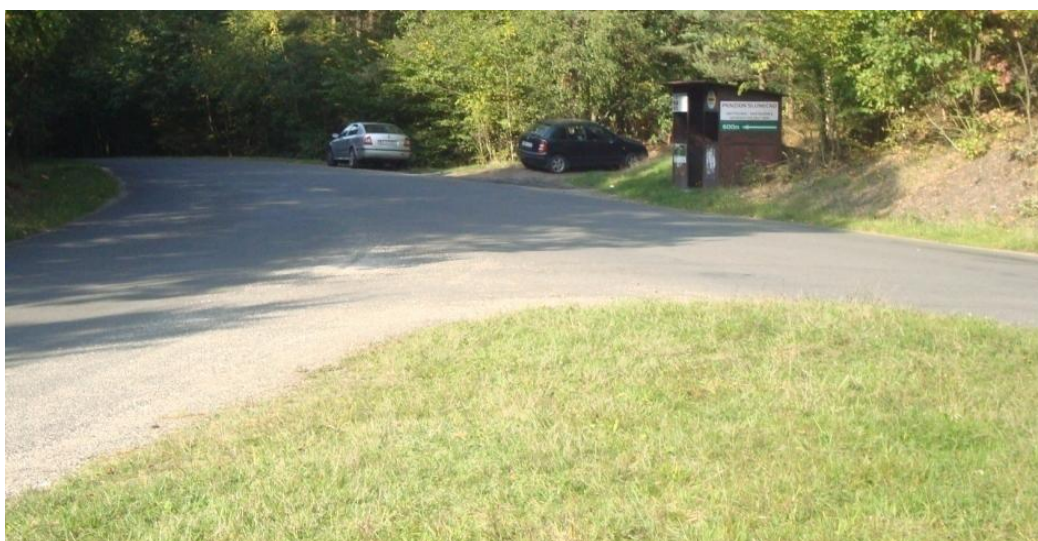
Obr. 52 Umístění autobusové zastávky - pohled k Žehrovu Zdroj autorka
