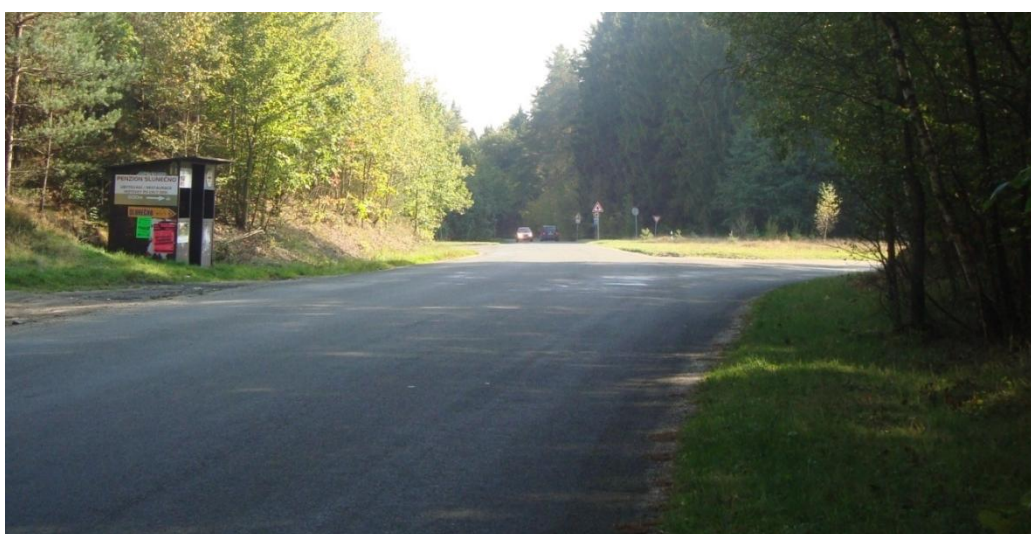
Obr. 53 Umístění autobusové zastávky - pohled od Žehrova Zdroj autorka
