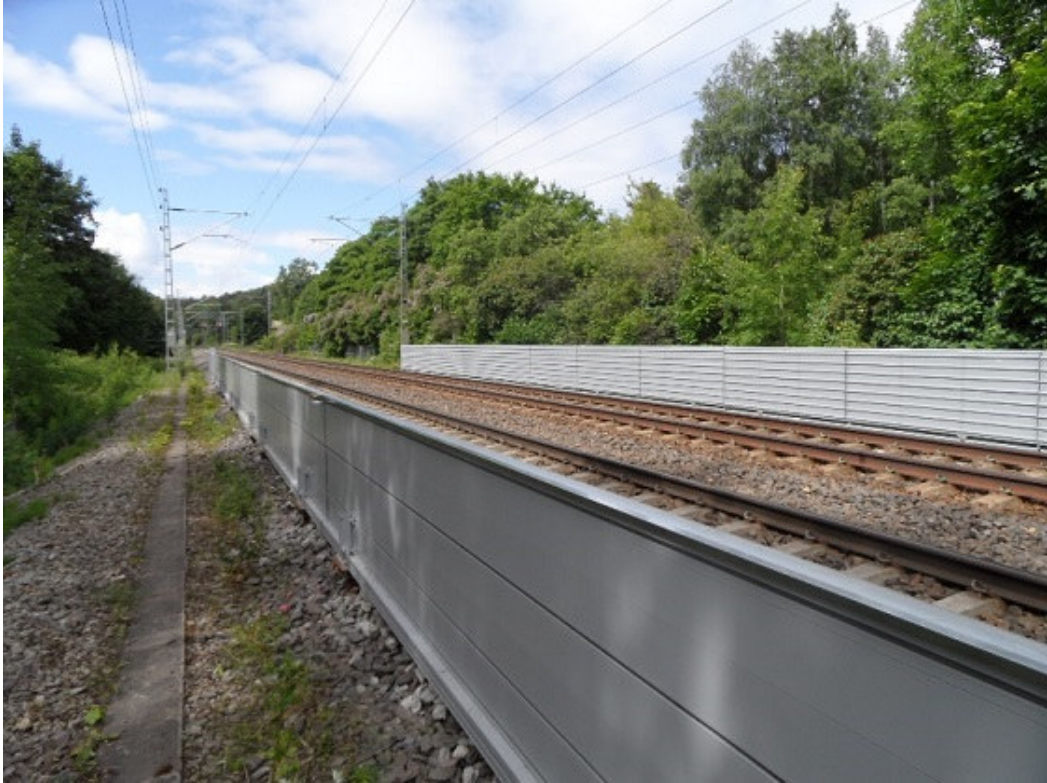
Obrázek č. 29 – nízká protihluková clona Soundim, Finsko (zdroj: http://www.soundim.fi/gb/references/ )
