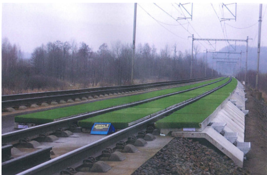
Obrázek č. 48 – kolejový absorbér typ BA-S ve druhém zkušebním úseku [12]
