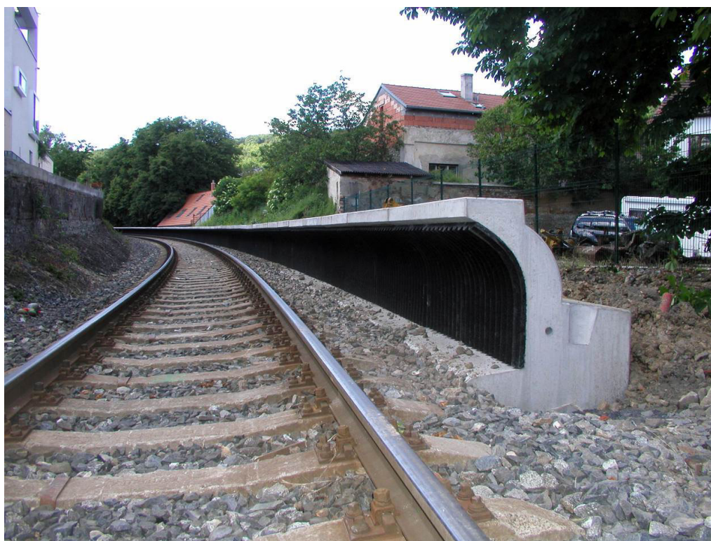
Obrázek č. 32 – NPHC realizovaná v Praze Hlubočepích (zdroj: ŽPSV a.s.)
