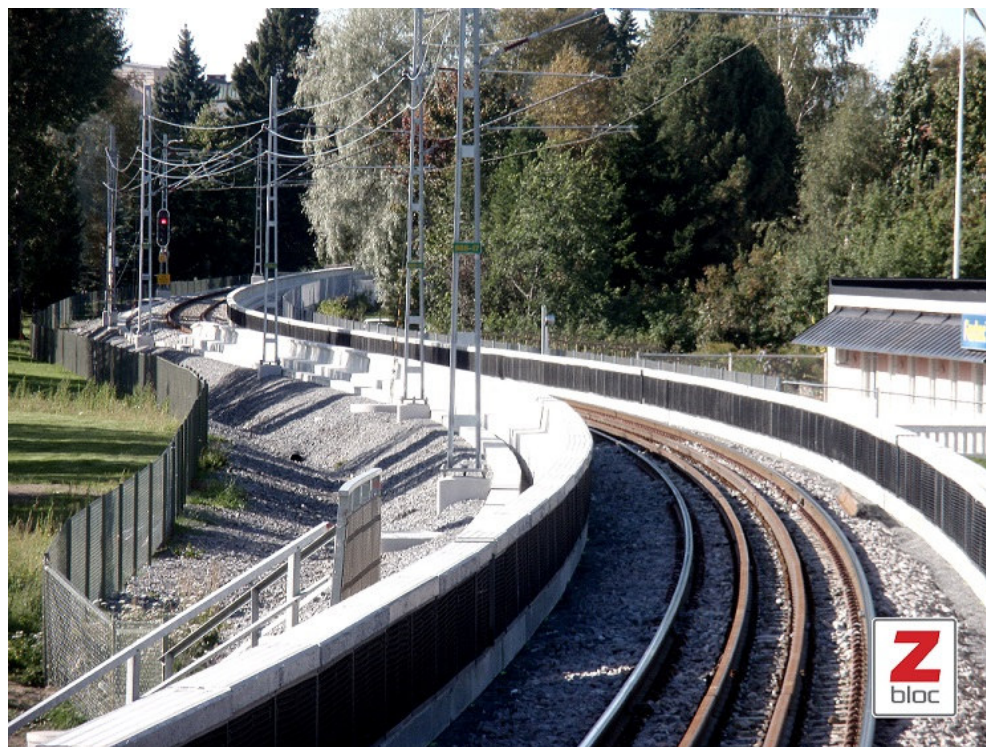
Obrázek č. 30 – nízká protihluková clona Zbloc, Švédsko (zdroj: http://www.zbloc-international.com/bilder/presse_2_gr.jpg )
