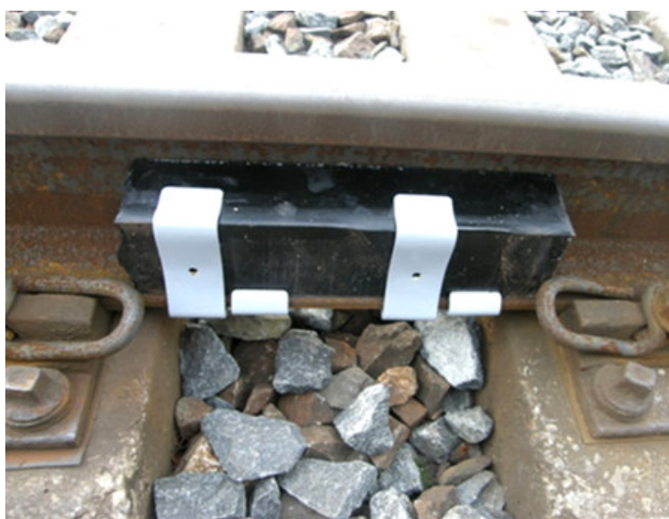
Obrázek č. 17 – kolejnicový absorbér Corus
