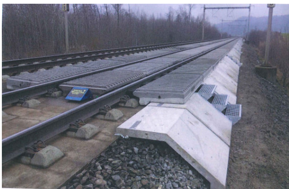
Obrázek č. 47 – kolejový absorbér typ BA v prvním zkušebním úseku [12]
