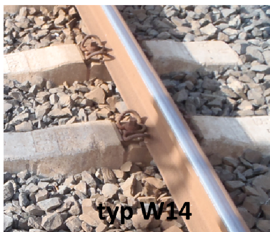
obrázek č. 15 – přímé pružné upevnění typ W14 (foto autor)
