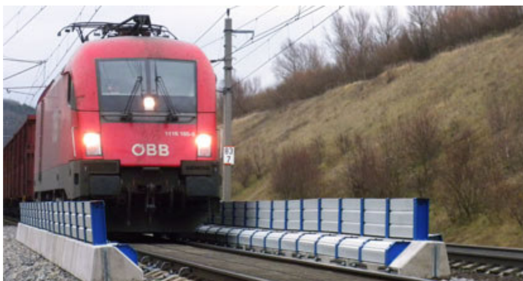
Obrázek č. 31 – nízká protihluková clona společnosti ART, Rakousko - Melk (zdroj: http://www.art.asamer.at/en/node/46 )
