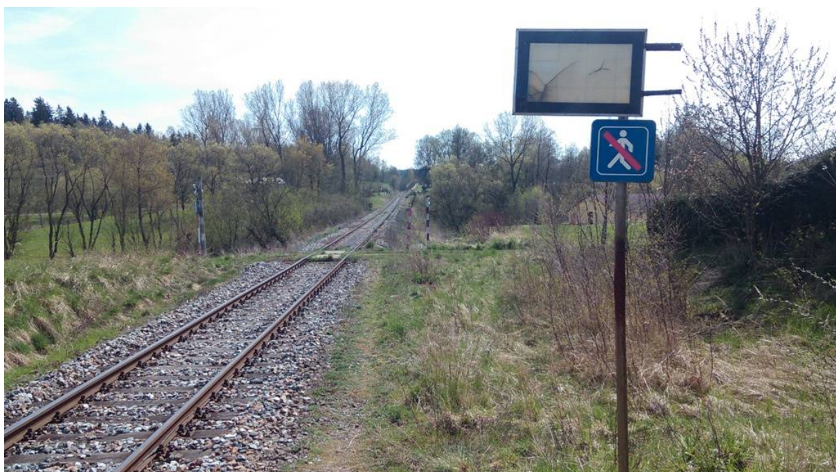
Obrázek 1 – Pohled na začátek upravovaného úseku za železniční stanicí Hodice.
