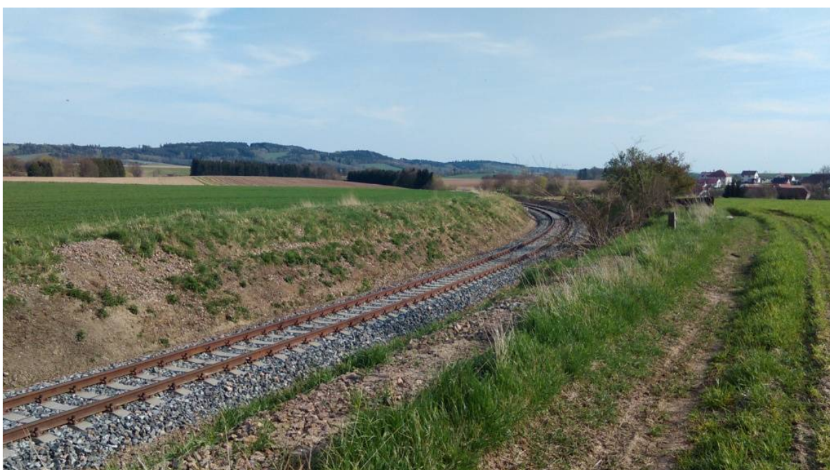
Obrázek 30 – Levotočivý oblouk o poloměru 224 m před železniční zastávkou Mysliboř.
