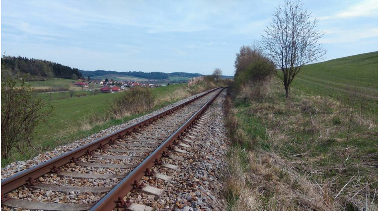
Obrázek 19 – Pohled na vedení trati před pravotočivým obloukem o poloměru 600 m.
