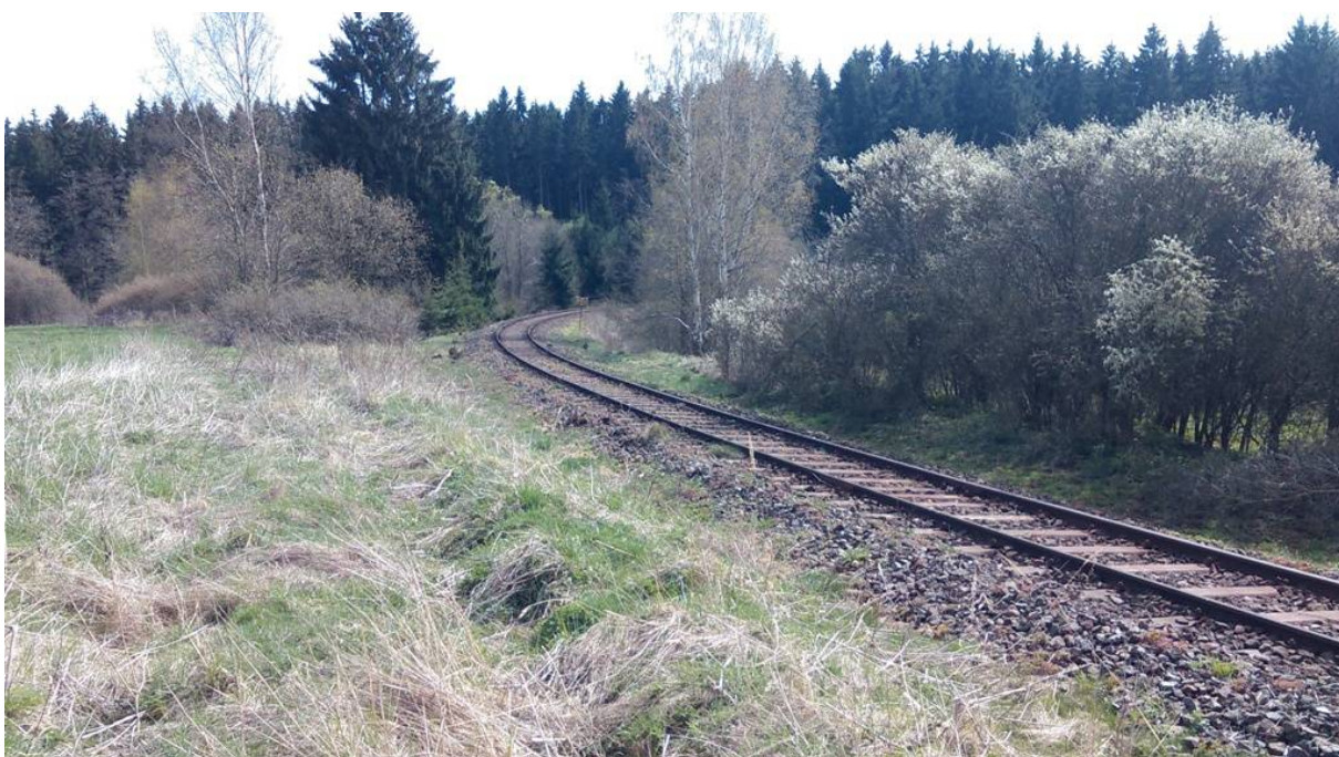
Obrázek 10 – Pohled na pravotočivý oblouk o poloměru 245 m u rybníka Díra.
