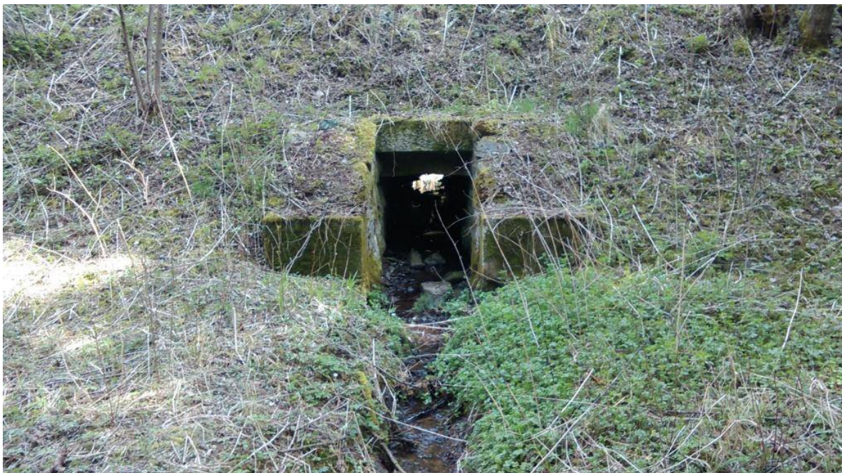
Obrázek 15 – Propustek v km 13.902000.
