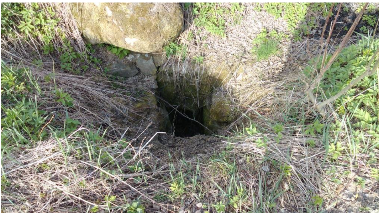
Obrázek 27 – Současný stav propustku v km 18.293000.
