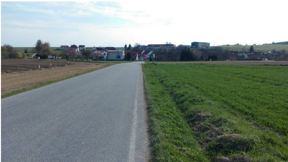
Obrázek 31 – Pohled na železniční přejezd v km 19.026000 před obcí Mysliboř.
