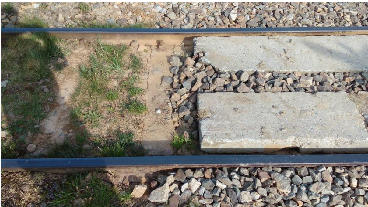
Obrázek 35 – Detail současného stavu přejezdu v úseku Mysliboř – Telč
