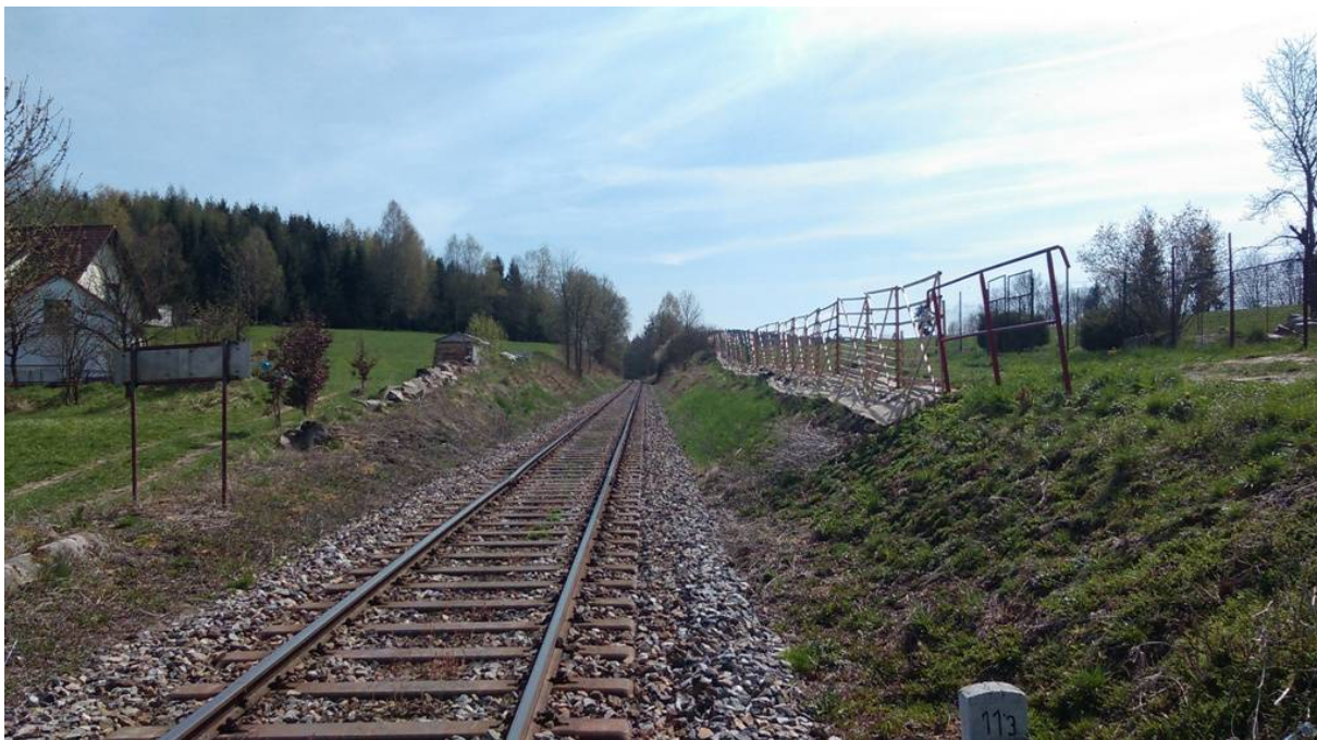
Obrázek 3 Pohled na zářez za železniční stanicí Hodice.
