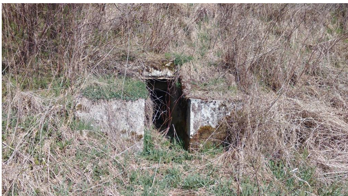
Obrázek 6 – Propustek v km 12.25000.
