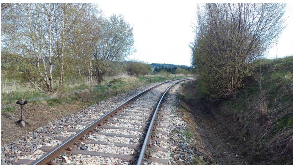
Obrázek 24 – Pravotočivý oblouk o poloměru 298 m za železniční stanicí Sedlejev.
