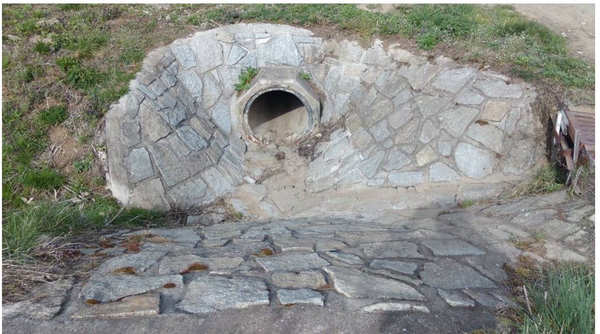
Obrázek 22 – Propustek v železniční stanici Sedlejev v km 16.590000.
