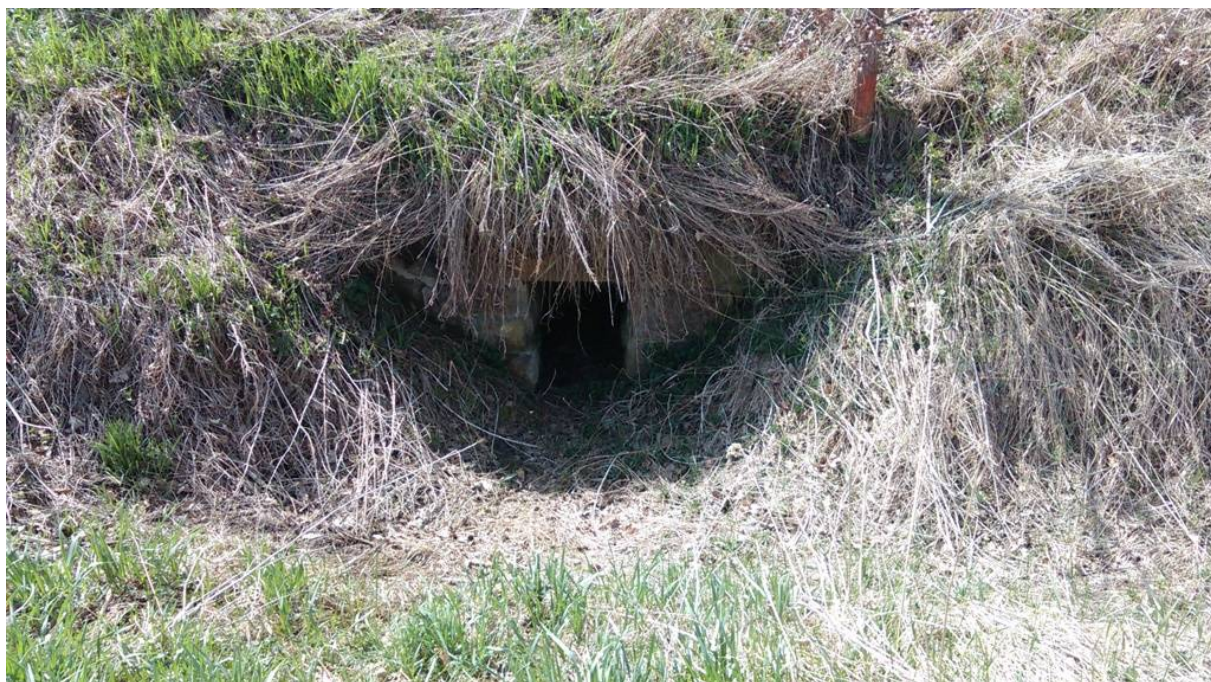
Obrázek 5 – Propustek v km 11.940000.
