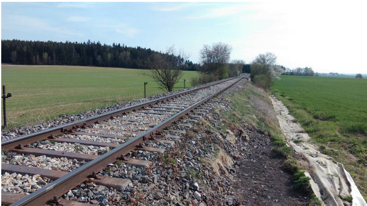
Obrázek 25 – Pohled na úsek tratí vedoucí v násypu za železniční stanicí Sedlejev.
