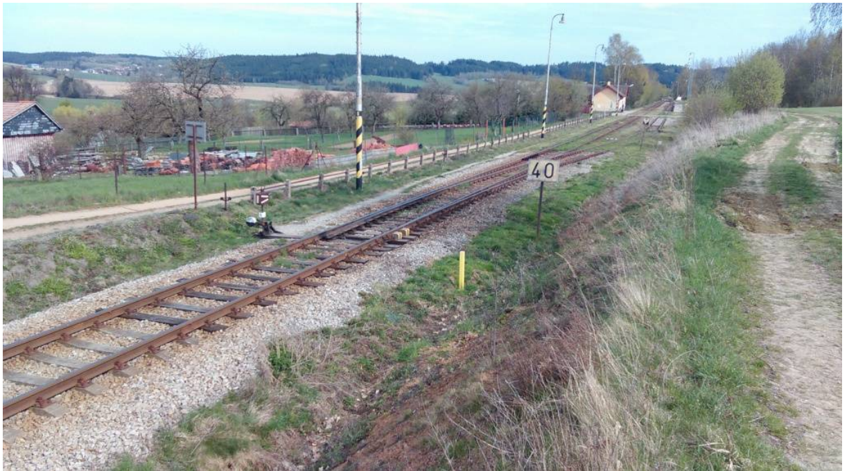
Obrázek 21 – Pohled na začátek železniční stanice Sedlejev.
