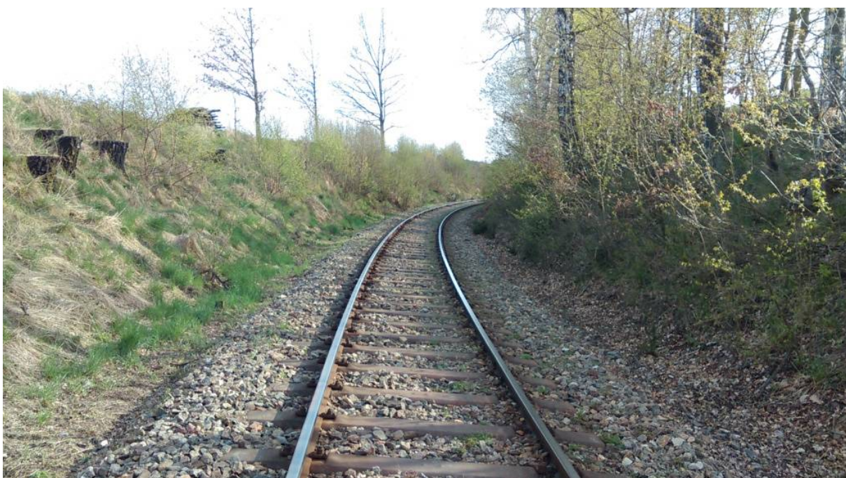
Obrázek 36 – Pravotočivý oblouk o poloměru 250 m
