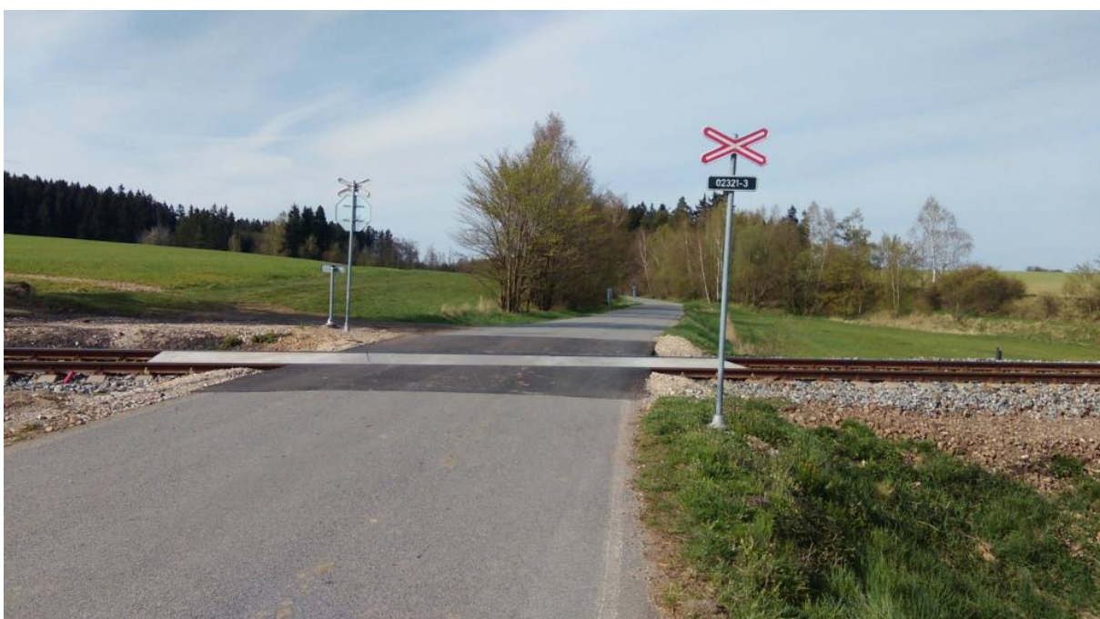
Obrázek 28 – Železniční přejezd v km 18.47700, pohled směrem k obci Sedlejev.
