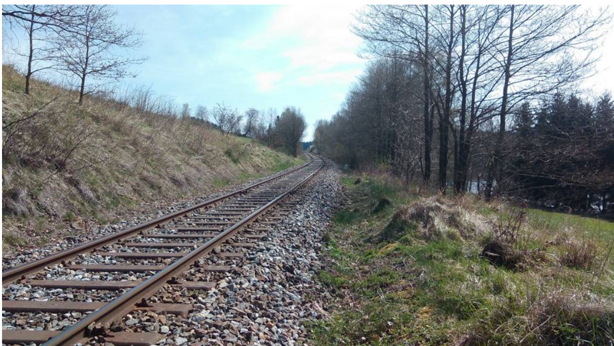
Obrázek 4 – Levotočivý oblouk o poloměru 1000 m
