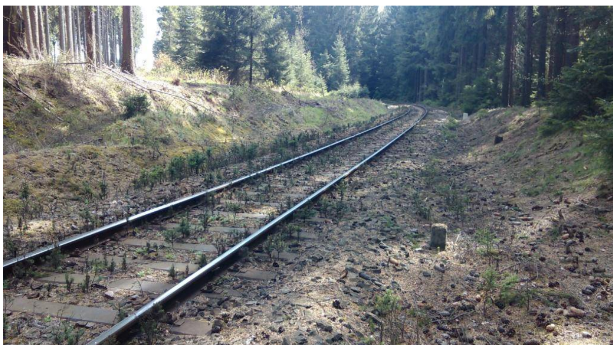
Obrázek 14 – Současný stav železničního svršku v levotočivém oblouku o poloměru 243 m.
