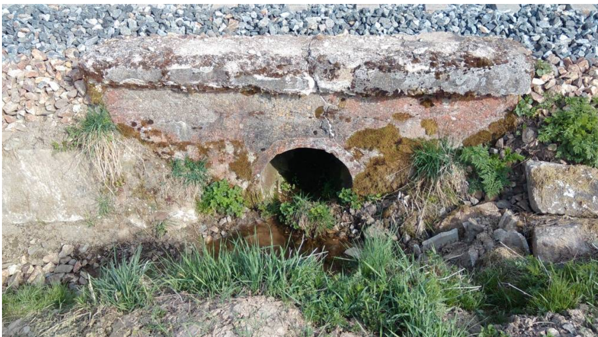
Obrázek 29 – Propustek v km 18.40700 m.
