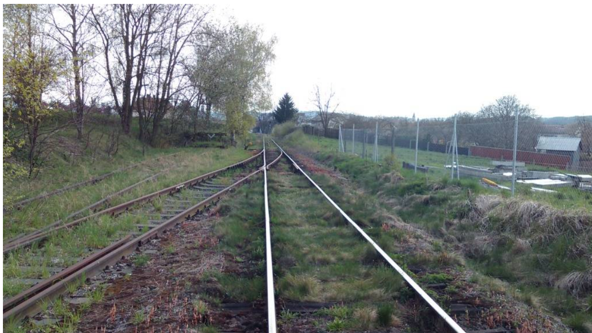
Obrázek 41 – Pohled na konec úseku v Telči.
