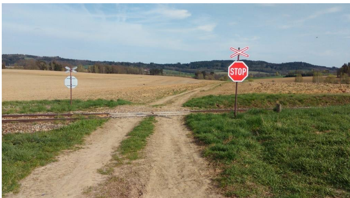
Obrázek 34 – Přejezd převádějící zemědělskou komunikaci v km 19.845000.
