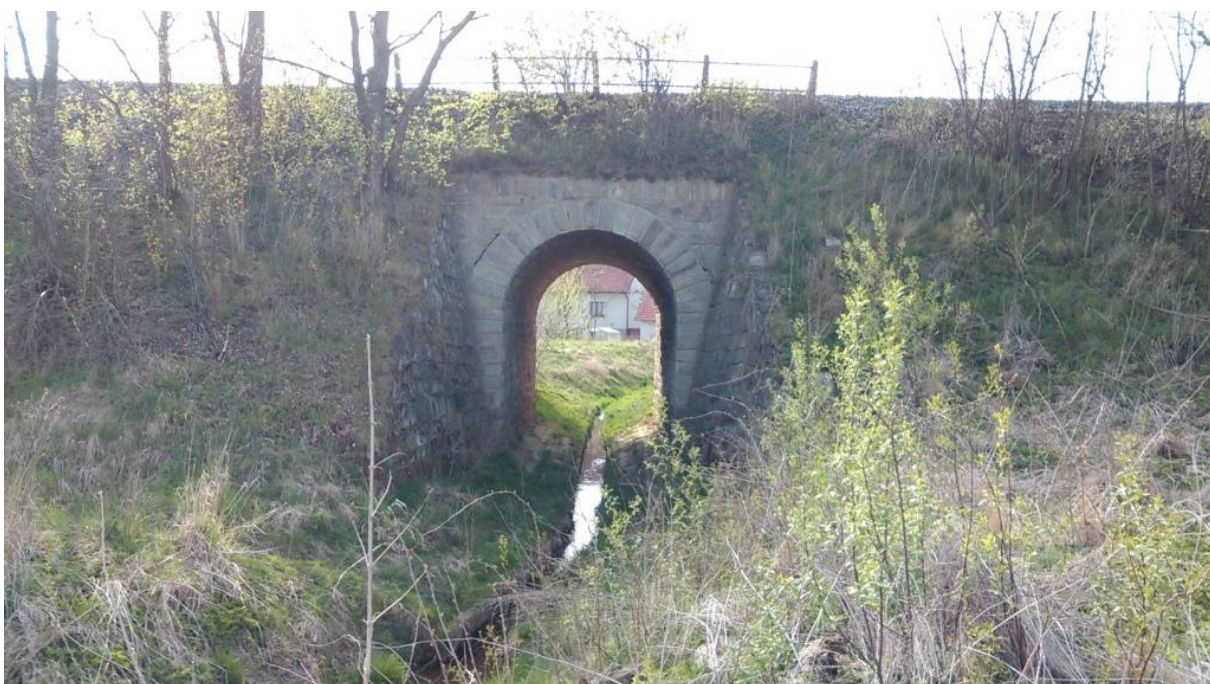
Obrázek 32 – Kamenný, obloukový, klenbový most v km 19.322000.
