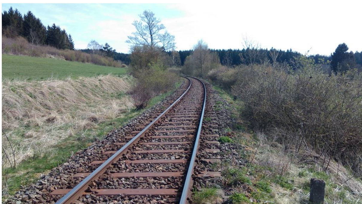
Obrázek 8 – Levotočivý oblouk o poloměru 280 m.
