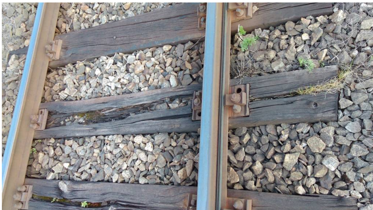
Obrázek 39 – Současný stav upevnění kolejnic v úseku od km 21.693000 až do konce v km 22.844530.
