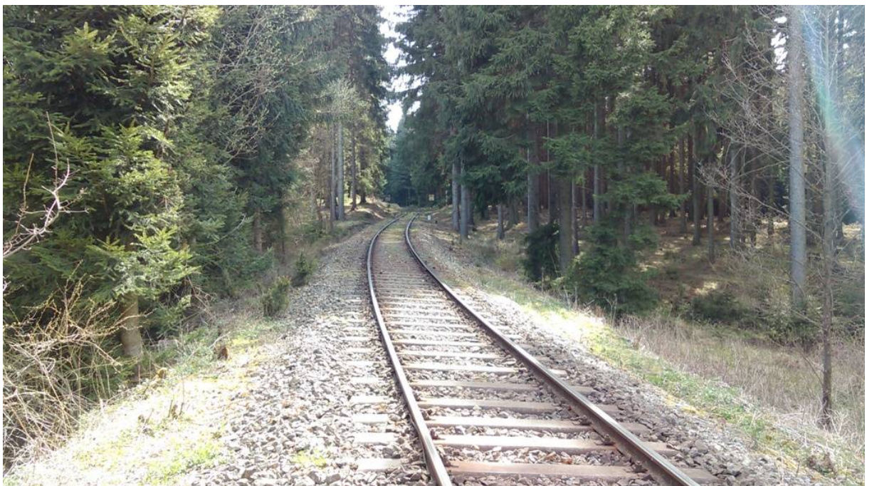
Obrázek 12 – Pohled na vstup trati do lesního porostu u rybníka Díra.
