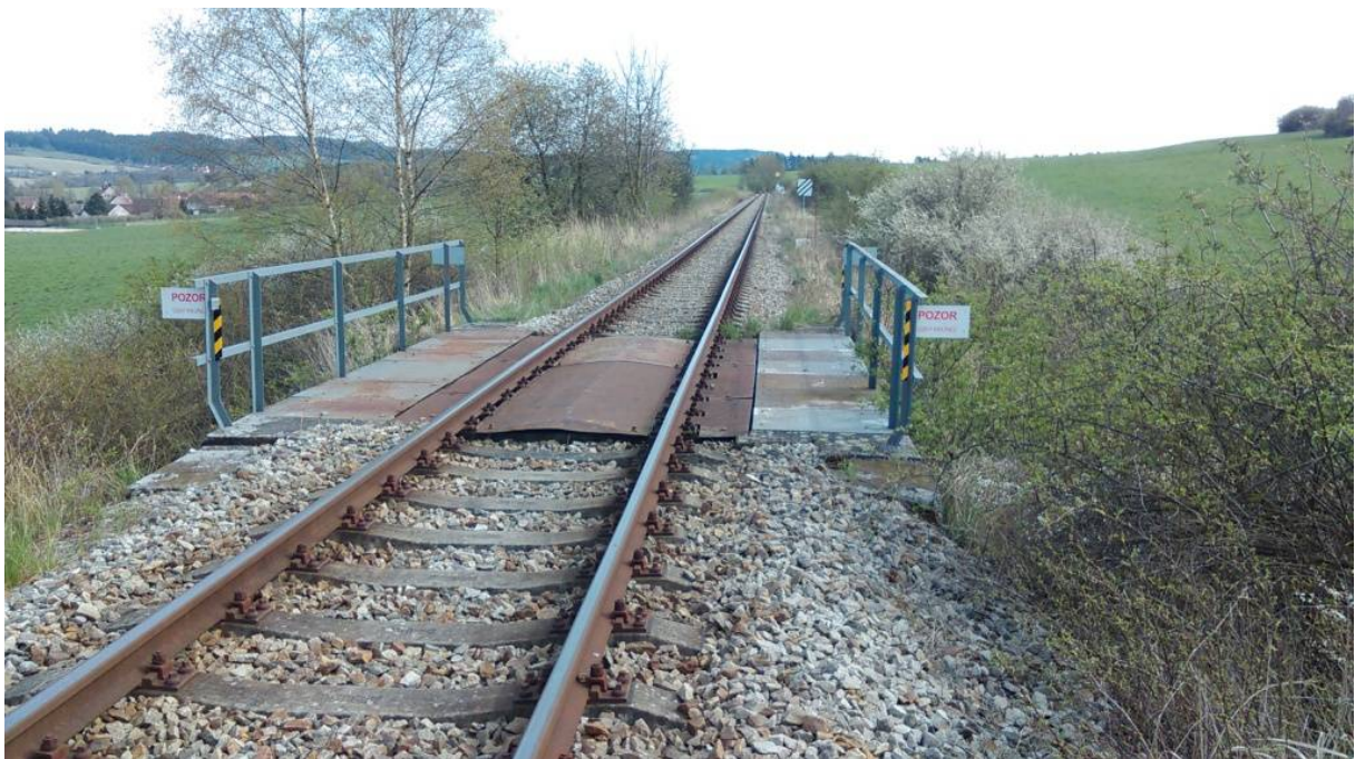
Obrázek 20 – Ocelový železniční most v km 15.573000.
