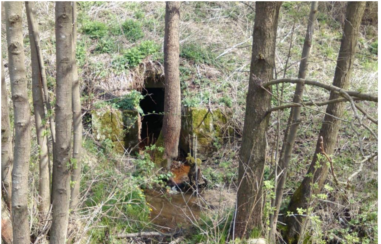
Obrázek 11 – Propustek v km 13.204.
