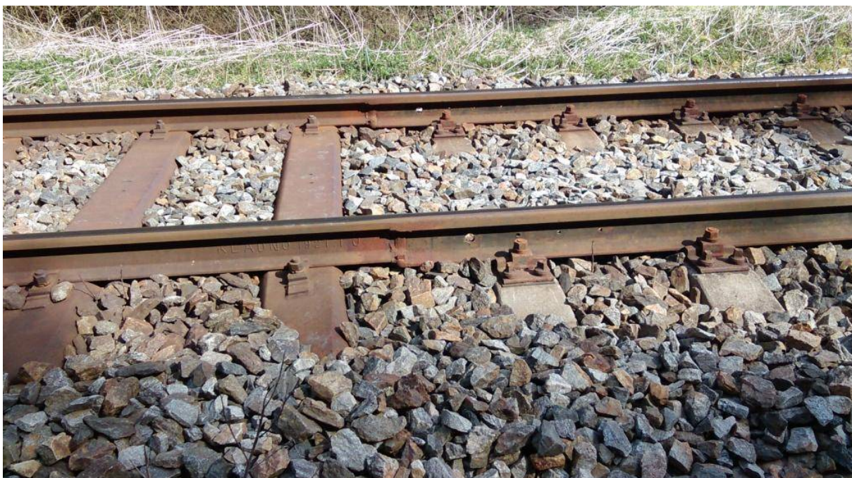
Obrázek 16 – Přejechod mezi tvarem kolejnice A a S 49 v km 13.972000.
