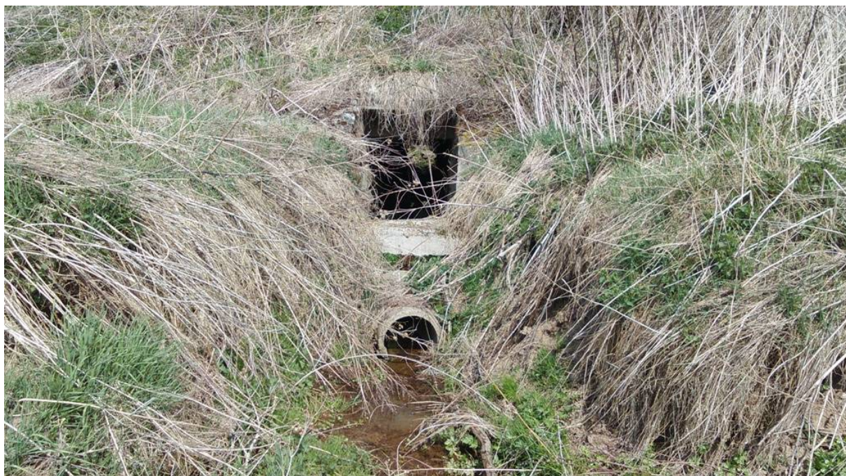
Obrázek 7 – Propustek v km 12.518000.
