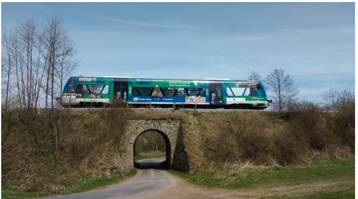
Obrázek 18 – Kamenný, obloukový most v km 15.076000.
