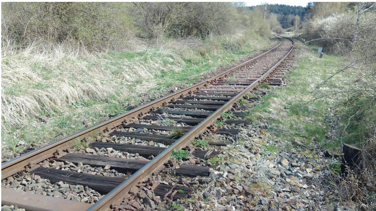
Obrázek 9 – Levotočivý oblouk o poloměru 455 m.
