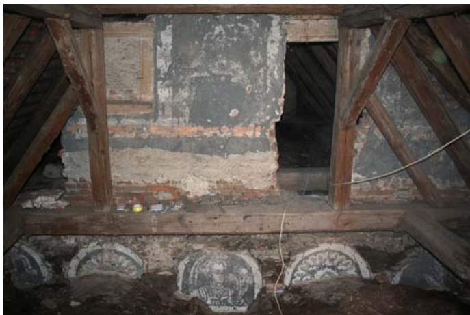
Obr. 17 G/ Červená Řečice, půda. Štít se zbytky lunetových výsečí, částečně krytých klenbami a v zásypu.
