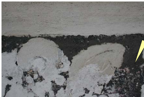
Obr. 222 Výjev 5. Drobné fragmenty nátěrů pod korunní římsou.
