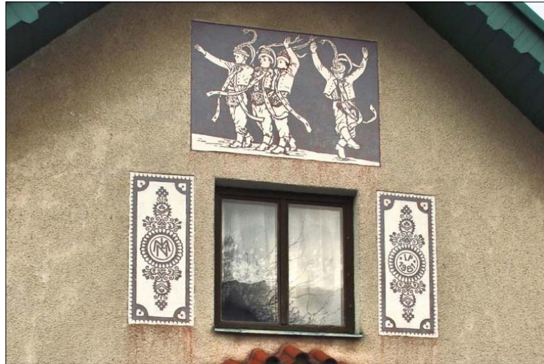
Obr. 182 Obec Šidleny, Jižní Morava – Sgrafito se dvěma vrstvami intonaca colorata.
