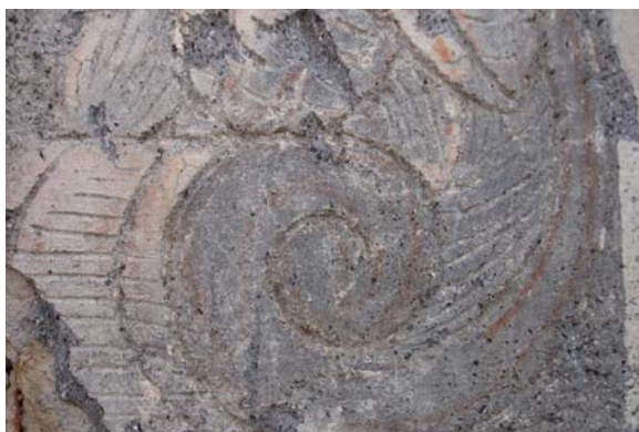
Obr. 154 B/ Voluta stínovaná prokletováním (foto Václav Špale).
