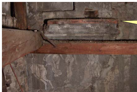
Obr. 171 F/ Červeně akcentované čelo římsy.
