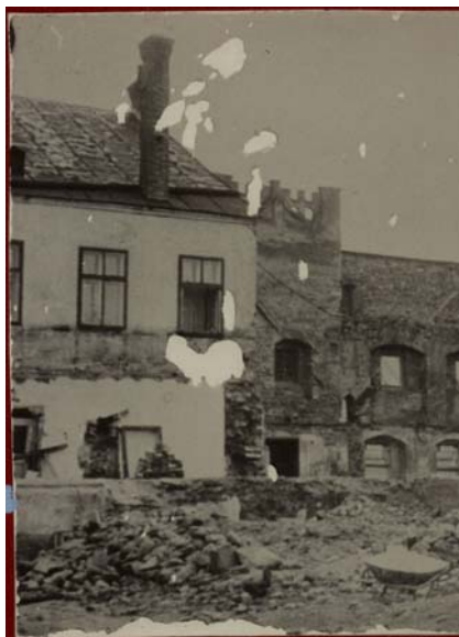
Obr. 200 Pohled zezadu na ubourané domy a volně stojící fasády, 50.léta. Patrný otisk nízkých střech a zadrženy chrlič v patře. ( http://www.slavonice-zlabings.eu ).
