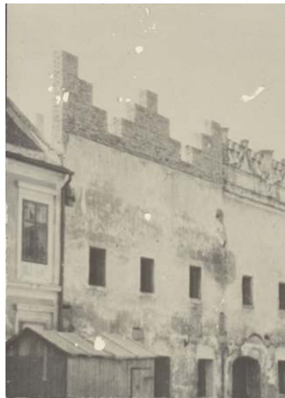
Obr. 201 Pohled na dům č.p. 536 a 537, 60.léta. Nově vystavěná atika vedlejšího domu, patrně za fasádami jsou již nově přistavěné domy. Obnovený vstupní portál a okna v přízemí v původní dispozici. Obnoven chrlič v patře. (Archiv MU Slavonice, neutříděno).
