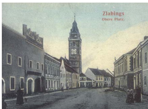
Obr. 197 Horní náměstí. Novější foto (vedlejší domy bez atiky, čtvercové hodiny na věži). Vstup domu v přízemí původní, okna upravená. ( http://www.slavonice-zlabings.eu ).
