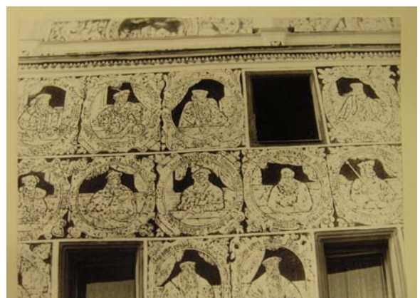
Obr. 228 Levá strana fasády. Po zásahu 1990. Došlo k razantnímu zvýšení kontrastu. (archiv města Slavonice a.č. 2787).
