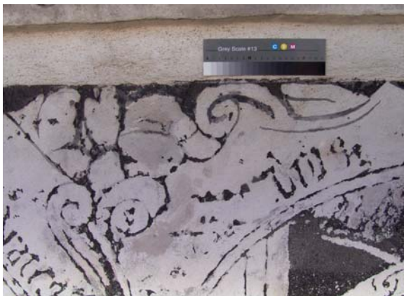
Obr. 231 Výjev 2. Stav před restaurováním. Rekonstrukce ornamentu v rohu rámu.
