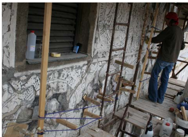
Obr. 240 Medailón 6. Průběh injektáže, tlakovací mechanismus.
