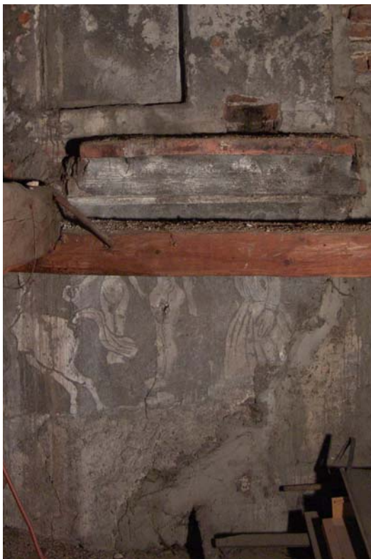
Obr. 15 F/ Prachatice č.p. 28. Celkový pohled, sgrafito skryté za trámem.
