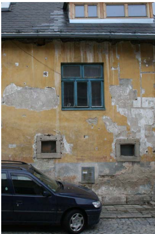
Obr. 13 E/ Slavonice č.p. 535. Částečně odkryté fragmenty sgrafita.
