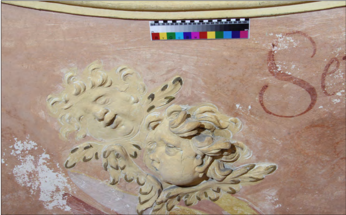
Obr. 14. Štuková výzdoba, výskyt primárních trhlin.
