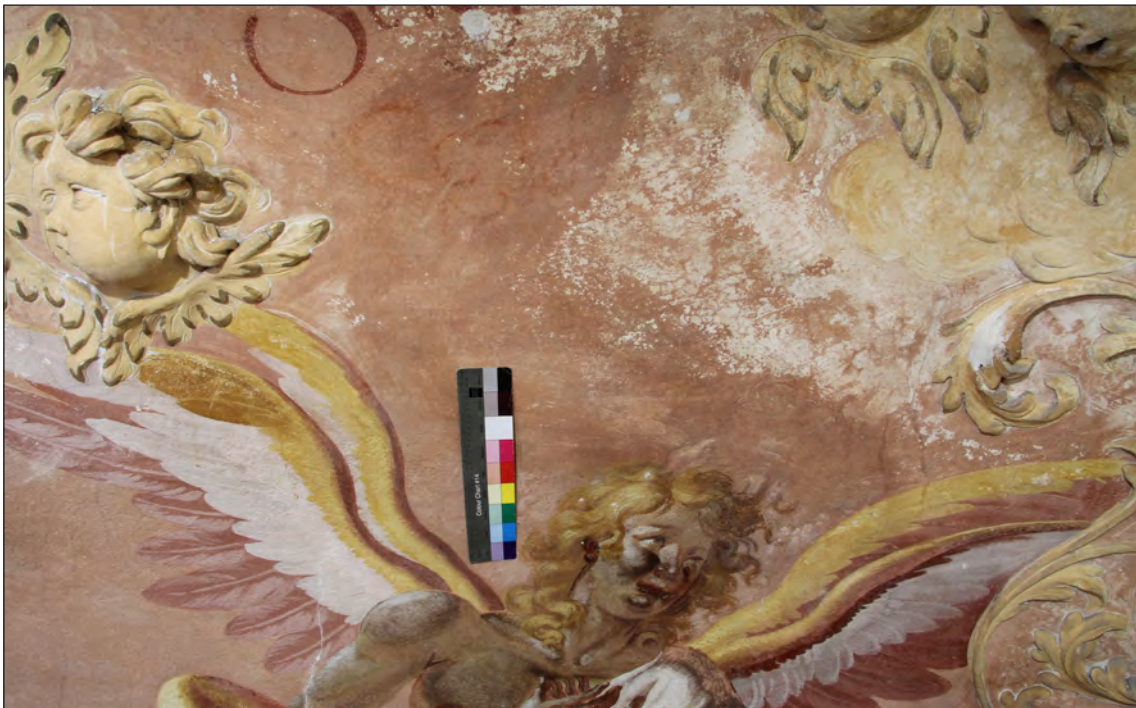
Obr. 23. Seraphim (detail), stav v průběhu restaurování, tmelení chybějící omítkové vrstvy a prasklin.
