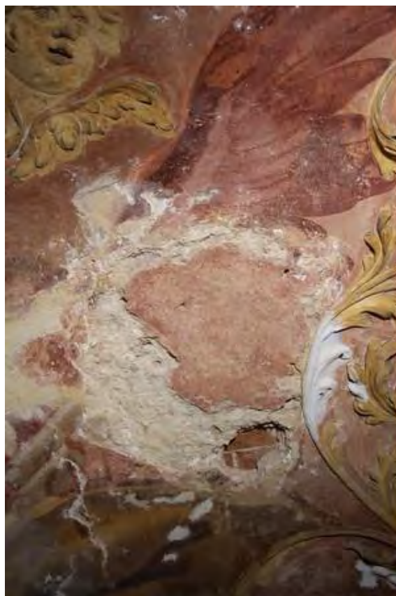
Obr. 157 Místo odběru vzorku 7575 (O3). Současný stav po odstranění tmelu z roku 2004, který překrýval druhotný tmel i okraje původní barevné vrstvy.
