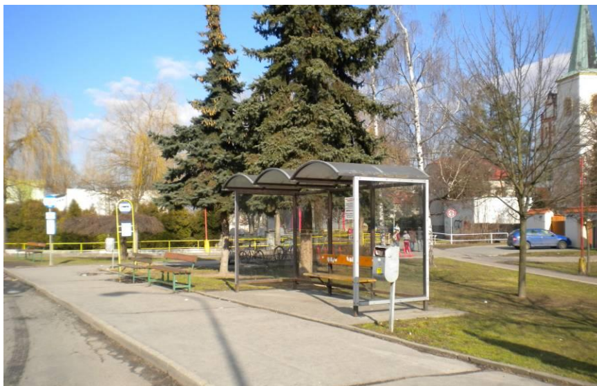
Obrázek 4 – Přístřešek na nástupišti východní části autobusového nádraží
