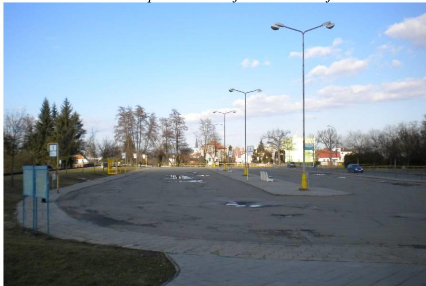
Obrázek 9 – Pohled na západní část autobusového nádraží
