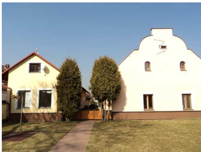
Obrázek 4: Budova Azylové centra Trojlístek
