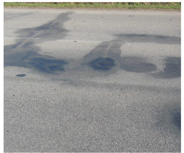
Obrázek 14 Stanoviště č. 5 (foto autor)
