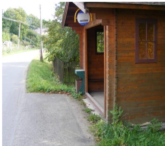
Obr. 38: Domanín, stanoviště směr Železniční stanice
