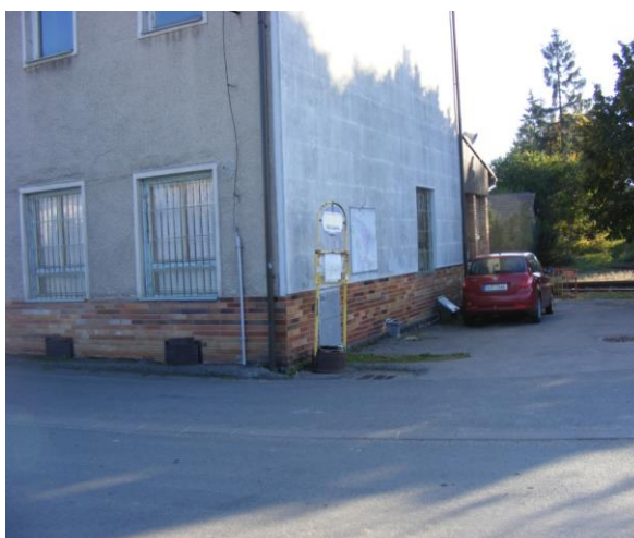
Obr. 5: Železniční stanice – směr Domanín
