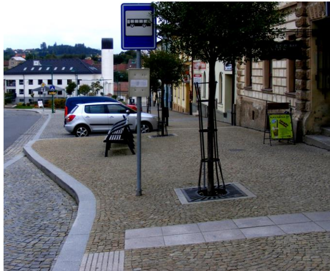
Obr. 17: Masarykovo nám, stanoviště směr Železniční stanice
