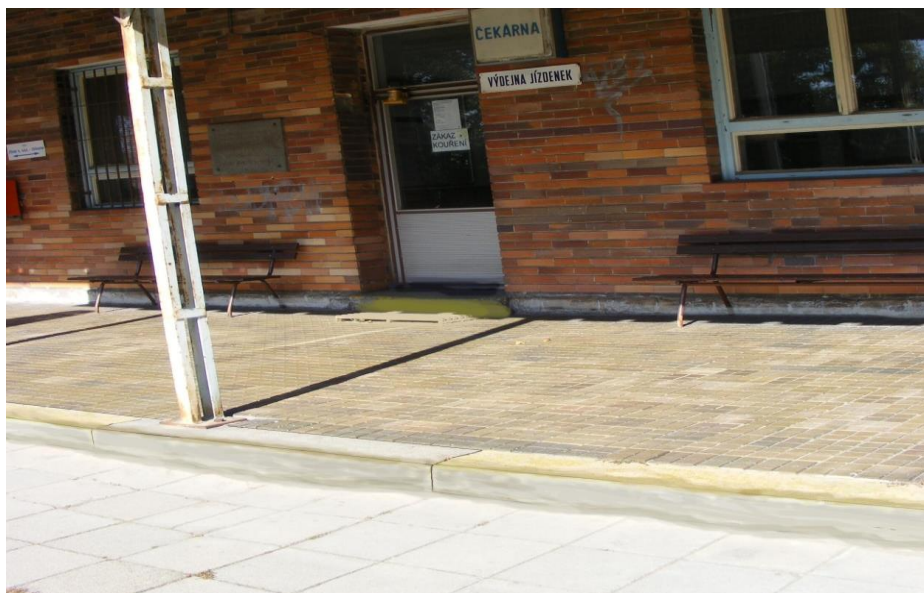
Obr. 2: Schody na cestě do čekárny železniční stanice
