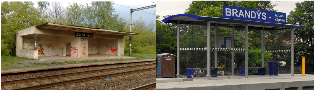
Obrázek č. 44, 45- přístřešek pro cestující před a po rekonstrukci
