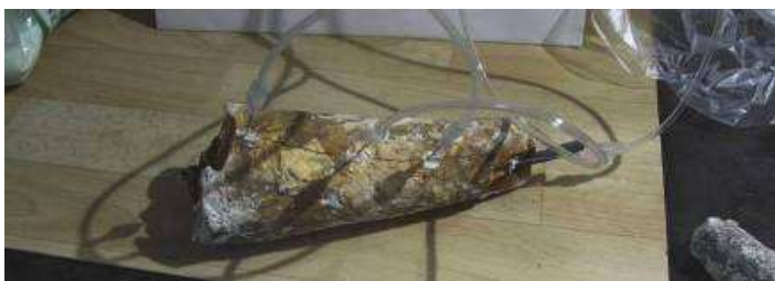
Obrázek 34 Madona Injektáž čepu inhibítorem koroze přes prasklinu
