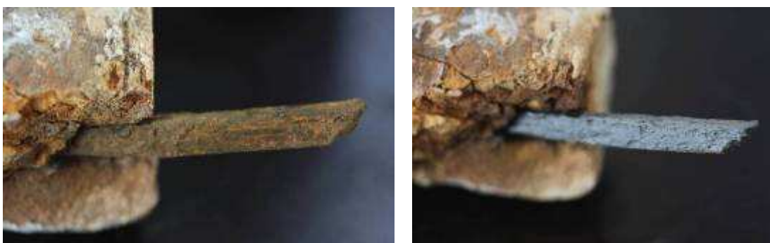
Obrázek 32 Madona Ošetření kovového čepu – stav před (vlevo) a po otryskání a ošetření povrchu inhibítorem koroze
