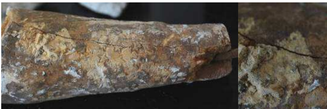
Obrázek 31 Madona Poškození vzniklé korozi železné armatury – prosáknutí rzi celým materiálem, prasklina vzniklá pnutím korodovaného čepu, barevný posun polychromie
