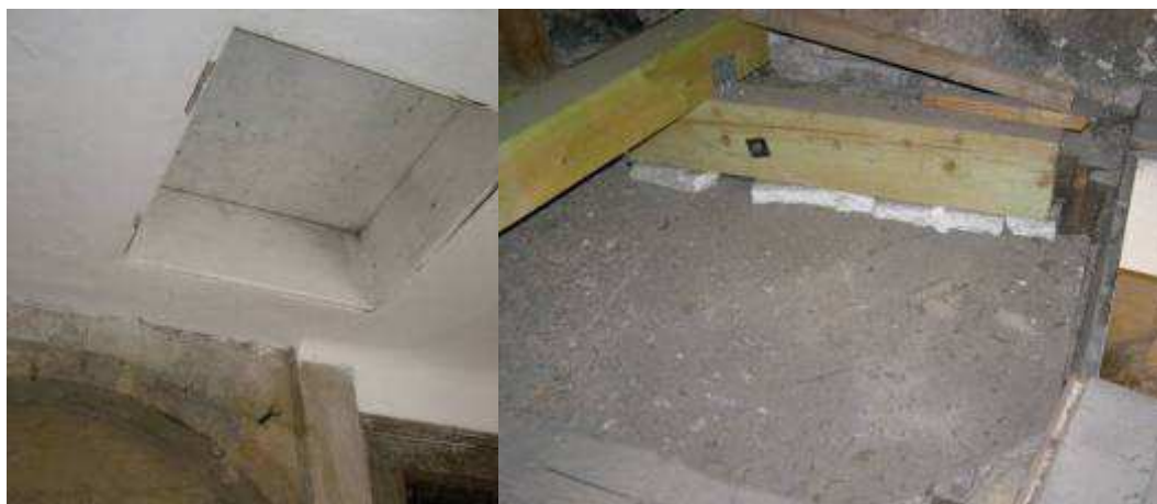
Obrázek 53 Reliéf Prostor nad místností s reliéfem – otvor na půdu a detail provedení stropu místnosti (foto: Ing. Petr Justa)
