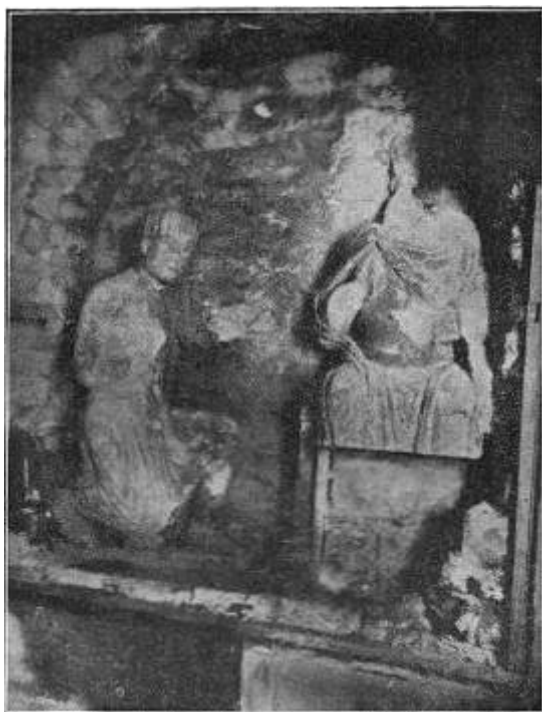
Obrázek 49 Reliéf Stav po nalezení v roce 1889 – je zde patrný předmět u paty klečícího, hlava už je oddělená a nika je popadaná (In: Novotný, Umělecké památky, Karlův most, 1917 )
