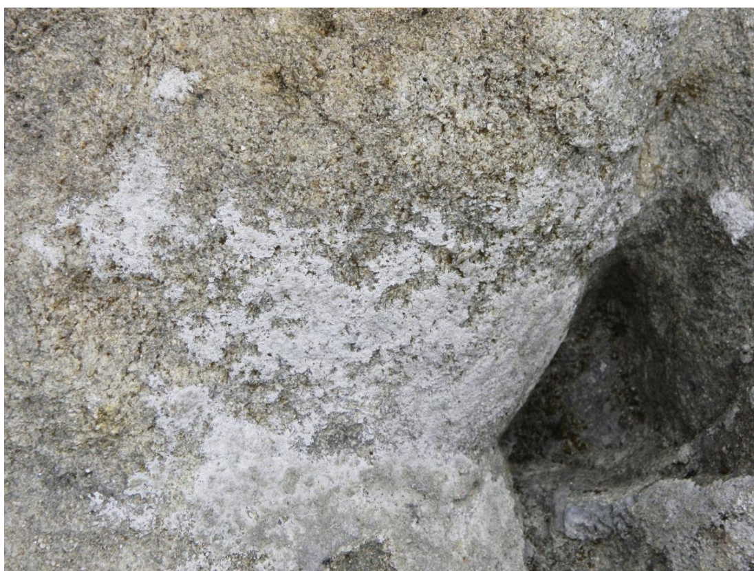
Obr. 126: Detail trupu v oblasti levého podpaží sochy; stav po sejmutím biogenních zbytků
