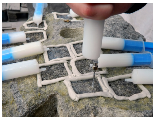
Obr. 90: Aplikace konsolidantů pomocí injekční stříkačky a jehly o průměru 1,6 mm
