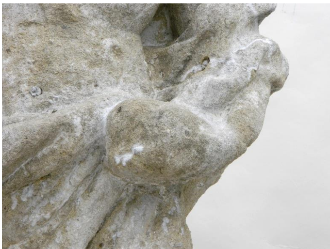
Obr. 150: Detail levé ruky světice – stav po konsolidaci
