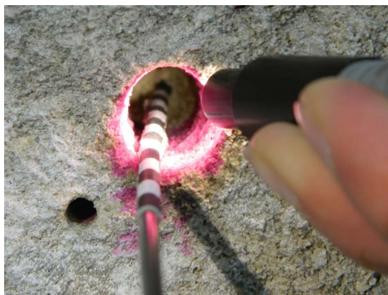
Obr. 98: Měření hloubky penetrace konsolidantu pomocí testu roztoku fenolftaleinu ve vrtu zhotoveném po konsolidaci – bílé i černé dílky na měřící tyčce odpovídají 1 cm
