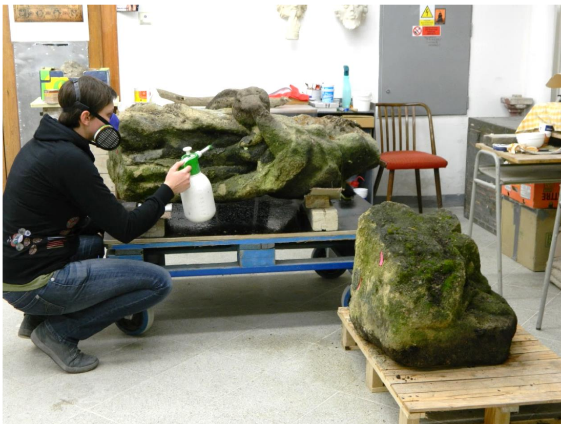
Obr. 107: Sanace biogenních růstů v aktivní fázi růstu biocidním prostředkem
