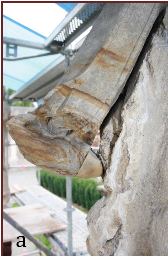
Obrázek 28a: Pohled na pískovcový doplněk a jeho vsazení, Obrázek 28b: Injektáže.
