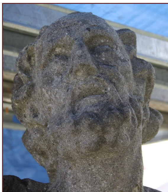
Obrázek 4: Hlava světce, znečištění tmavými deposity, biologické poškození, ztráta modelace vlivem srážkového deště.
