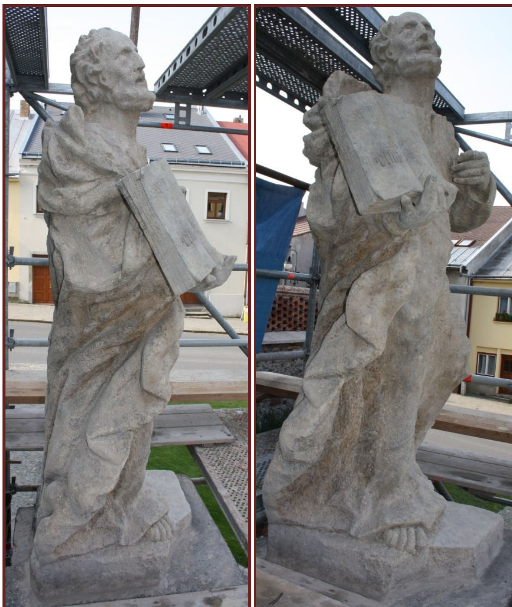
Obrázek 41: Socha sv. Pavla – celkový pohled po dokončení prací.
