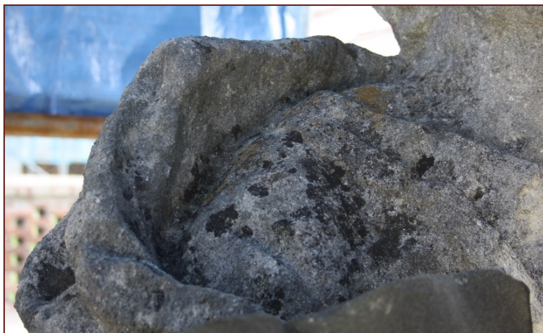
Obrázek 6: Detailní pohled na pravé rameno světce, poškození – tmavé deposity z ovzduší, biologické poškození.
