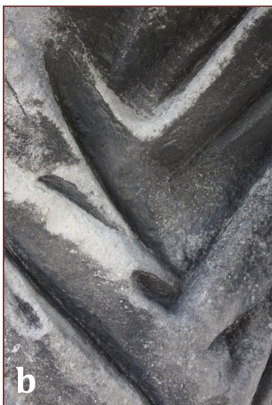
Obrázek 8a: Zadní část sochy, poškození tmavou krustou, Obrázek 9b: Detail tmavé krusty a poškození povrchu modelace.
