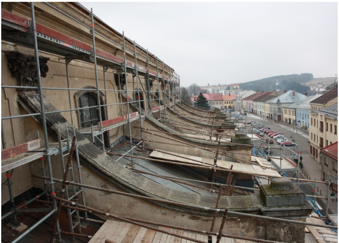
Obrázek 50: Pohled z lešení na jižní stranu v průběhu rekonstrukce, před zahájením prací, v roce 2011; podstavce pro osazení soch apoštolů (foto: Müllerová M.).
