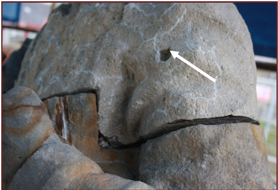
Obrázek 29: Pohled po očištění a provedení injektáží prasklin, pohled na pískovcový doplněk a jeho vsazení do vápence v pravidelném opracování, zalévací kanálek.
