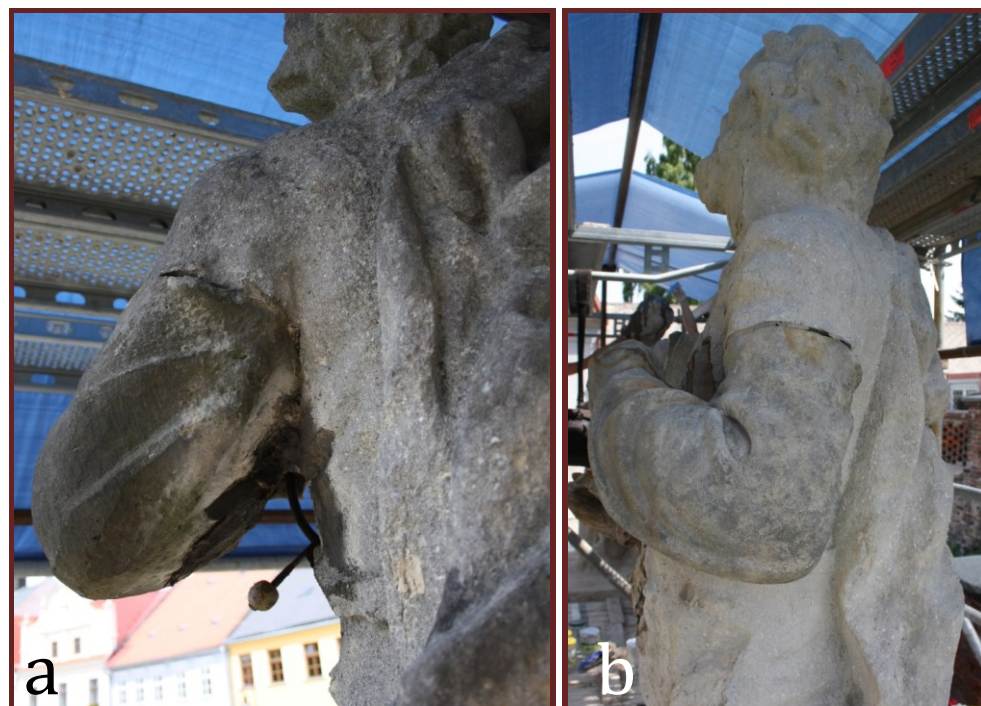
Obrázek 19a: Pohled zezadu - před započítím prací, Obrázek 20b: Pohled po očištění.
