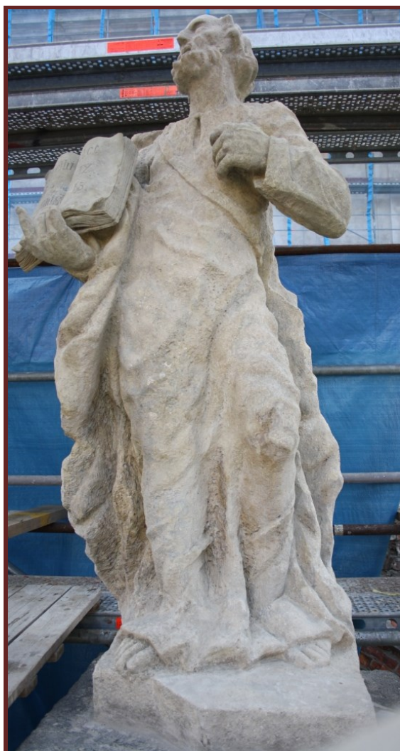
Obrázek 36: Socha sv. Pavla – pohled po doplnění chybějících částí (druhotné doplňky z jemnozrnného pískovce byly barevně přizpůsobeny originálnímu vápenci).
