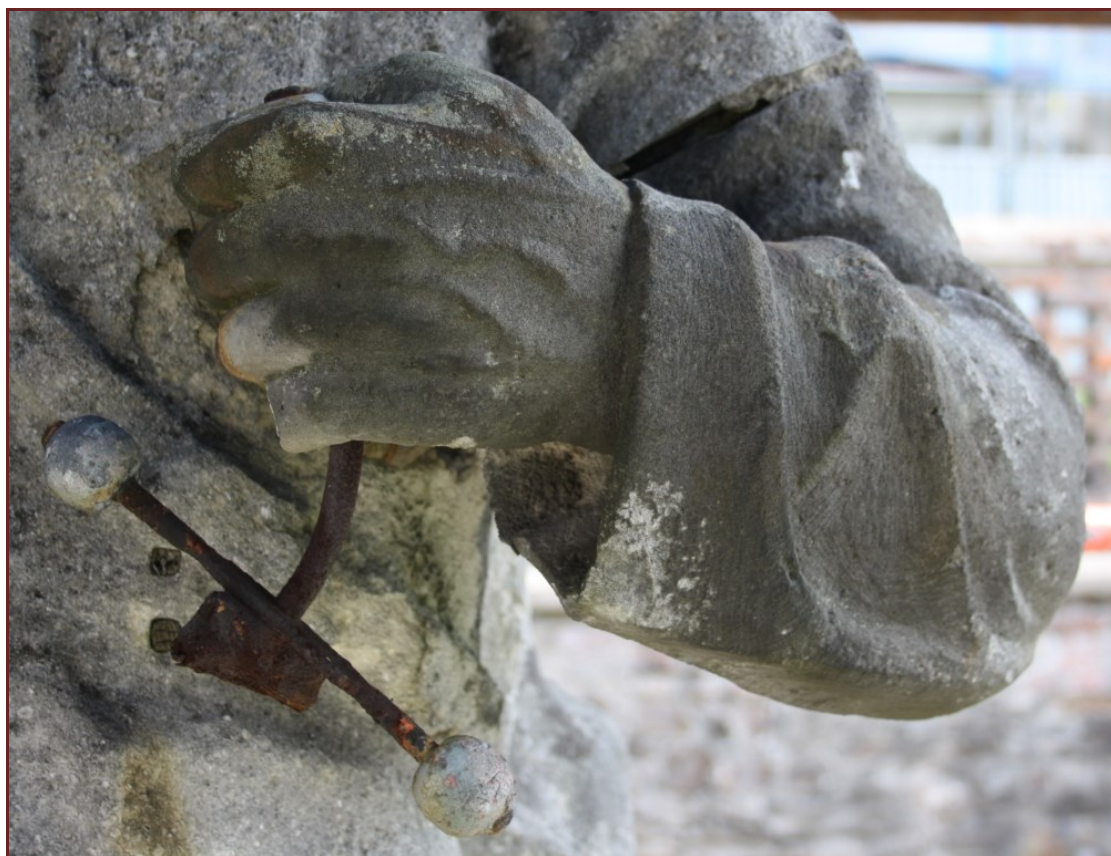
Obrázek 5: Pohled na vložený pískovcový kamenný doplněk levé paže s fragmentem meče (ve sloupku zakřivený jílec).
