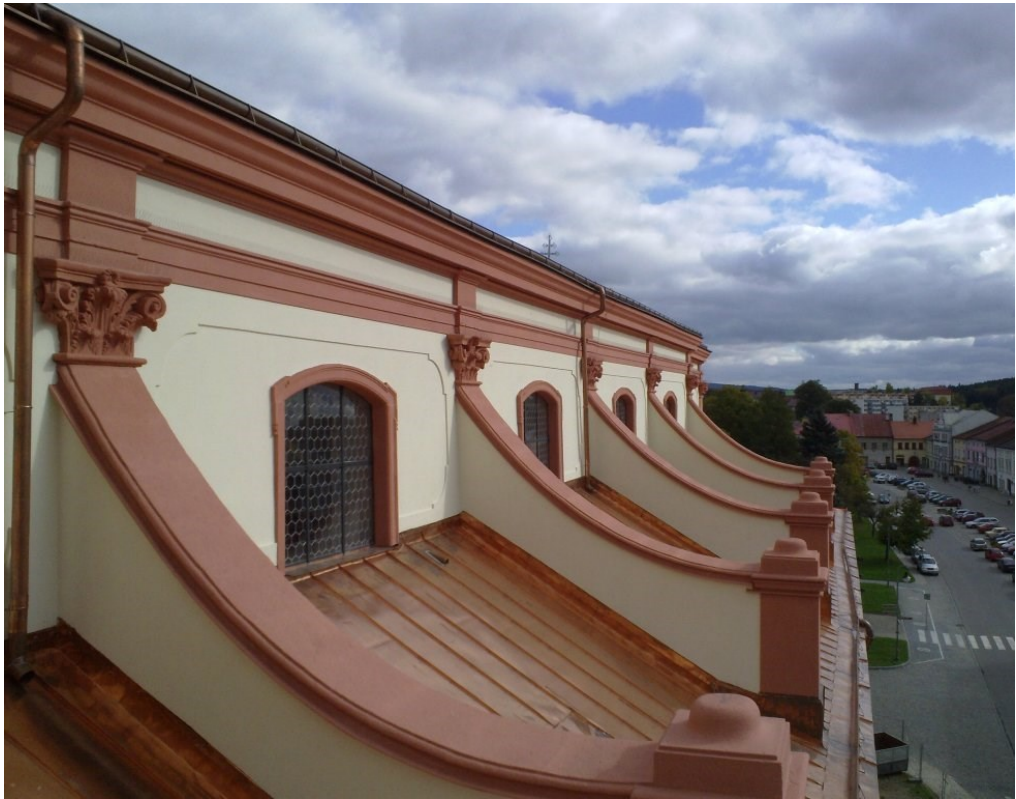
Obrázek 49: Pohled z lešení na jižní stranu v průběhu rekonstrukce, v roce 2011, po obnovení původní barevnosti; podstavce pro osazení soch apoštolů (foto: Müllerová M.).
