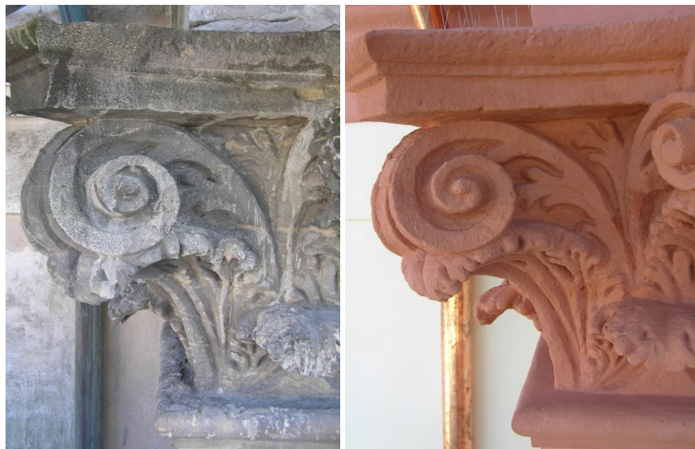
Obrázek 52: Detail hlavice před započítím restaurátorských prací a po jejich dokončení (foto: Müllerová M.) 57
