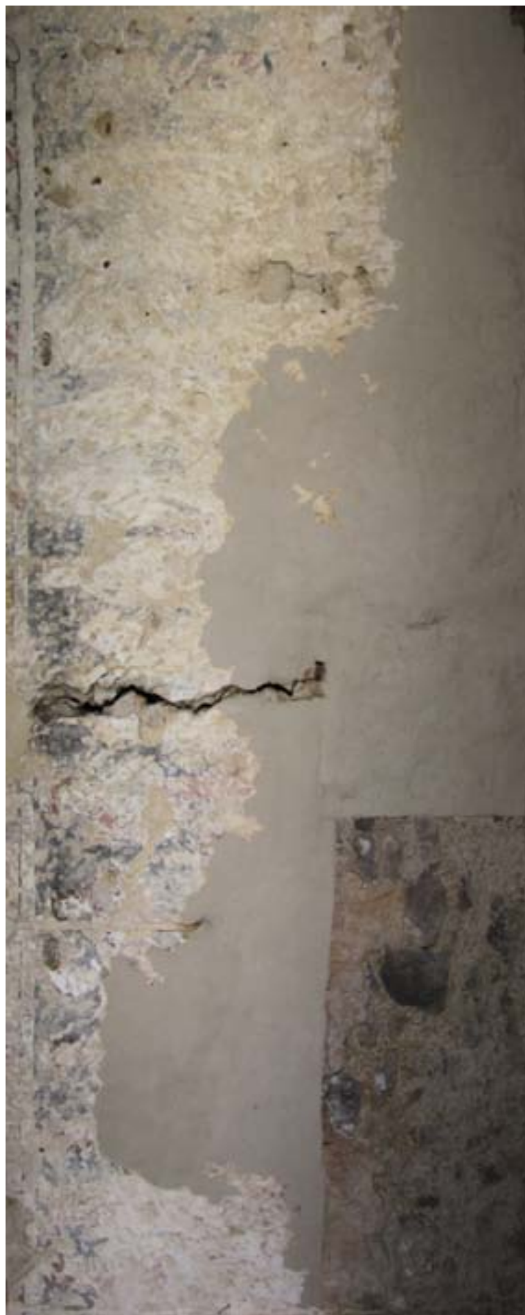
Obr. 35: Průběh redukce soli, celkový pohled. Aplikace odsolovacího advekčního zábalu ve dvou cyklech po 26-28h.
