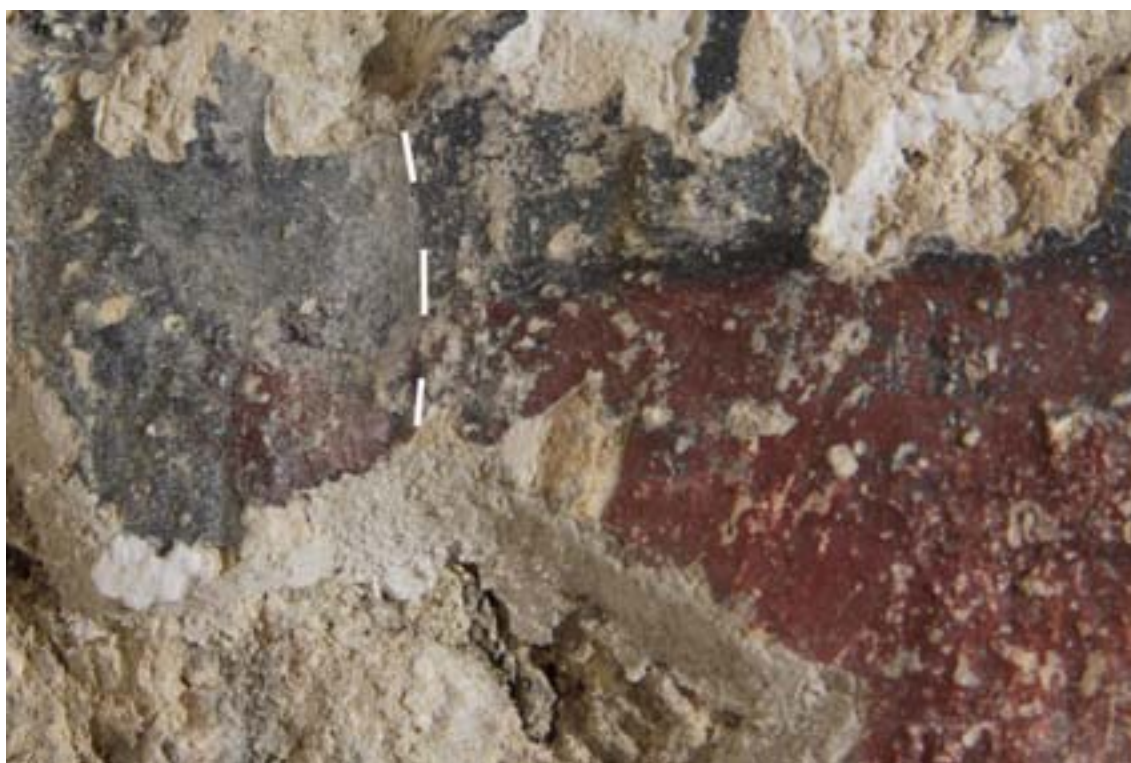
Obr. 33: Průběh čištění pomocí uhličitanu amonného v zábalu. Po sejmutí zábalu následovalo mechanické dočištění bílého zákalu. Vlevo od bílé linie - před mechanickým dočištěním, vpravo - po dočištění.
