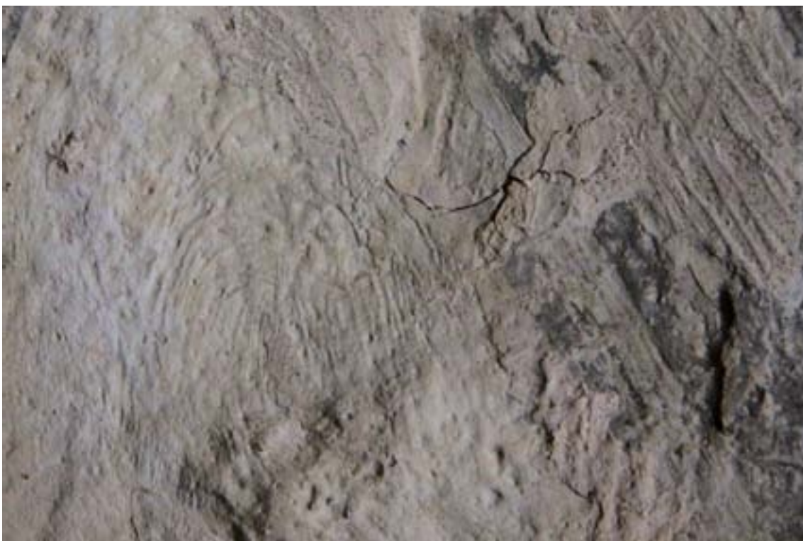
Obr. 14: Pastózní vápenný nátěr na rukávu, detail. Stav po čištění.
