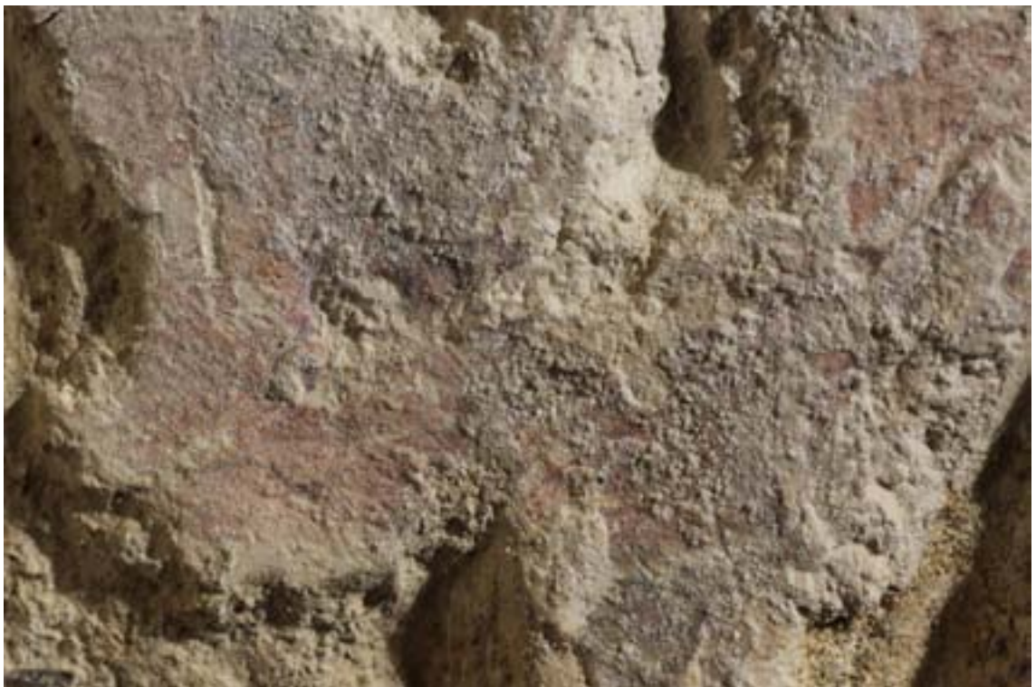
Obr. 23: Povrch barevné vrstvy s bílým zákalem, tvořeným sádrovcem. Lokální výskyt hnědých reziduí mladší omítky, vápna a prachových depozitů, detail. Stav před restaurováním.
