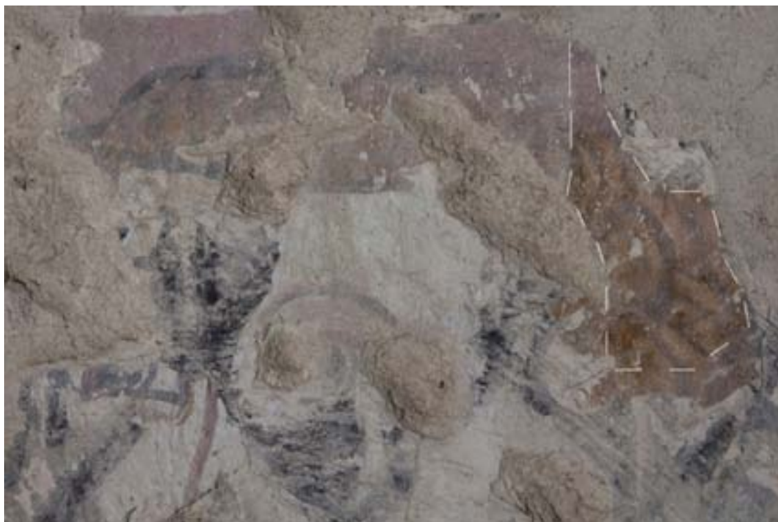
Obr. 32: Zkouška mechanického čištění pomocí houby domol , skalpelu a štětce, detail. Po čištění stále na povrchu barevné vrstvy zůstávají rezidua bílého zákalu.
