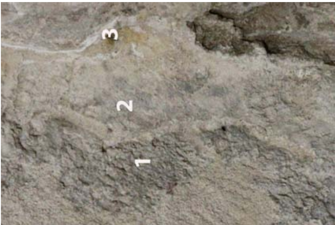
Obr. 17: Dvě omítkové vrstvy - (1) jádrová omítka, (2) jemnější intonaco, (3) okrový fragment barevné vrstvy, detail. Stav po tmelení.
