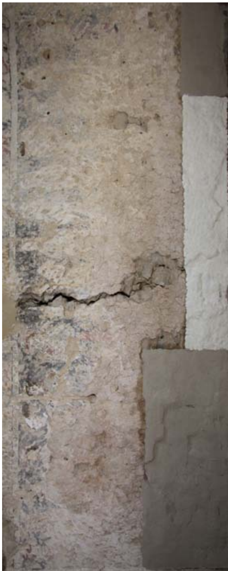
Obr. 34: Průběh redukce solí, celkový pohled. Bílý zábal - aplikace uhlíčitánu amonného v zábalu na cca 4h. Vlevo aplikován do výšky cca 1 m, v pravé části stěny do cca 0,5 m. Šedý zábal - aplikace odsolovacího advekčního zábalu. Aplikován ve dvou cyklech po 26-28h.
