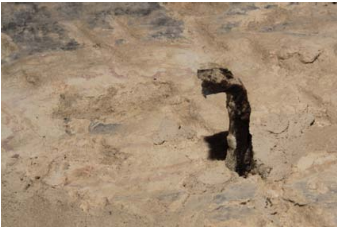
Obr. 21: Kovaná skoba, která byla součástí mladších přízděvek, detail. Stav před restaurováním.
