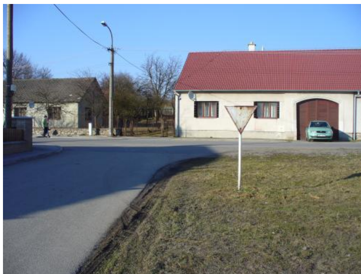
Obrázek 8 Příklad špatně čitelné dopravní značky
