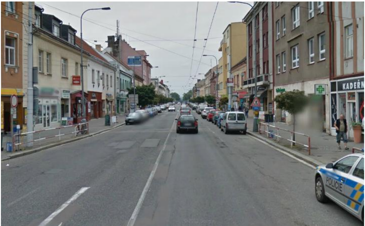
Obrázek 35: Třetí nehodové místo silničního úseku 63,21. – 64,21. km silnice II/324 [36]
