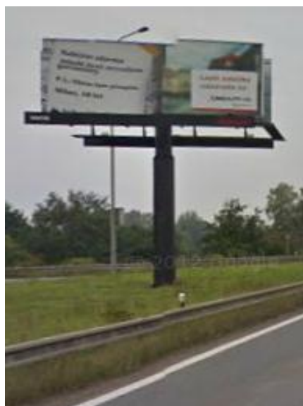
Obrázek 19: Billboard na 1. nehodovém místě 24,29. – 25,29. km silnice I/36 [36]
