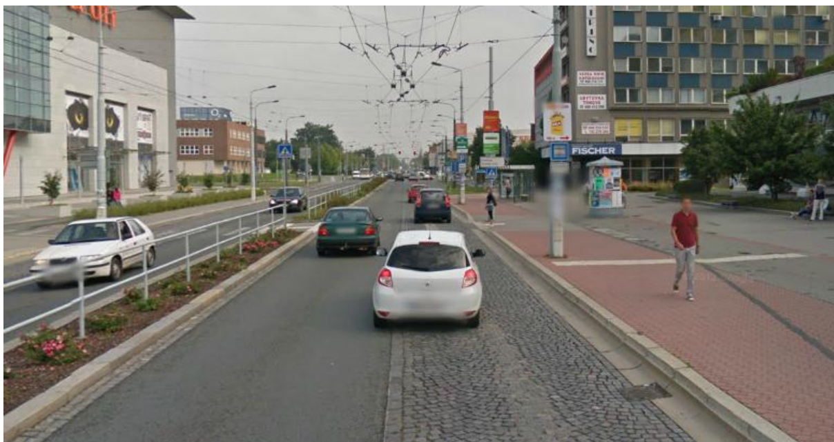
Obrázek 34: Druhé nehodové místo silničního úseku 63,21. – 64,21. km silnice II/324 [36]
