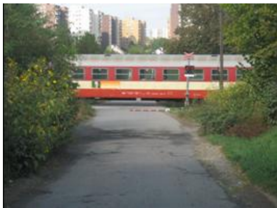
Obr. 11: Užití světelných závor na železničním přejezdu v ČR (provizorní montáž)
