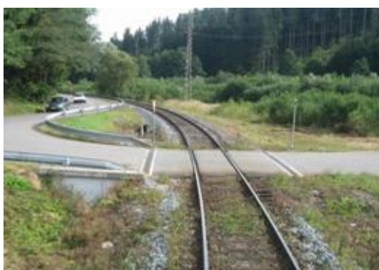
Obr. 13: Betonové příčné odvodňovací žlaby
