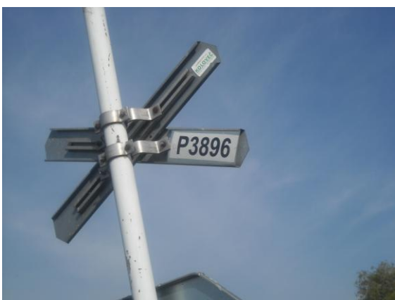
Obr. 3: Označení přejezdu čtyřmístným číslem na výstražném kříži
