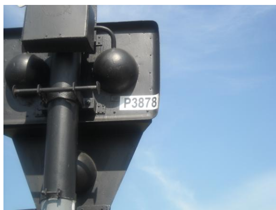
Obr. 4: Označení přejezdu čtyřmístným číslem na výstražníku
