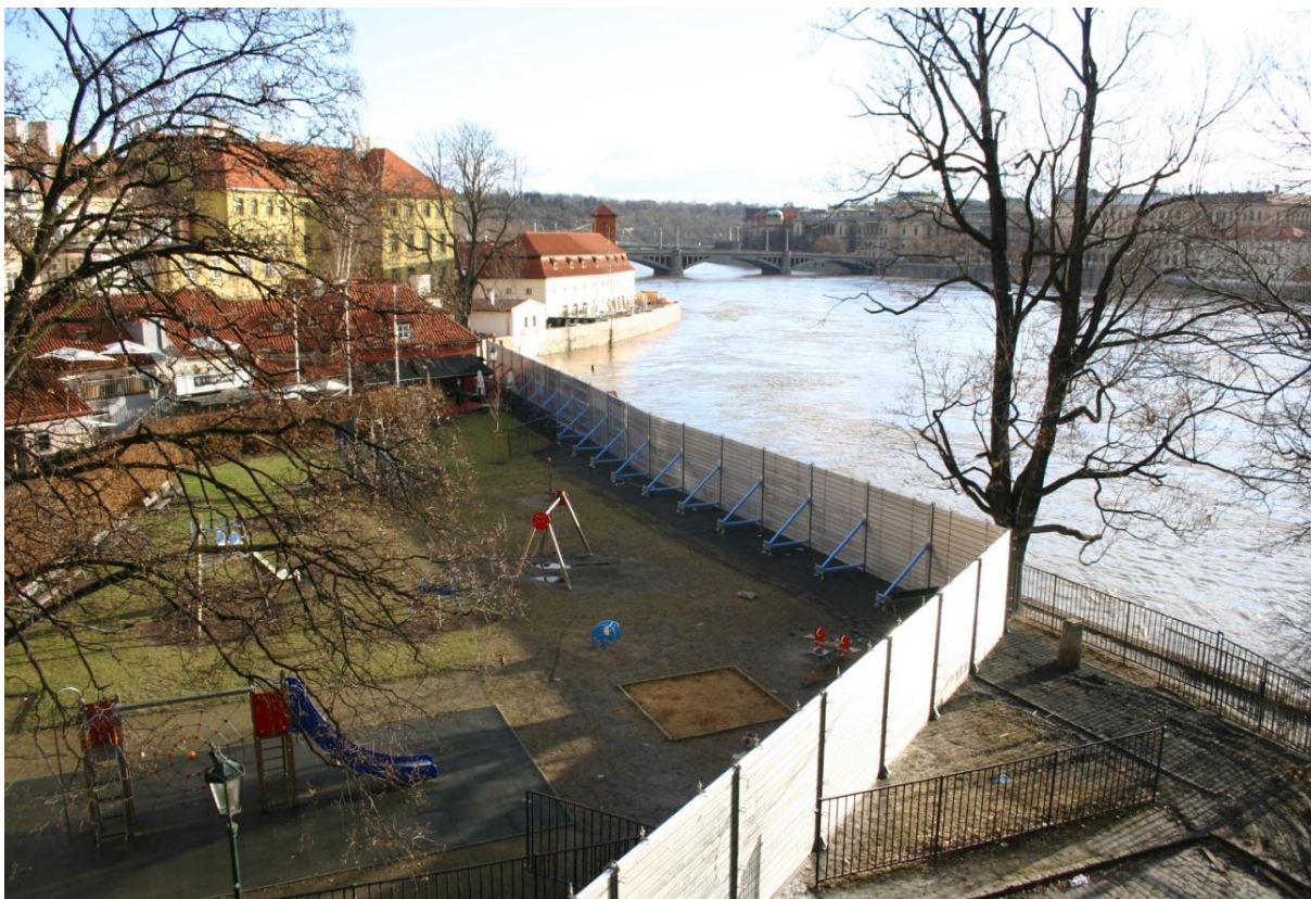
Obrázek 7: Mobilní protipovodňová bariéra na Kampě
