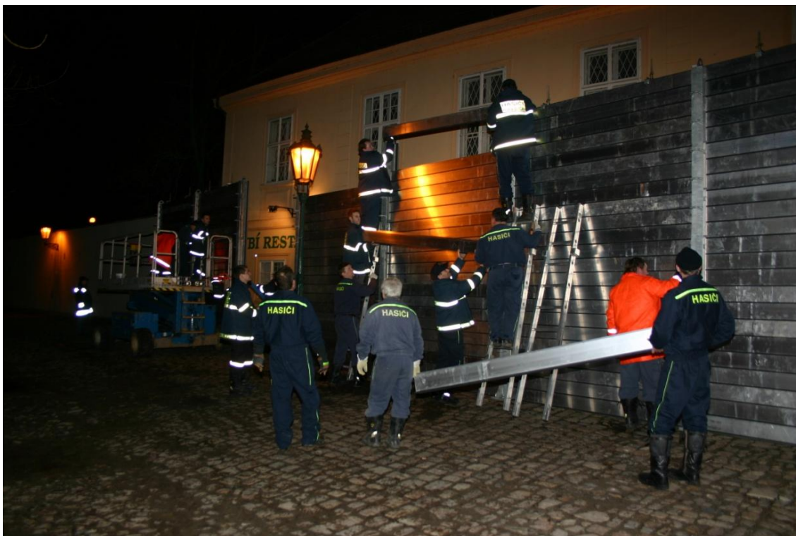
Obrázek 6: Výstavba mobilního protipovodňového hrazení
