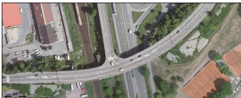
Obrázek 10: Křižovatka na nadjezdu silnice č. 37
