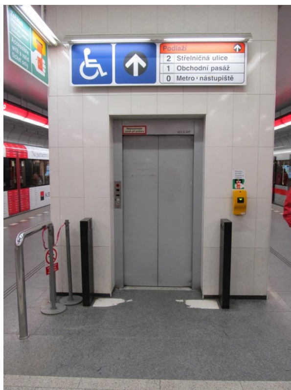
Obrázek 66 Osobní výtah č. 217 – stanice Ládvi
