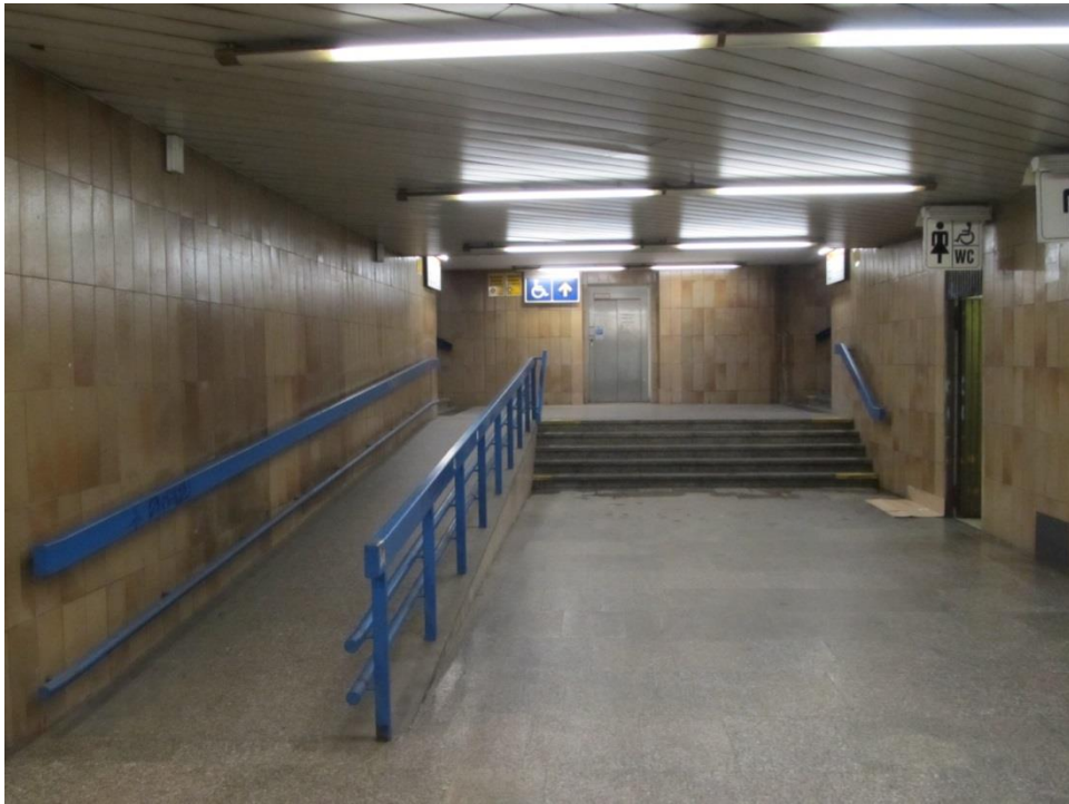
Obrázek 62 Osobní výtah č. 399 – stanice Vltavská
