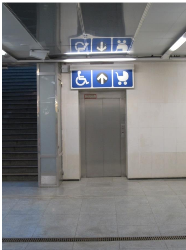
Obrázek 76 Osobní výtah č. 438 – stanice Letňany
