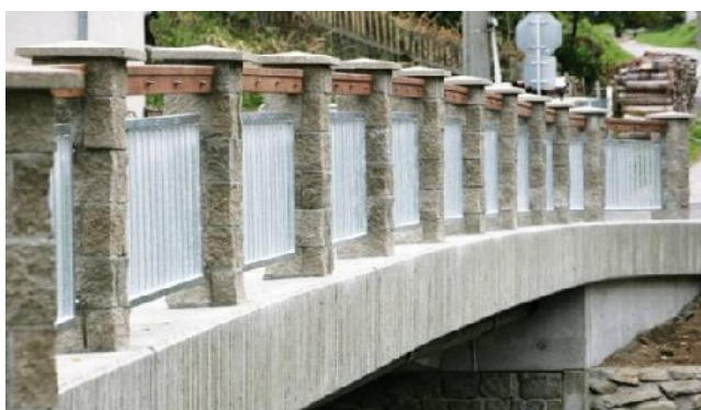
Obr. 54 – Most v Rudolfové ulici v Českých Budějovicích [42]
