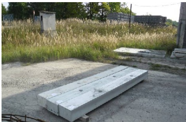
Obr. 98 – Zcela odformované trámy
