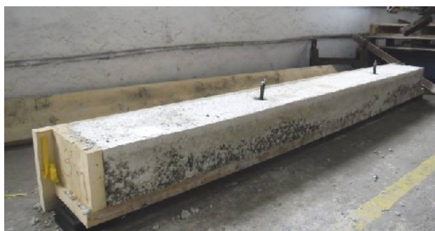
Obr. 94 – Částečně odformovaný trám 3N+D
