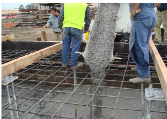
Obr. 44 – Austrálie, fa. Zeobond – betonáž základů sila [35]
