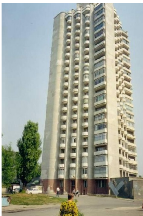
Obr. 36 – Lipetsk, Rusko(1987-1989) - dvacetipodlažní dům vyrobený z alkalicky aktivovaného struskového betonu – kontrola v roce 1999 [34]
