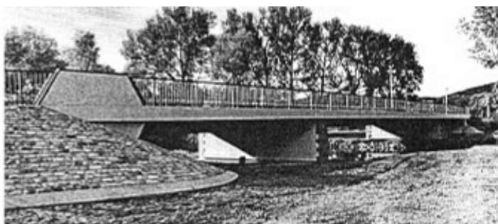
Obr. 60 – Most přes Ploučnici ve Stružnici [53]
