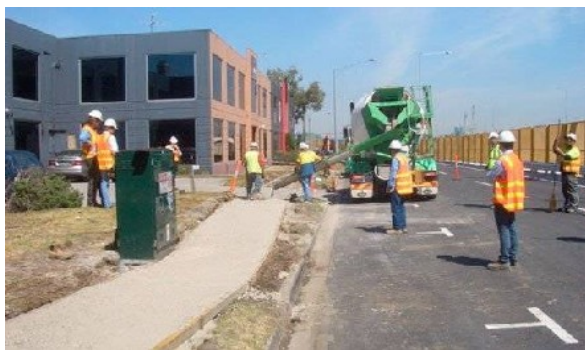
Obr. 43 – Port Melbourne, Victoria, Austrálie – E-beton alkalicky aktivovaný popílkový beton (pevnost 25 MPa) [35]
