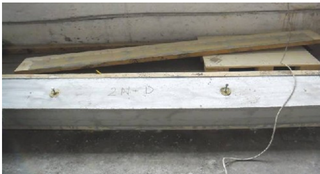
Obr. 93 – Částečně odformovaný trám 2N+D
