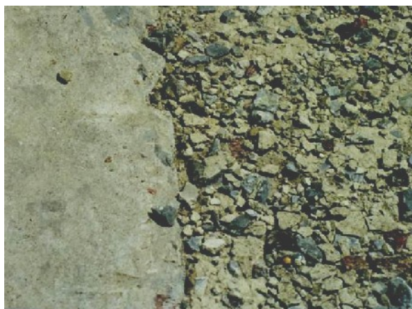
Obr. 41 – Ternopol, Ukrajina (1984) – porovnání části vozovky z alkalicky aktivovaného struskového betonu (vlevo) a klasického betonu na bázi portlandského cementu (vpravo) [34]
