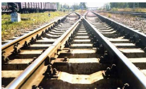
Obr. 38 – Trať Moskva - St. Petěrburg, Rusko - železniční pražce z alkalicky aktivovaného struskového betonu (1989) – kontrola v roce 1999 [34]
