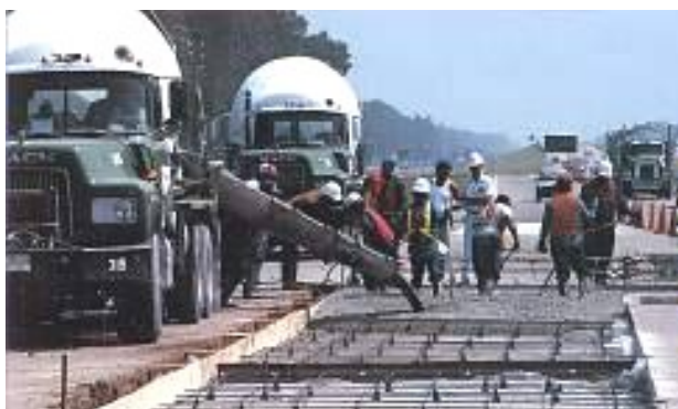
Obr. 42 – USA – betonování přistávací dráhy pomocí alkalicky aktivovaného betonu Pyrament [9]
