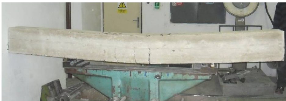
Obr. 119 – Viditelné prohnutí trámu
