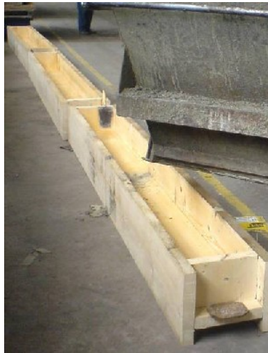
Obr. 71 – Dřevěné formy na trámy
