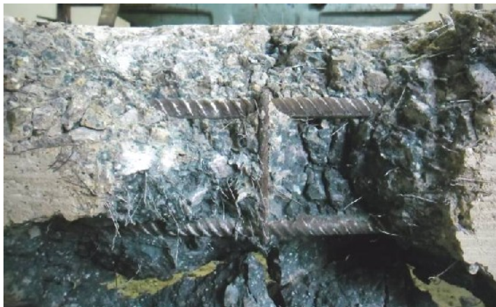
Obr. 120 – Detail třmínku a výztuže
