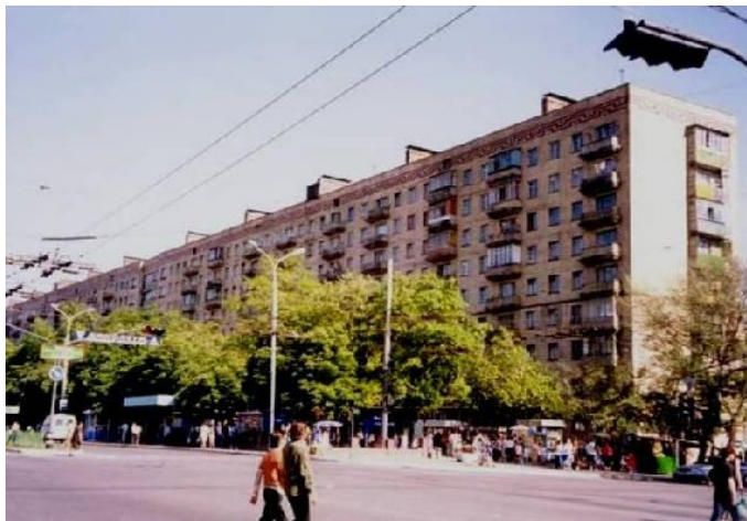
Obr. 35 – Mariupol, Ukrajina (1960) - devítipodlažní dům vyrobený z alkalicky aktivovaného struskového betonu – kontrola v roce 2000 [34]
