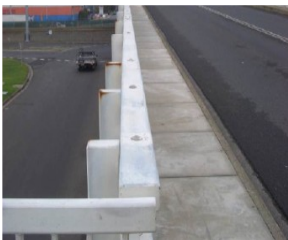
Obr. 45 – Port Melbourne, Victoria, Austrálie – E-beton prefabrikované panely přes most - alkalicky aktivovaný popílkový beton (pevnost 55 MPa) [35]
