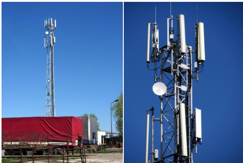
Obrázek 10 - Příhradový stožár na okraji obce Srch (10)
